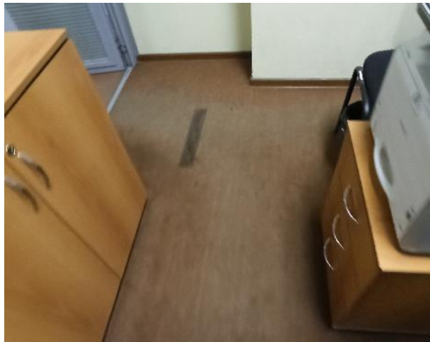
Фотография 75. Внутреннее состояние помещений — 7 этаж
