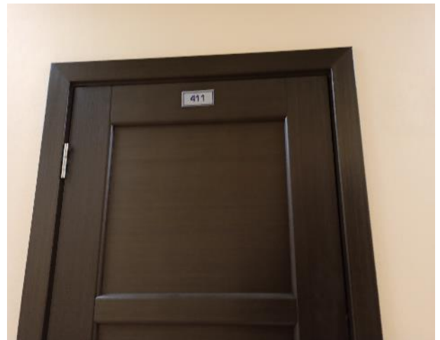
Фотография 172. Внутреннее состояние помещений — 4 этаж
