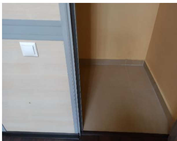
Фотография 216. Внутреннее состояние помещений — 4 этаж
