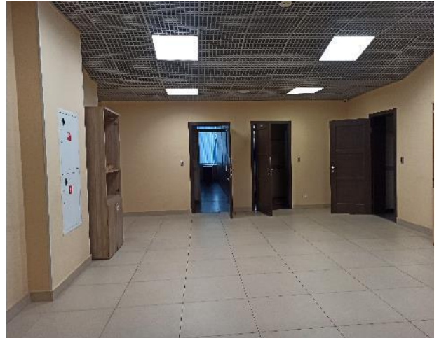
Фотография 194. Внутреннее состояние помещений — 4 этаж
