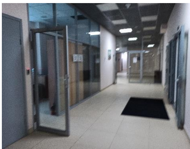
Фотография 47. Внутреннее состояние помещений — 3 этаж
