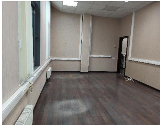
Фотография 64. Внутреннее состояние помещений — 3 этаж
