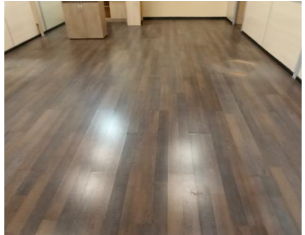
Фотография 182. Внутреннее состояние помещений — 4 этаж
