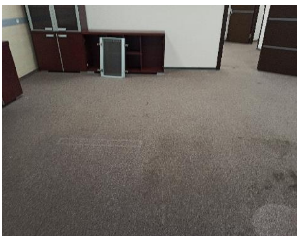
Фотография 83. Внутреннее состояние помещений — 3 этаж
