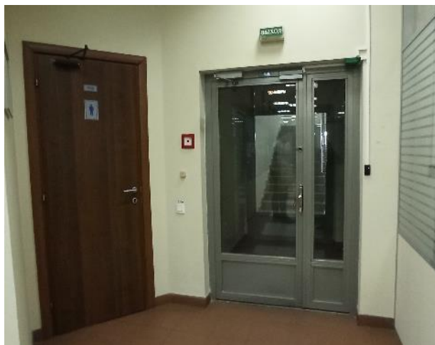
Фотография 89. Внутреннее состояние помещений — 7 этаж
