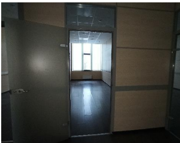
Фотография 209. Внутреннее состояние помещений — 4 этаж
