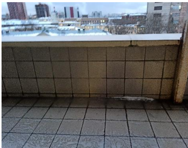
Фотография 56. Внутреннее состояние помещений — 7 этаж
