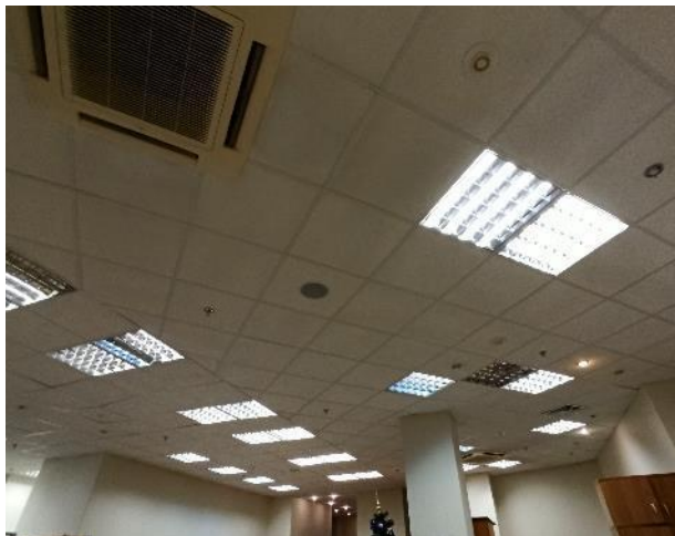
Фотография 20. Внутреннее состояние помещений — 6 этаж
