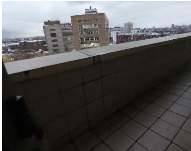
Фотография 195. Внутреннее состояние помещений — 9 этаж
