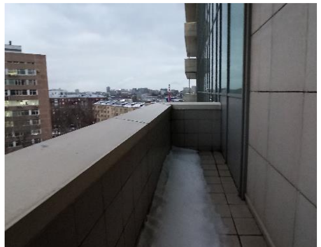
Фотография 100. Внутреннее состояние помещений — 8 этаж
