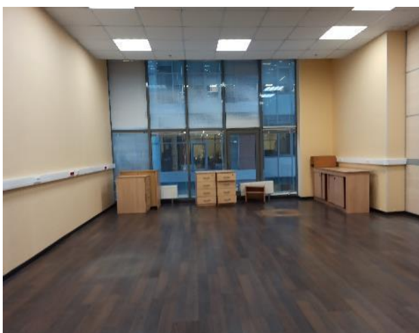
Фотография 167. Внутреннее состояние помещений — 4 этаж
