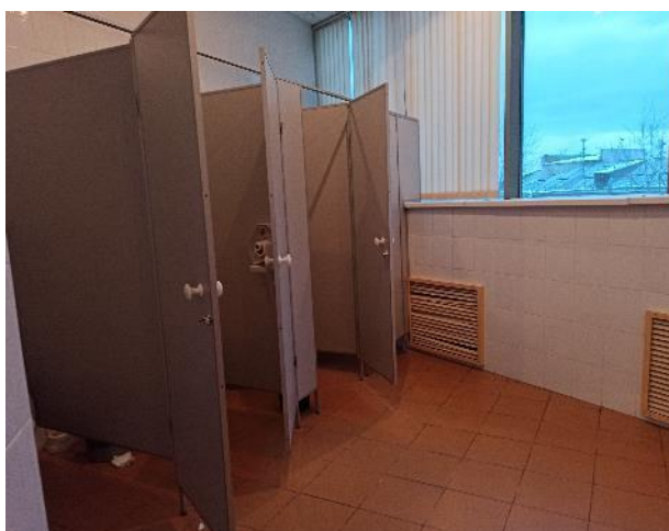
Фотография 48. Внутреннее состояние помещений — 6 этаж
