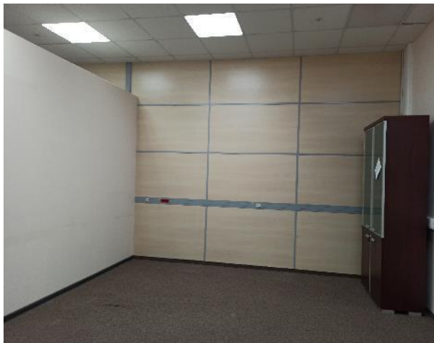
Фотография 80. Внутреннее состояние помещений — 3 этаж
