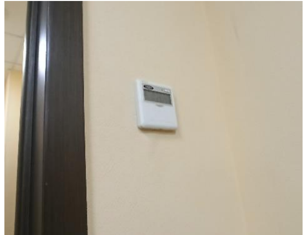
Фотография 146. Внутреннее состояние помещений — 4 этаж
