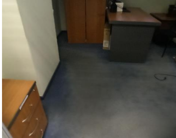
Фотография 116. Внутреннее состояние помещений — 8 этаж
