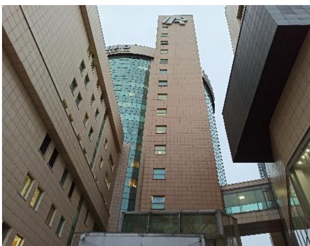
Фотография 215. Внешний вид здания
