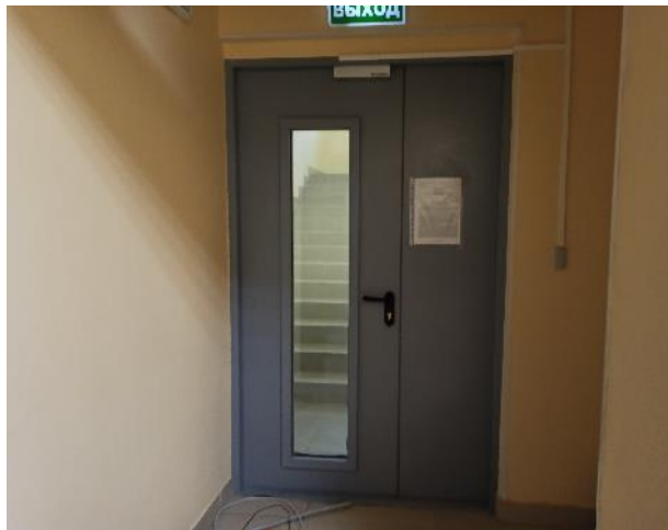
Фотография 231. Внутреннее состояние помещений — 4 этаж
