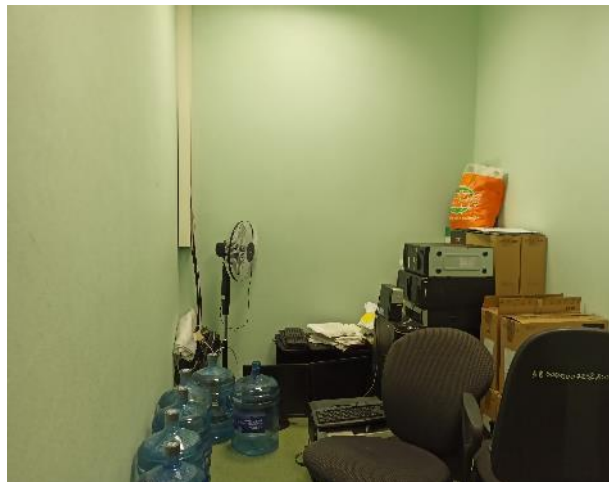
Фотография 170. Внутреннее состояние помещений — 9 этаж
