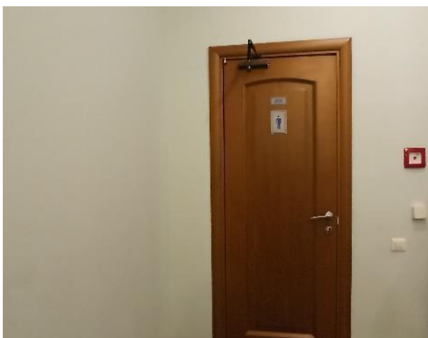
Фотография 203. Внутреннее состояние помещений — 9 этаж
