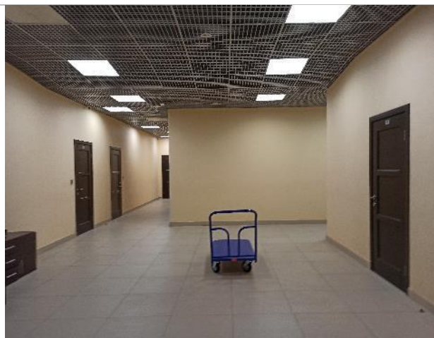
Фотография 31. Внутреннее состояние помещений — 4 этаж
