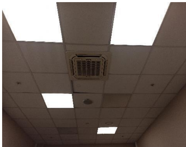
Фотография 56. Внутреннее состояние помещений — 3 этаж
