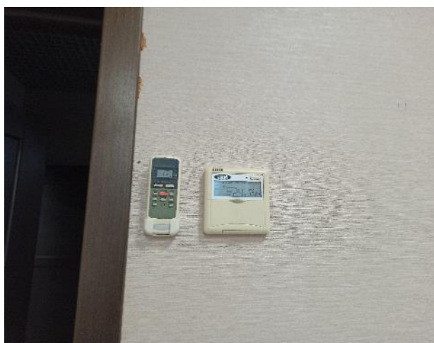
Фотография 57. Внутреннее состояние помещений — 3 этаж
