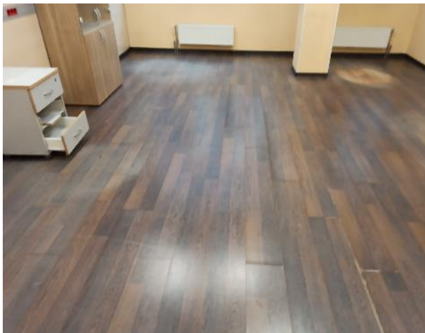
Фотография 235. Внутреннее состояние помещений — 4 этаж
