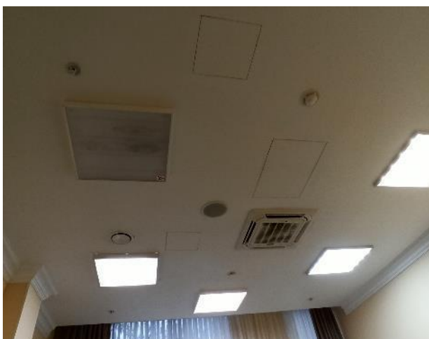
Фотография 131. Внутреннее состояние помещений — 4 этаж
