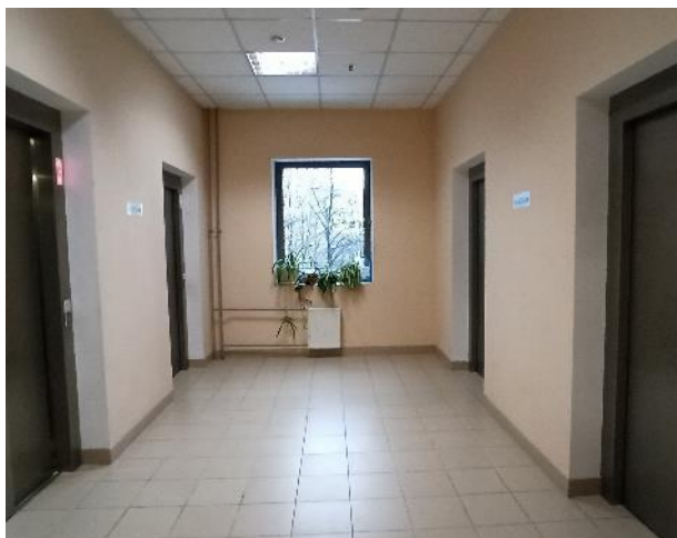
Фотография 92. Внутреннее состояние помещений — 4 этаж
