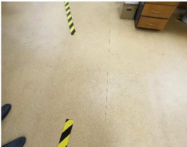
Фотография 19. Внутреннее состояние помещений — 6 этаж
