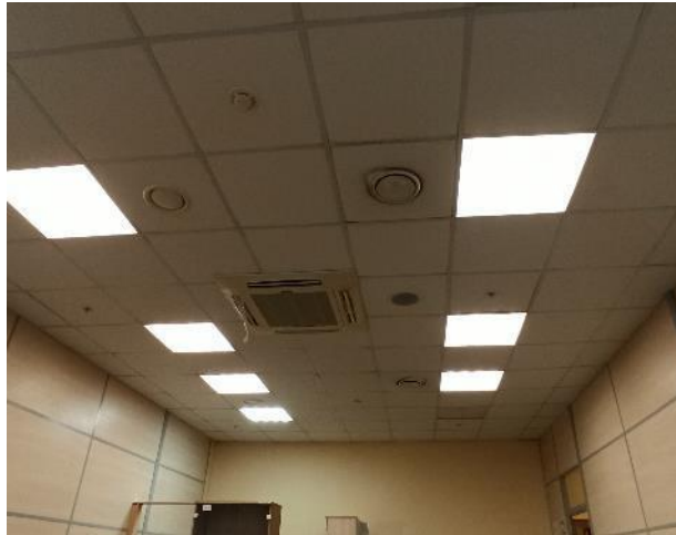
Фотография 181. Внутреннее состояние помещений — 4 этаж
