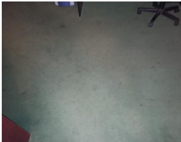
Фотография 183. Внутреннее состояние помещений — 9 этаж
