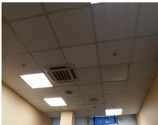
Фотография 149. Внутреннее состояние помещений — 4 этаж
