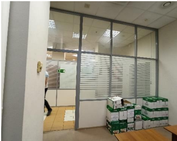
Фотография 27. Внутреннее состояние помещений — 6 этаж
