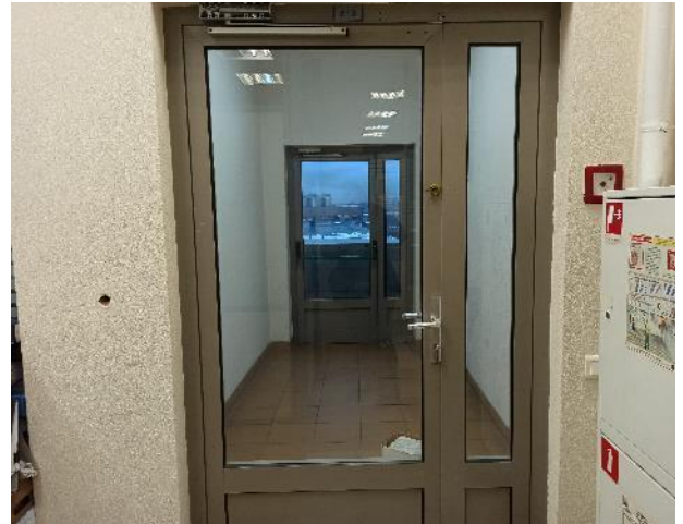
Фотография 50. Внутреннее состояние помещений — 6 этаж
