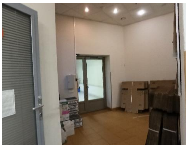
Фотография 33. Внутреннее состояние помещений — 6 этаж
