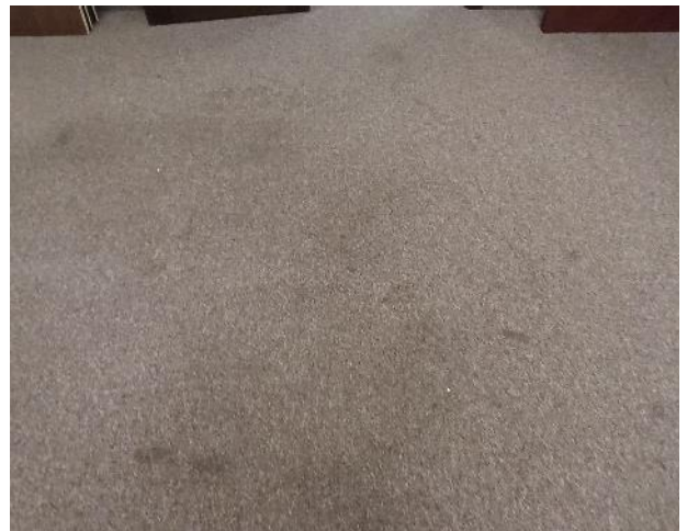
Фотография 100. Внутреннее состояние помещений — 4 этаж
