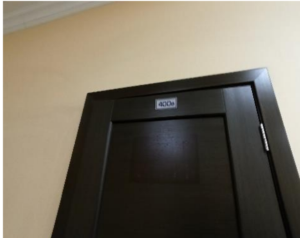
Фотография 241. Внутреннее состояние помещений — 4 этаж
