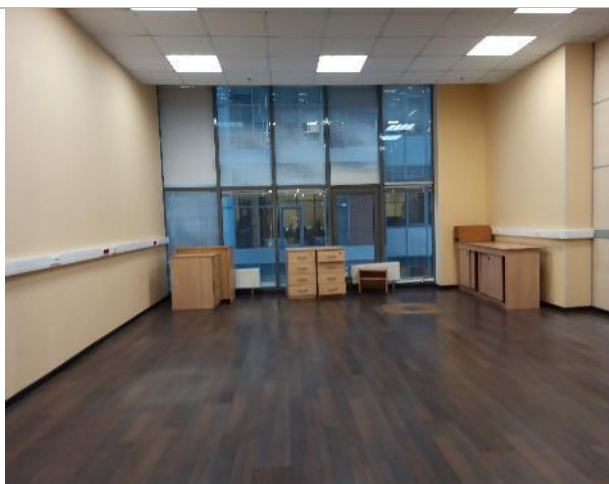
Фотография 34. Внутреннее состояние помещений — 4 этаж
