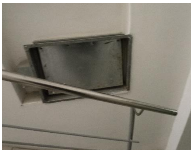
Фотография 95. Внутреннее состояние помещений — 8 этаж
