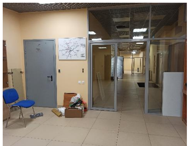
Фотография 258. Внутреннее состояние помещений — 4 этаж
