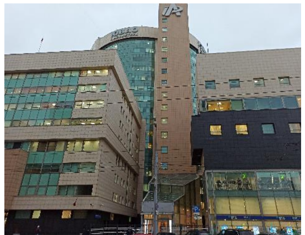
Фотография 210. Внешний вид здания
