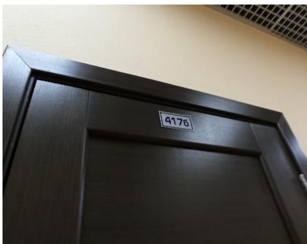
Фотография 154. Внутреннее состояние помещений — 4 этаж
