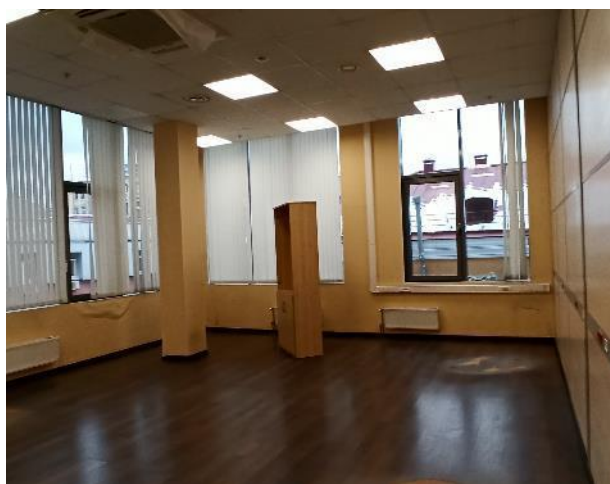
Фотография 185. Внутреннее состояние помещений — 4 этаж
