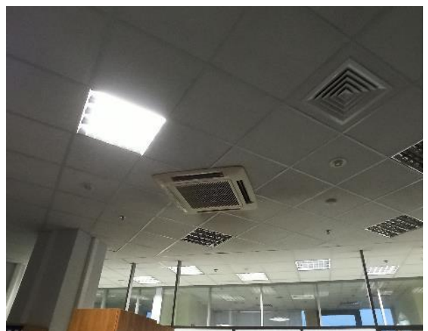
Фотография 114. Внутреннее состояние помещений — 8 этаж
