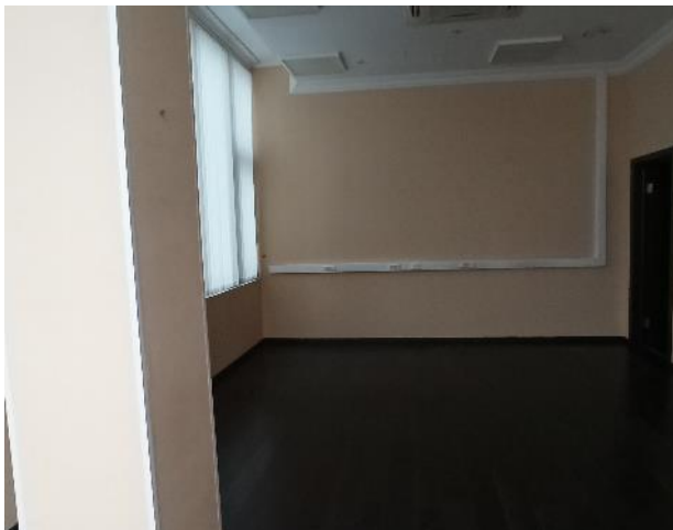
Фотография 127. Внутреннее состояние помещений — 4 этаж
