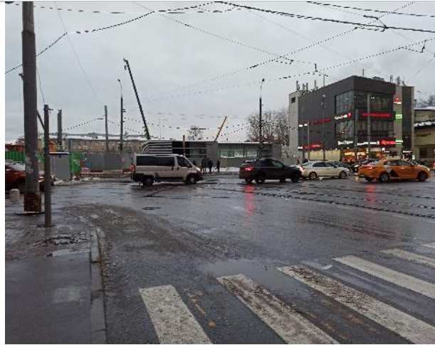
Фотография 1. Подъездные пути
