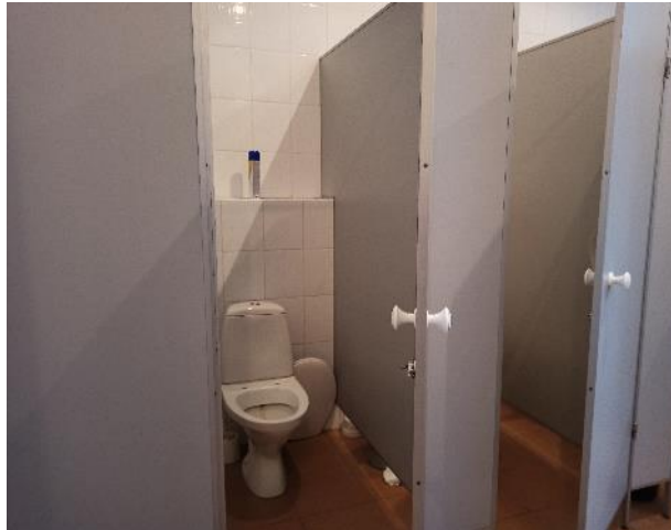
Фотография 49. Внутреннее состояние помещений — 6 этаж
