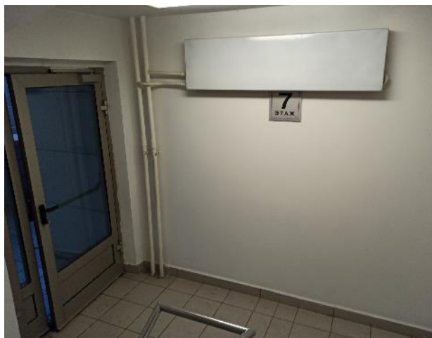
Фотография 55. Внутреннее состояние помещений — 7 этаж
