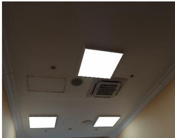
Фотография 248. Внутреннее состояние помещений — 4 этаж
