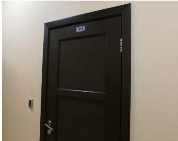
Фотография 109. Внутреннее состояние помещений — 4 этаж
