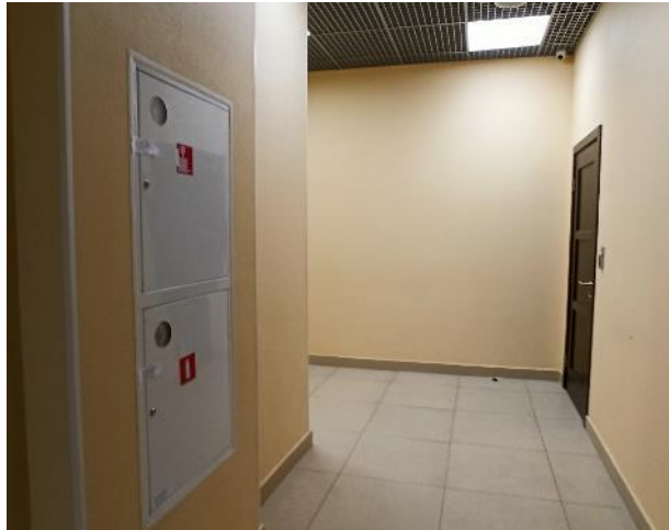
Фотография 157. Внутреннее состояние помещений — 4 этаж
