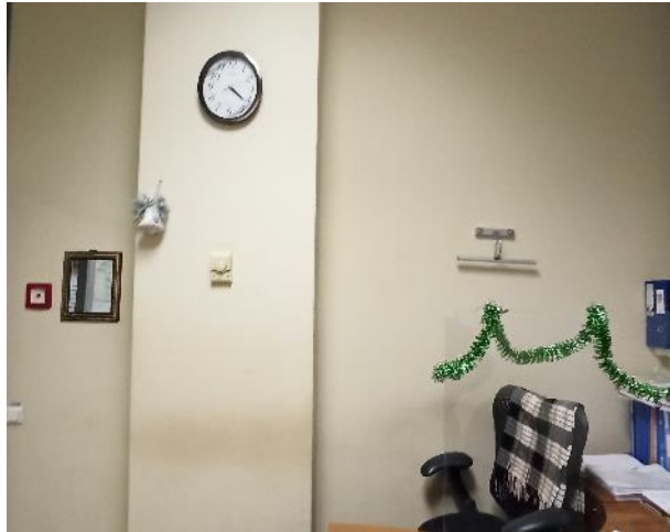
Фотография 73. Внутреннее состояние помещений — 7 этаж
