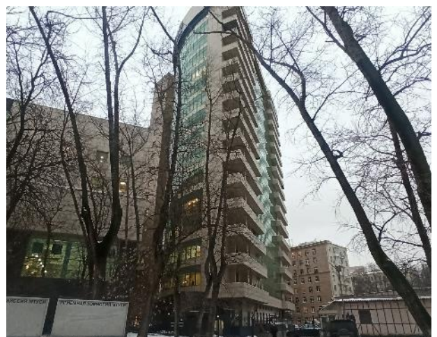
Фотография 222. Внешний вид здания
