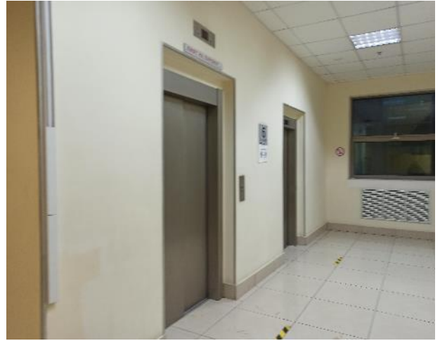
Фотография 2. Внутреннее состояние помещений — 6 этаж
