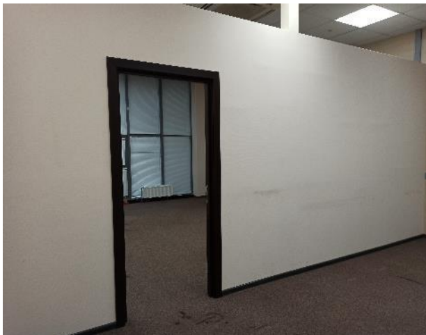
Фотография 79. Внутреннее состояние помещений — 3 этаж
