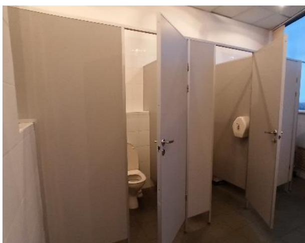
Фотография 192. Внутреннее состояние помещений — 9 этаж
