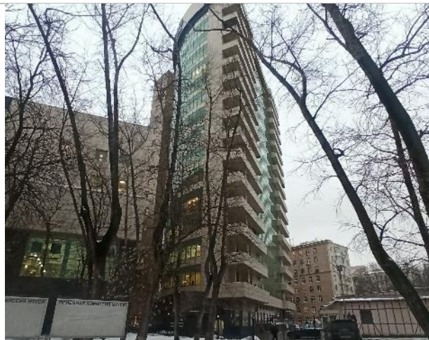
Фотография 3. Внешний вид здания
