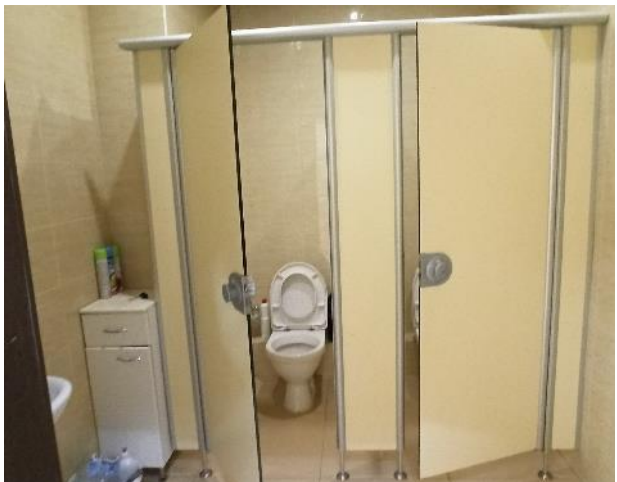
Фотография 103. Внутреннее состояние помещений — 4 этаж
