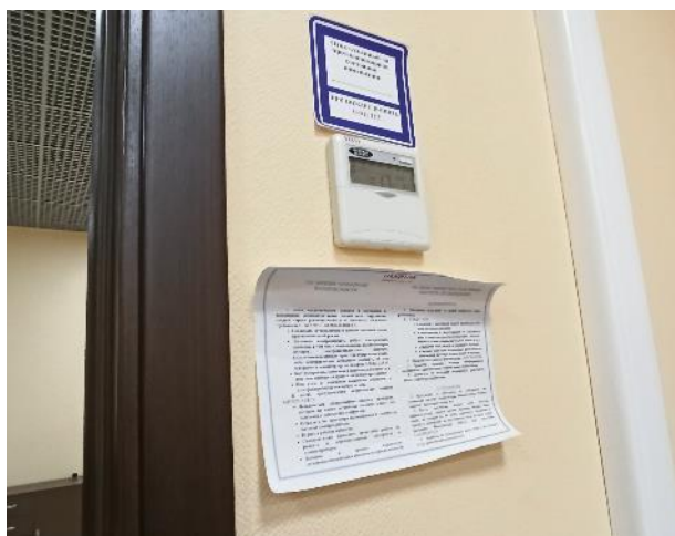
Фотография 101. Внутреннее состояние помещений — 4 этаж
