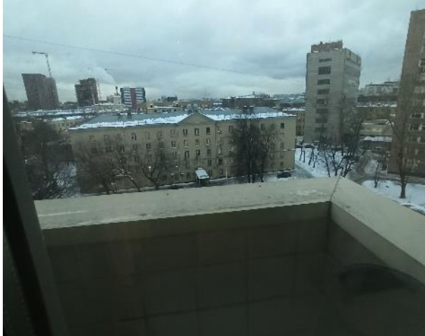
Фотография 25. Внутреннее состояние помещений — 6 этаж
