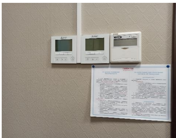
Фотография 45. Внутреннее состояние помещений — 2 этаж
