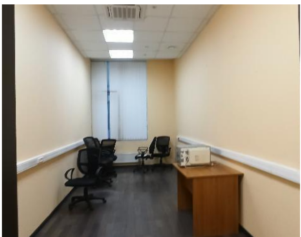
Фотография 105. Внутреннее состояние помещений — 4 этаж
