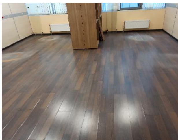
Фотография 227. Внутреннее состояние помещений — 4 этаж
