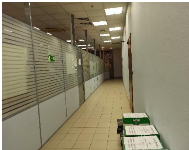
Фотография 120. Внутреннее состояние помещений — 8 этаж
