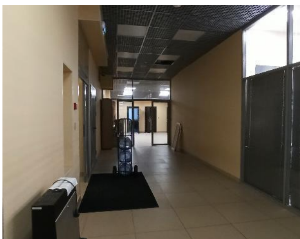
Фотография 94. Внутреннее состояние помещений — 4 этаж
