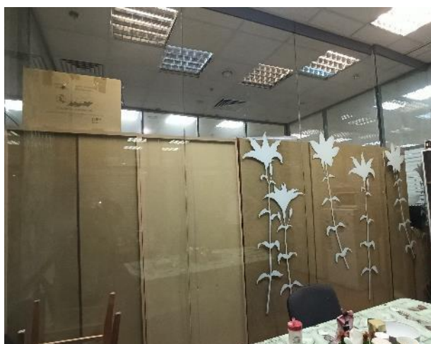
Фотография 65. Внутреннее состояние помещений — 7 этаж
