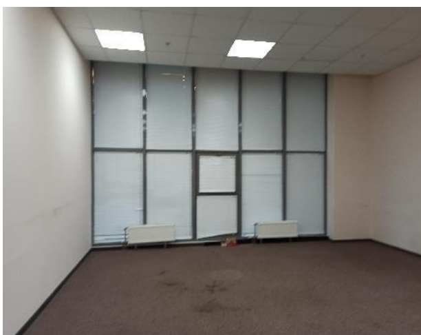
Фотография 81. Внутреннее состояние помещений — 3 этаж
