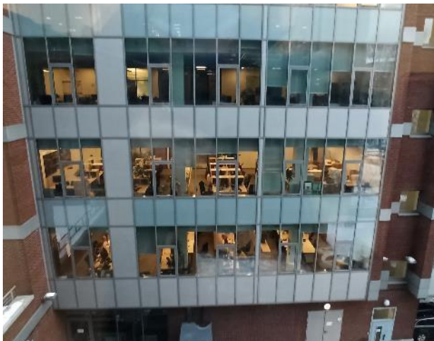
Фотография 151. Внутреннее состояние помещений — 4 этаж
