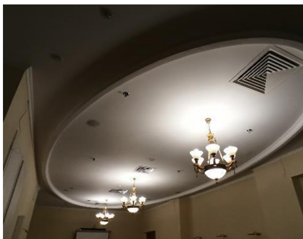
Фотография 141. Внутреннее состояние помещений — 9 этаж
