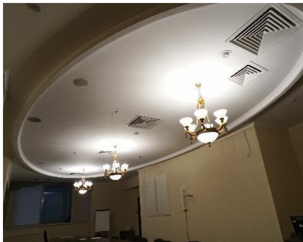
Фотография 147. Внутреннее состояние помещений — 9 этаж
