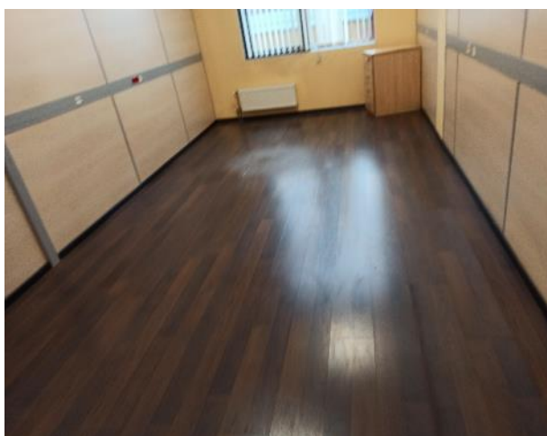
Фотография 190. Внутреннее состояние помещений — 4 этаж
