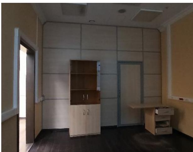
Фотография 117. Внутреннее состояние помещений — 4 этаж
