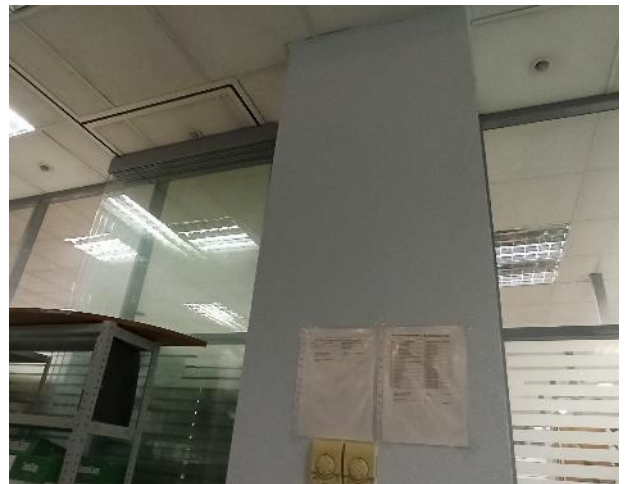
Фотография 124. Внутреннее состояние помещений — 8 этаж
