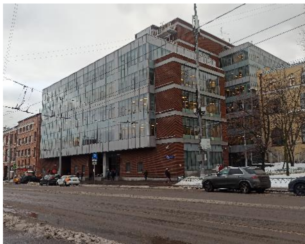
Фотография 5. Внешний вид здания
