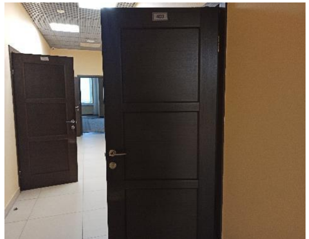
Фотография 208. Внутреннее состояние помещений — 4 этаж
