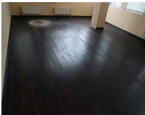
Фотография 125. Внутреннее состояние помещений — 4 этаж
