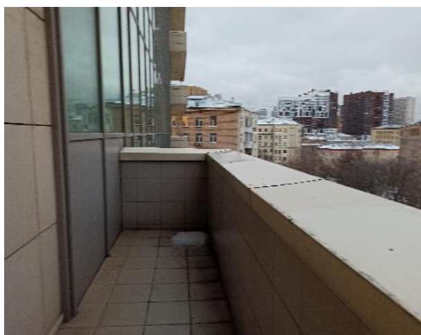
Фотография 53. Внутреннее состояние помещений — 6 этаж
