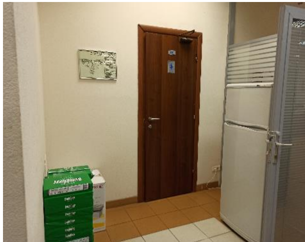
Фотография 39. Внутреннее состояние помещений — 6 этаж
