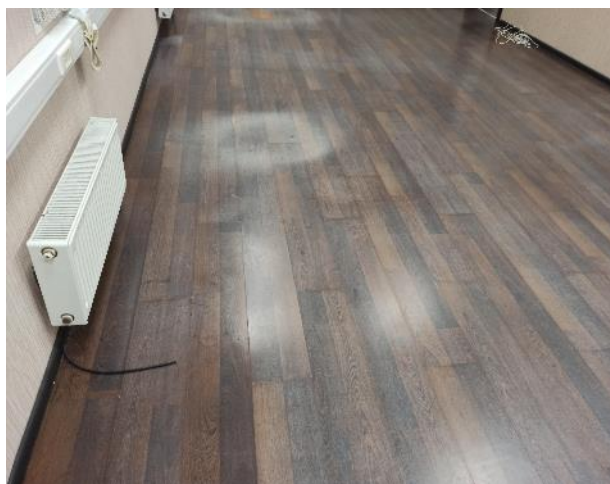
Фотография 65. Внутреннее состояние помещений — 3 этаж
