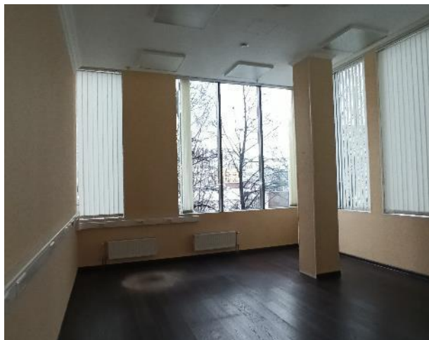
Фотография 123. Внутреннее состояние помещений — 4 этаж
