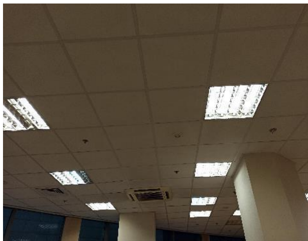
Фотография 43. Внутреннее состояние помещений — 6 этаж
