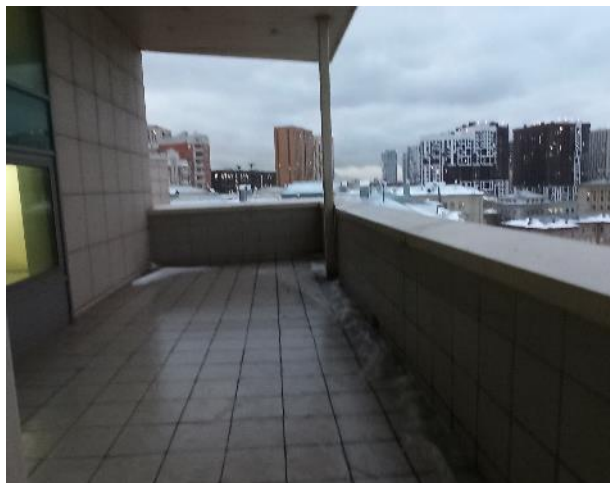
Фотография 99. Внутреннее состояние помещений — 8 этаж
