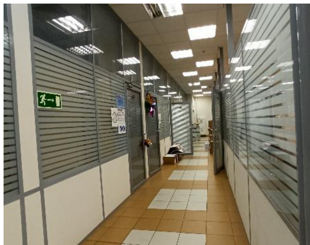
Фотография 14. Внутреннее состояние помещений — 6 этаж
