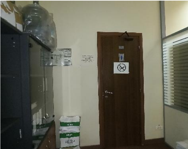
Фотография 67. Внутреннее состояние помещений — 7 этаж
