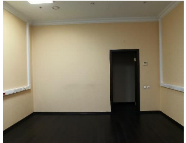
Фотография 134. Внутреннее состояние помещений — 4 этаж
