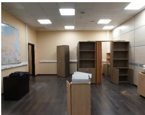
Фотография 144. Внутреннее состояние помещений — 4 этаж
