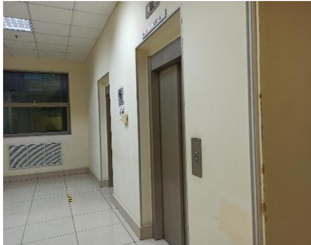
Фотография 3. Внутреннее состояние помещений — 6 этаж
