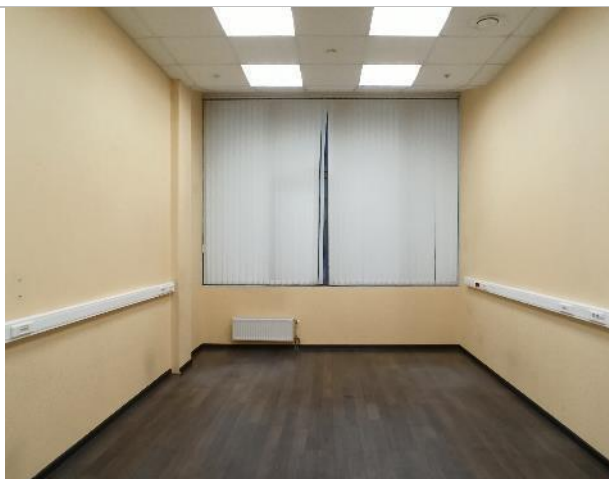
Фотография 32. Внутреннее состояние помещений — 4 этаж
