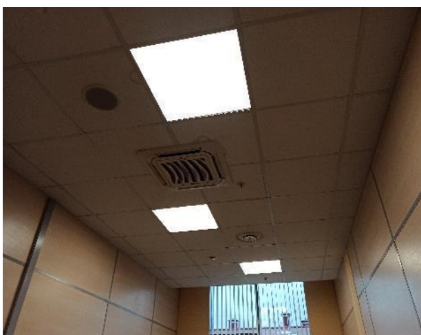
Фотография 189. Внутреннее состояние помещений — 4 этаж
