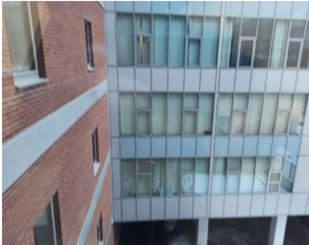
Фотография 205. Внутреннее состояние помещений — 4 этаж
