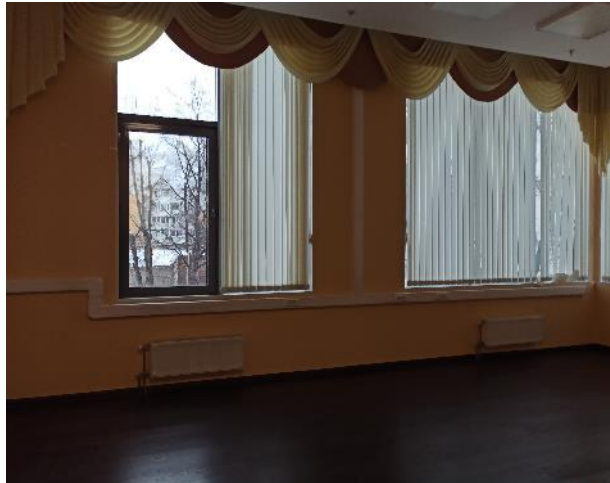
Фотография 253. Внутреннее состояние помещений — 4 этаж
