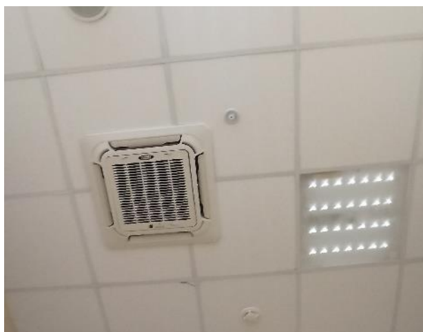
Фотография 177. Внутреннее состояние помещений — 4 этаж
