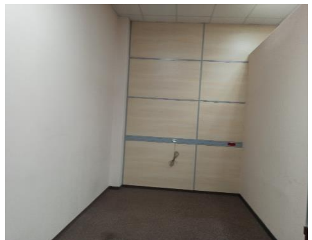
Фотография 78. Внутреннее состояние помещений — 3 этаж
