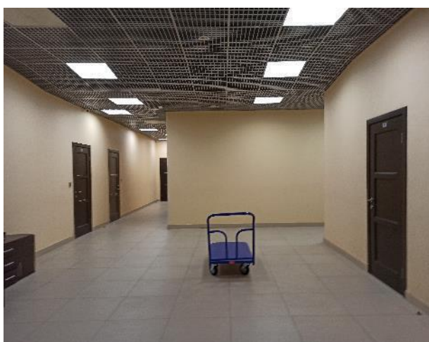
Фотография 96. Внутреннее состояние помещений — 4 этаж
