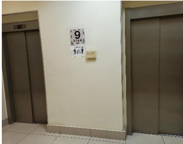
Фотография 133. Внутреннее состояние помещений — 9 этаж
