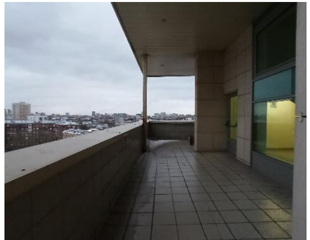
Фотография 196. Внутреннее состояние помещений — 9 этаж
