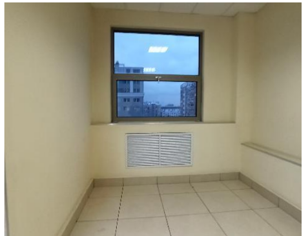
Фотография 136. Внутреннее состояние помещений — 9 этаж
