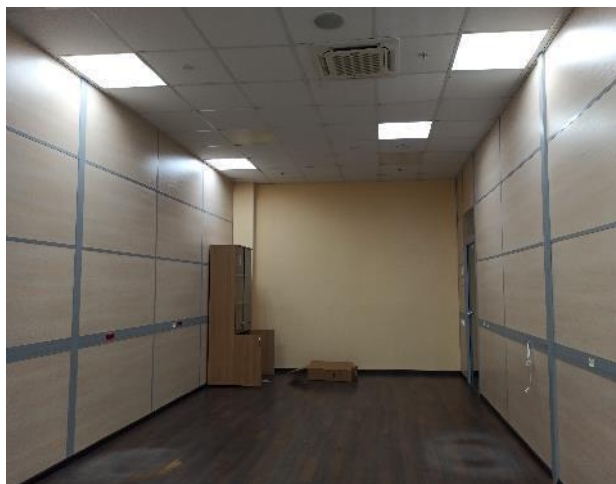
Фотография 223. Внутреннее состояние помещений — 4 этаж
