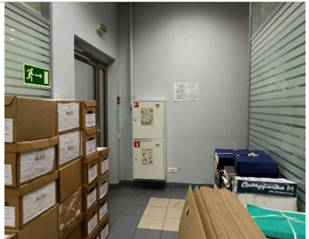
Фотография 16. Внутреннее состояние помещений — 8 этаж
