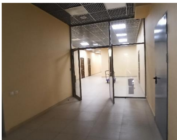
Фотография 93. Внутреннее состояние помещений — 4 этаж
