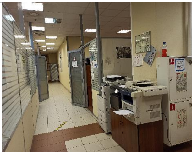
Фотография 10. Внутреннее состояние помещений — 7 этаж
