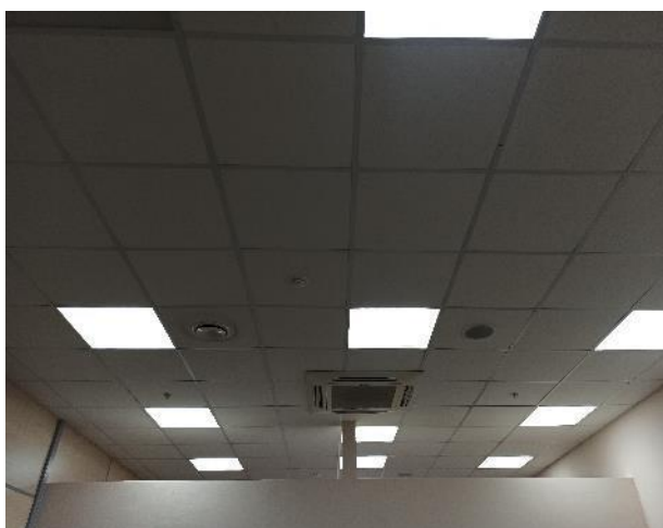
Фотография 84. Внутреннее состояние помещений — 3 этаж
