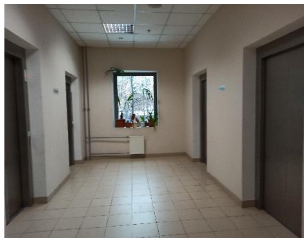
Фотография 90. Внутреннее состояние помещений — 3 этаж
