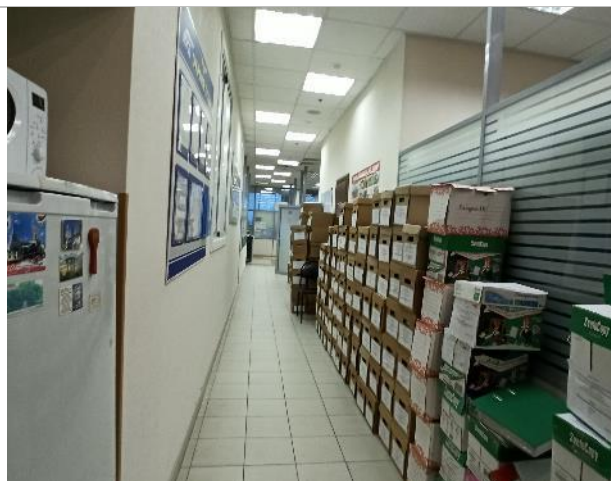
Фотография 5. Внутреннее состояние помещений — 6 этаж
