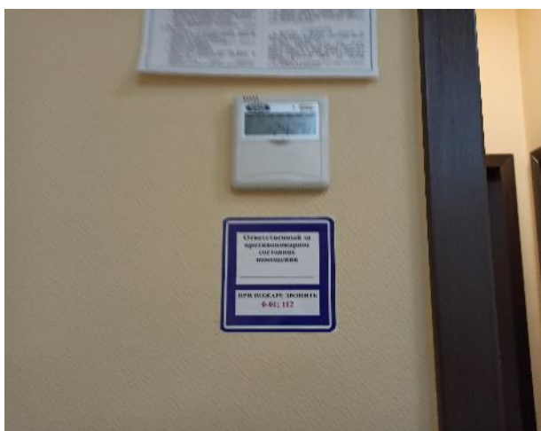
Фотография 166. Внутреннее состояние помещений — 4 этаж
