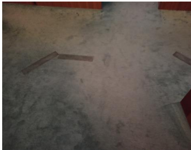
Фотография 176. Внутреннее состояние помещений — 9 этаж
