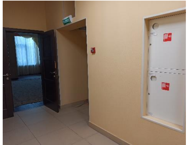
Фотография 230. Внутреннее состояние помещений — 4 этаж
