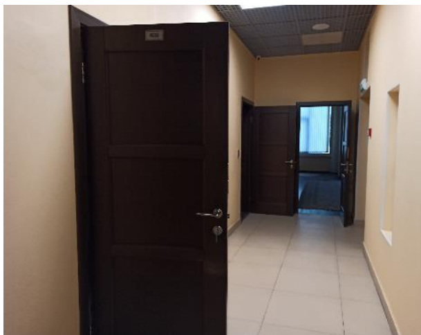
Фотография 224. Внутреннее состояние помещений — 4 этаж
