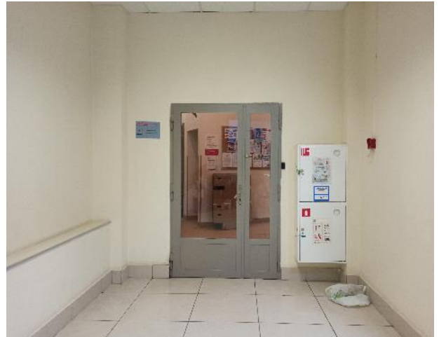
Фотография 4. Внутреннее состояние помещений — 6 этаж
