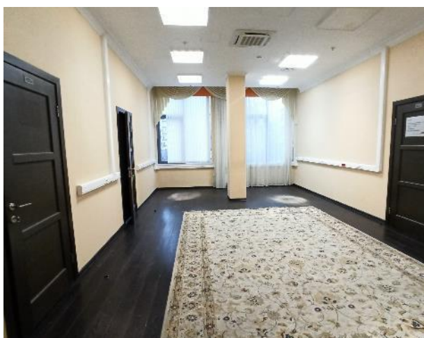
Фотография 238. Внутреннее состояние помещений — 4 этаж
