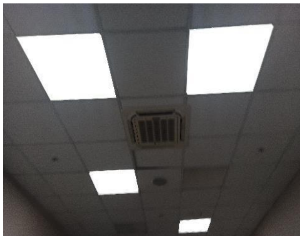
Фотография 55. Внутреннее состояние помещений — 3 этаж
