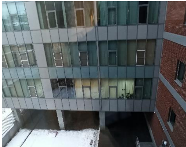
Фотография 111. Внутреннее состояние помещений — 4 этаж
