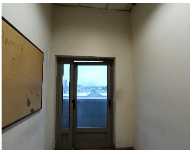
Фотография 34. Внутреннее состояние помещений — 6 этаж
