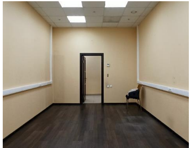
Фотография 112. Внутреннее состояние помещений — 4 этаж
