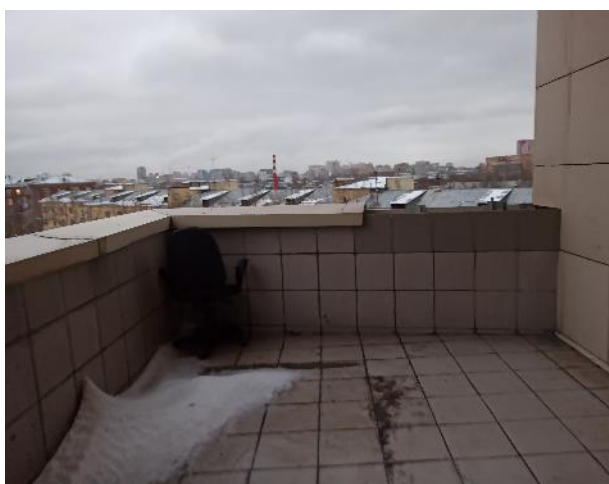
Фотография 58. Внутреннее состояние помещений — 7 этаж
