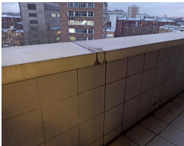
Фотография 128. Внутреннее состояние помещений — 8 этаж
