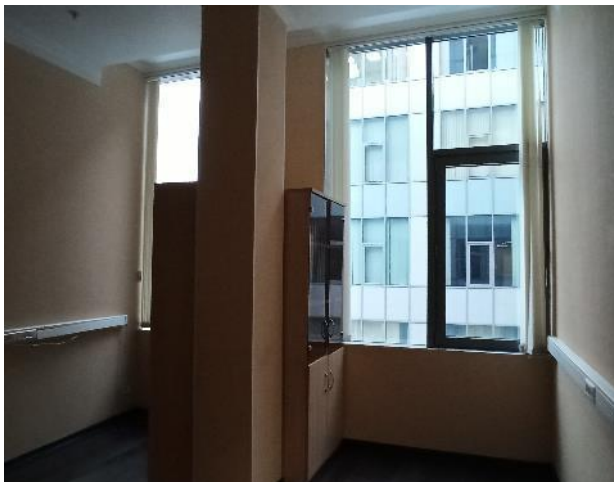
Фотография 115. Внутреннее состояние помещений — 4 этаж
