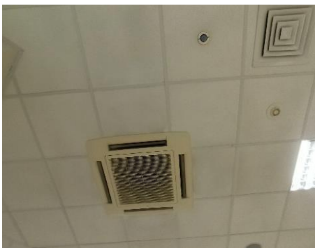
Фотография 21. Внутреннее состояние помещений — 6 этаж
