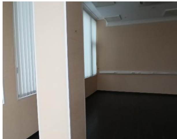
Фотография 128. Внутреннее состояние помещений — 4 этаж
