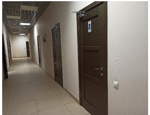
Фотография 88. Внутреннее состояние помещений — 3 этаж
