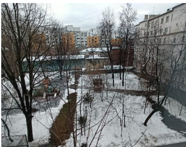
Фотография 239. Внутреннее состояние помещений — 4 этаж
