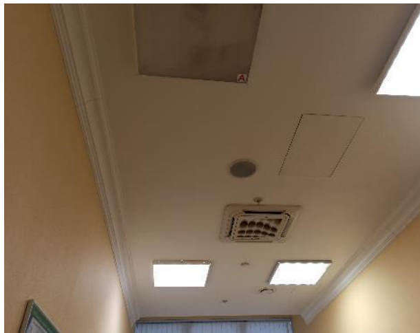
Фотография 243. Внутреннее состояние помещений — 4 этаж
