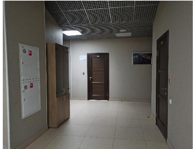
Фотография 50. Внутреннее состояние помещений — 3 этаж
