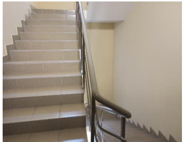
Фотография 232. Внутреннее состояние помещений — 4 этаж
