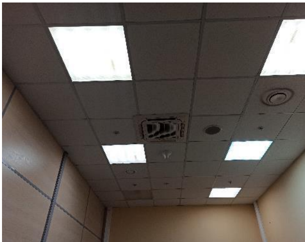
Фотография 207. Внутреннее состояние помещений — 4 этаж
