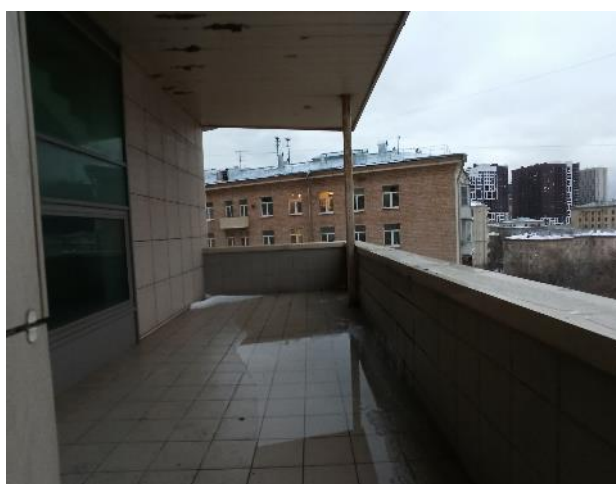
Фотография 35. Внутреннее состояние помещений — 6 этаж
