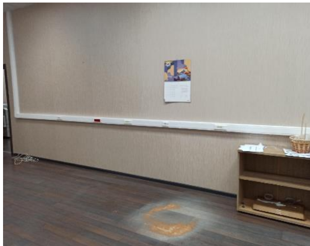
Фотография 63. Внутреннее состояние помещений — 3 этаж
