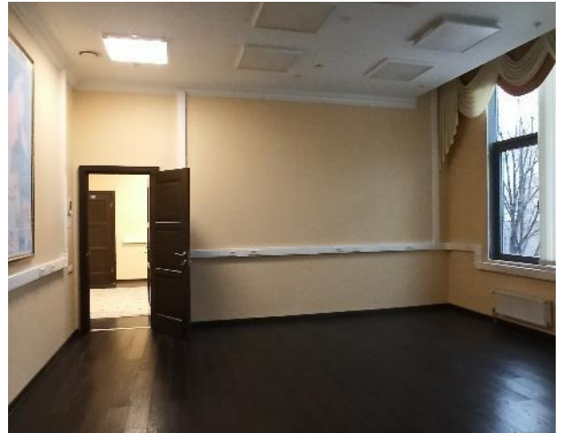
Фотография 254. Внутреннее состояние помещений — 4 этаж
