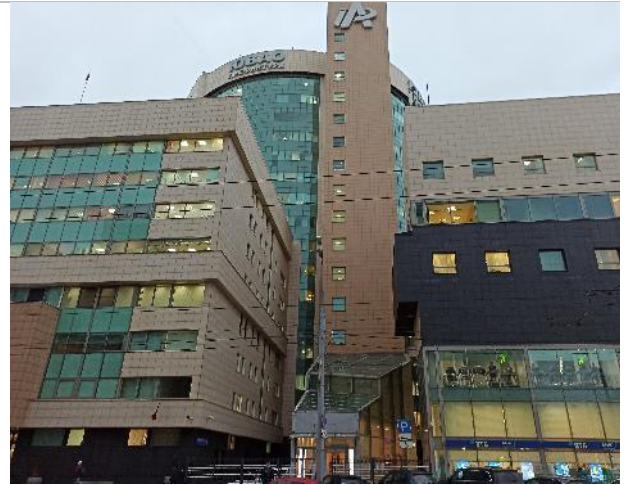
Фотография 2. Внешний вид здания
