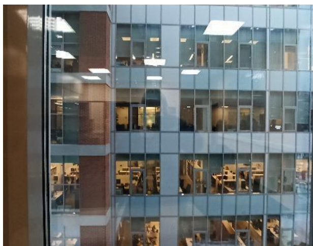
Фотография 143. Внутреннее состояние помещений — 4 этаж
