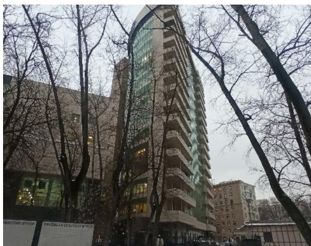
Фотография 221. Внешний вид здания
