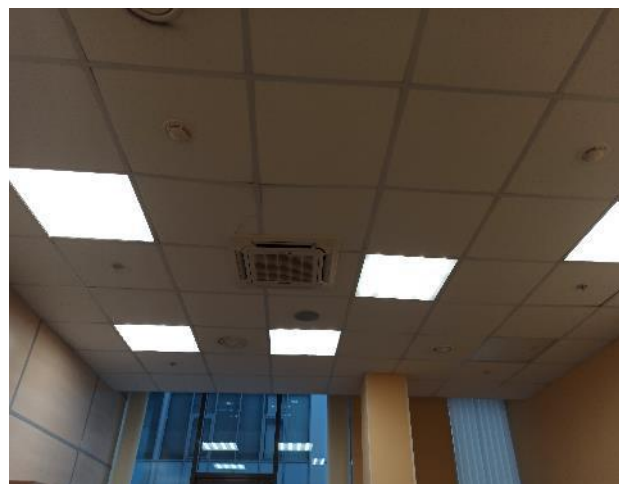
Фотография 234. Внутреннее состояние помещений — 4 этаж
