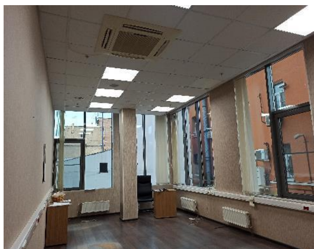
Фотография 60. Внутреннее состояние помещений — 3 этаж
