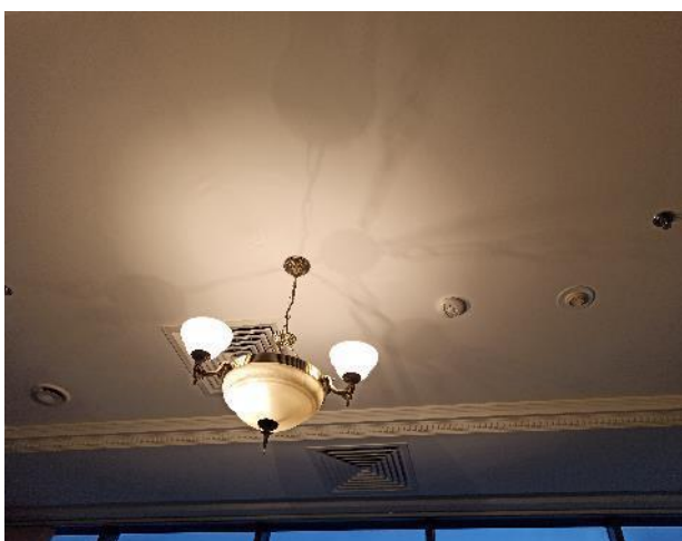
Фотография 177. Внутреннее состояние помещений — 9 этаж
