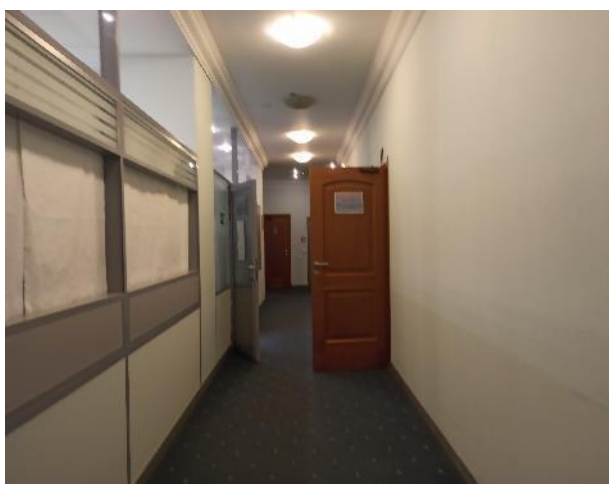
Фотография 168. Внутреннее состояние помещений — 9 этаж
