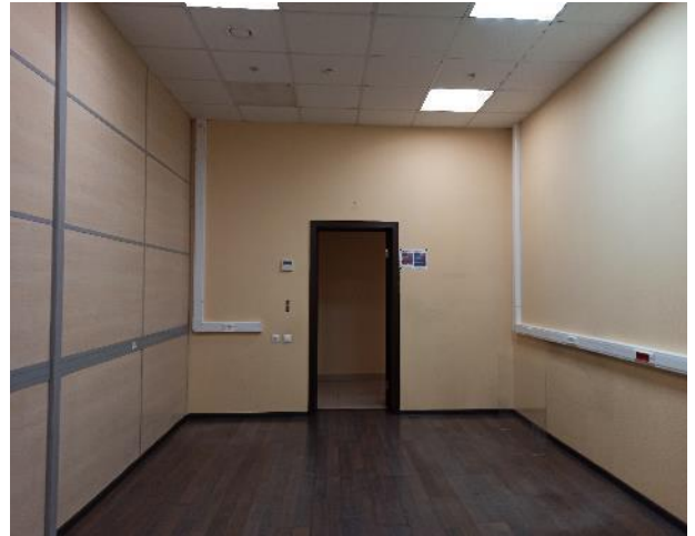
Фотография 206. Внутреннее состояние помещений — 4 этаж
