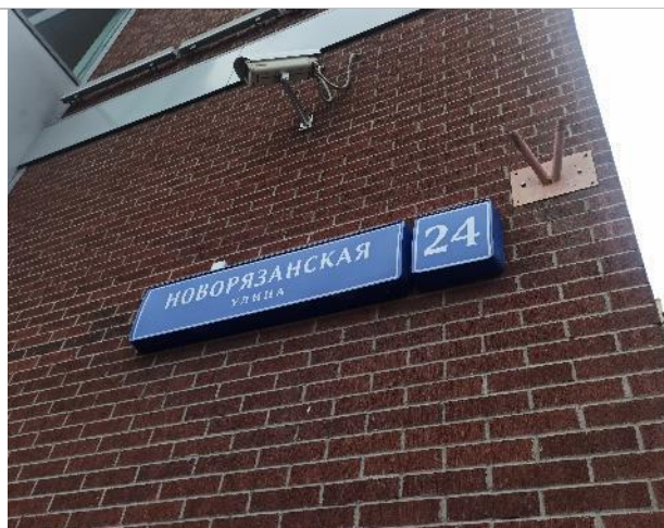
Фотография 22. Внешний вид здания
