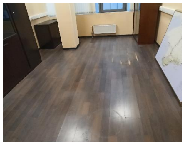
Фотография 150. Внутреннее состояние помещений — 4 этаж
