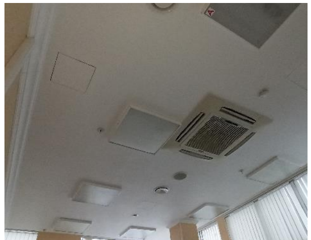
Фотография 124. Внутреннее состояние помещений — 4 этаж
