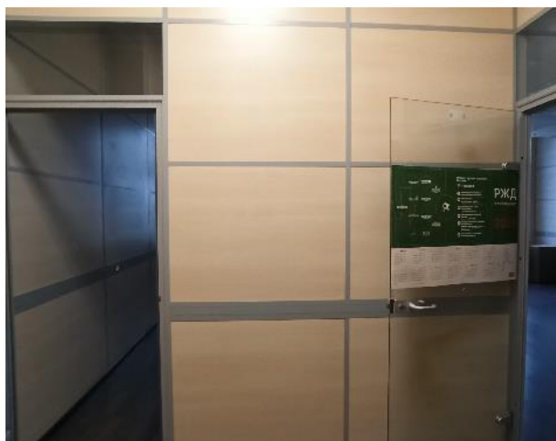
Фотография 173. Внутреннее состояние помещений — 4 этаж
