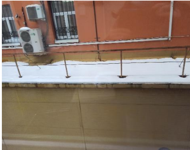
Фотография 61. Внутреннее состояние помещений — 3 этаж
