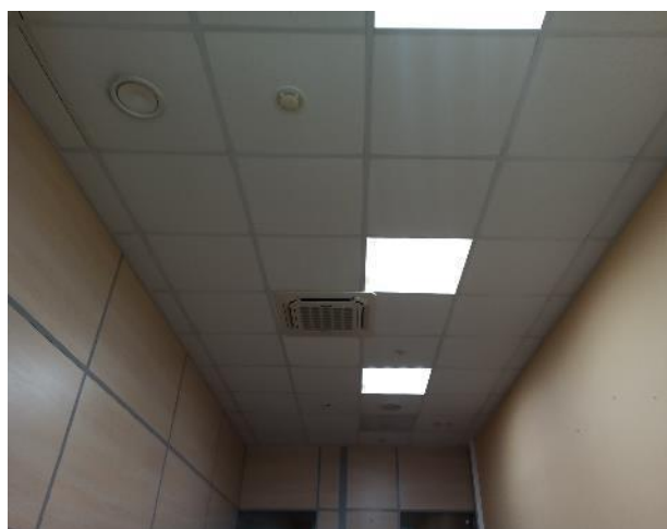
Фотография 214. Внутреннее состояние помещений — 4 этаж
