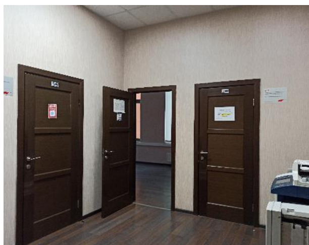
Фотография 58. Внутреннее состояние помещений — 3 этаж
