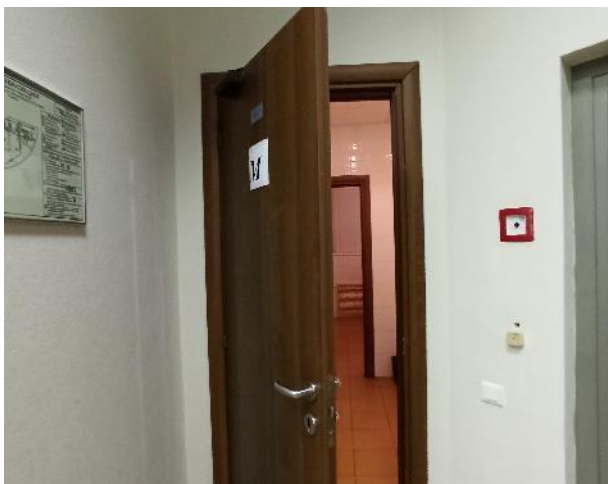
Фотография 29. Внутреннее состояние помещений — 6 этаж
