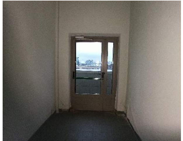
Фотография 194. Внутреннее состояние помещений — 9 этаж
