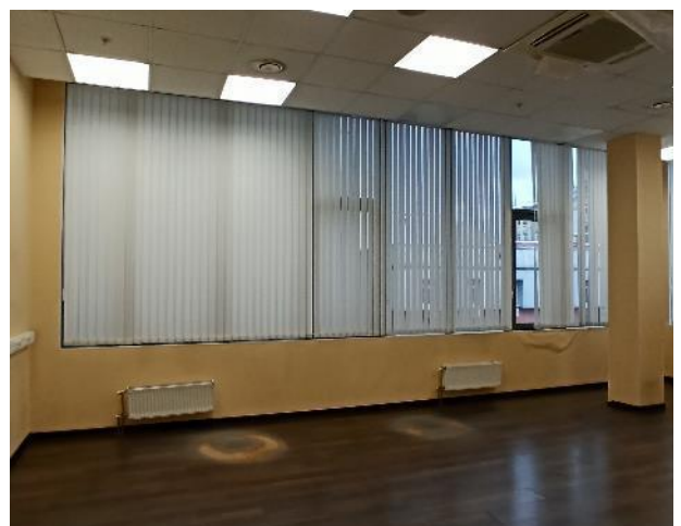
Фотография 186. Внутреннее состояние помещений — 4 этаж
