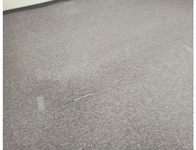
Фотография 86. Внутреннее состояние помещений — 3 этаж
