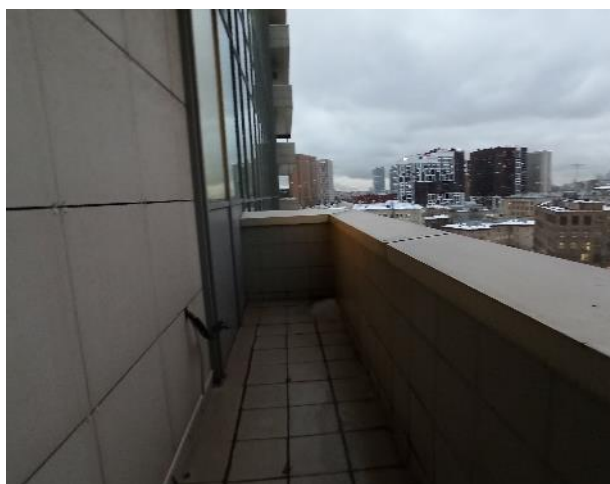
Фотография 197. Внутреннее состояние помещений — 9 этаж
