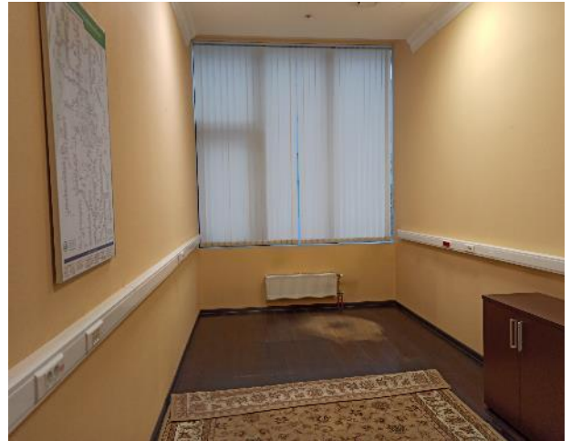
Фотография 242. Внутреннее состояние помещений — 4 этаж
