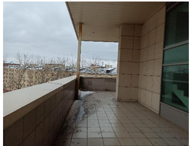
Фотография 52. Внутреннее состояние помещений — 6 этаж
