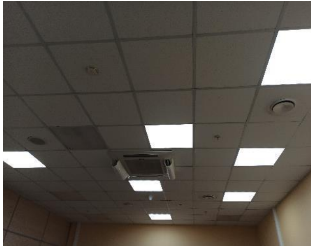
Фотография 169. Внутреннее состояние помещений — 4 этаж
