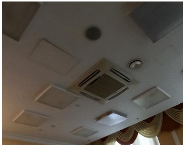
Фотография 255. Внутреннее состояние помещений — 4 этаж
