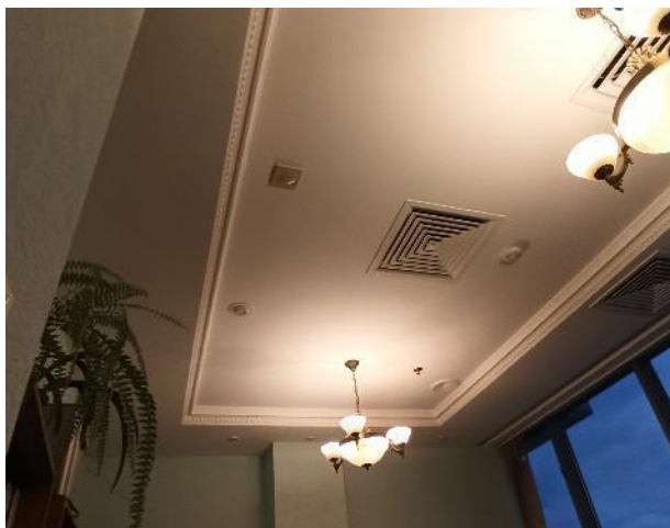
Фотография 200. Внутреннее состояние помещений — 9 этаж
