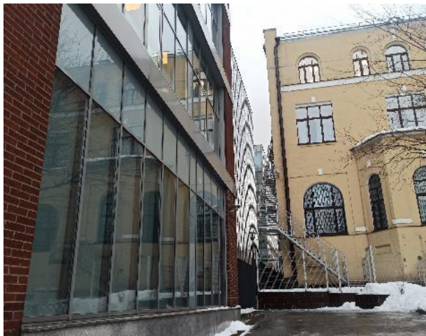
Фотография 8. Внешний вид здания
