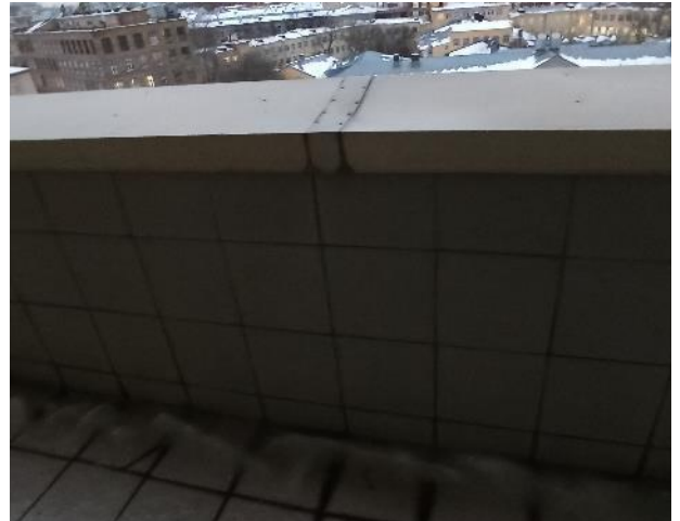
Фотография 98. Внутреннее состояние помещений — 8 этаж
