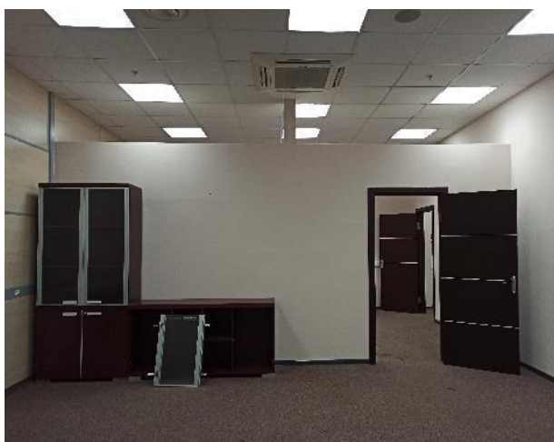
Фотография 82. Внутреннее состояние помещений — 3 этаж
