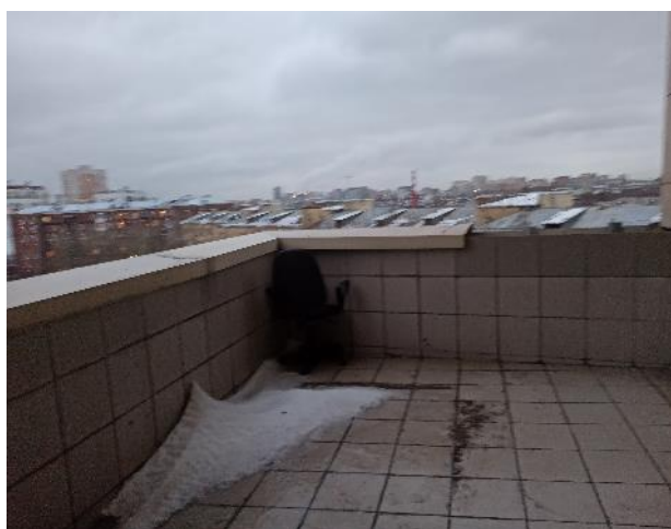
Фотография 57. Внутреннее состояние помещений — 7 этаж
