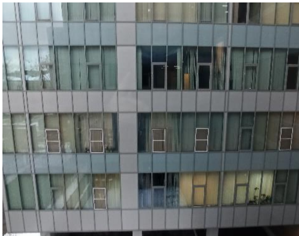
Фотография 116. Внутреннее состояние помещений — 4 этаж
