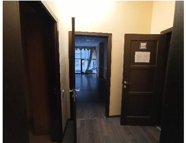
Фотография 158. Внутреннее состояние помещений — 4 этаж
