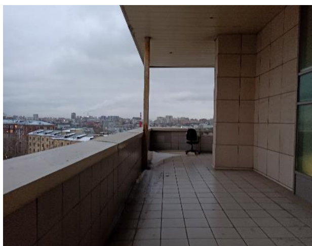
Фотография 129. Внутреннее состояние помещений — 8 этаж
