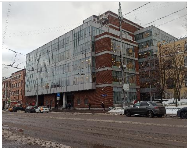
Фотография 24. Внешний вид здания
