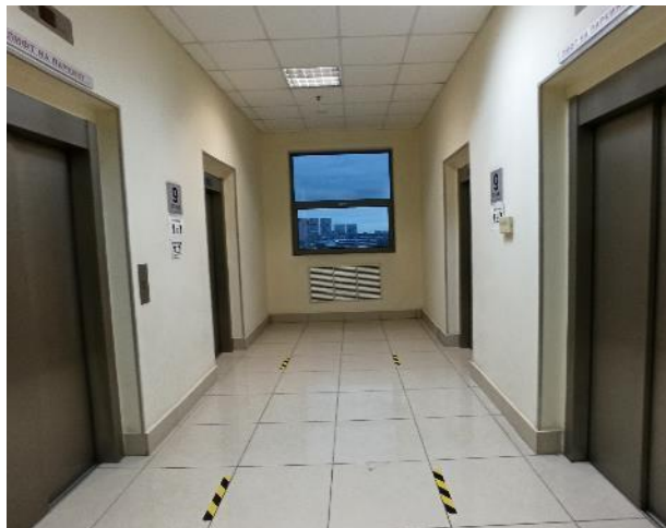
Фотография 135. Внутреннее состояние помещений — 9 этаж
