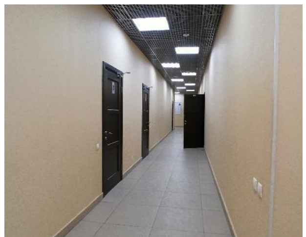
Фотография 102. Внутреннее состояние помещений — 4 этаж
