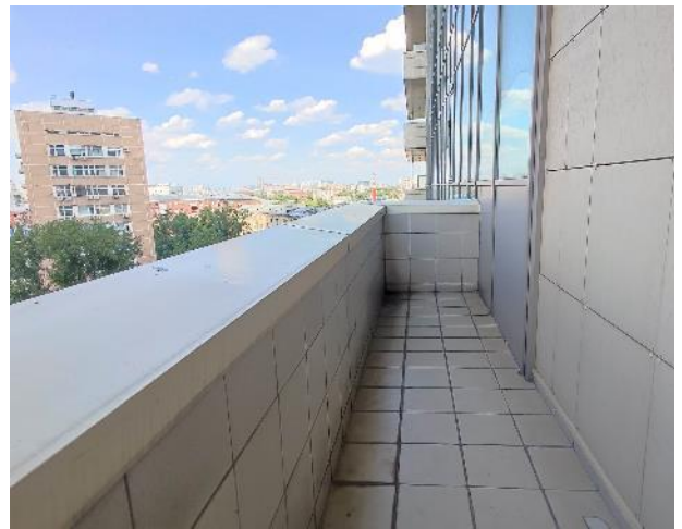
Фото 76. Внутренние помещения, 8 этаж.
