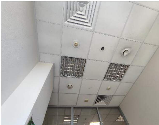
Фото 19. Внутренние помещения, 6 этаж.
