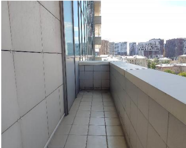
Фото 97. Внутренние помещения, 8 этаж.
