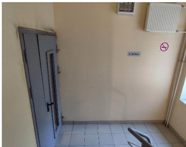
Фото 5. Внутренние помещения, 2 этаж.
