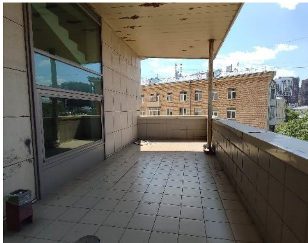
Фото 29. Внутренние помещения, 6 этаж.
