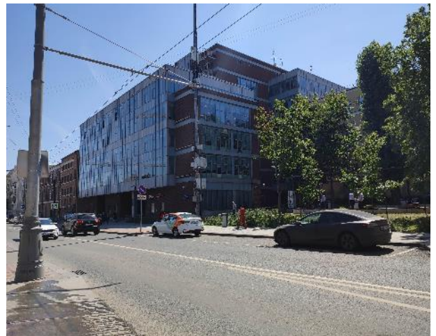
Фото 78. Подъездные пути, фасад, входная группа.
