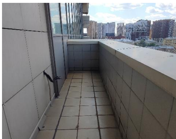
Фото 144. Внутренние помещения, 9 этаж.
