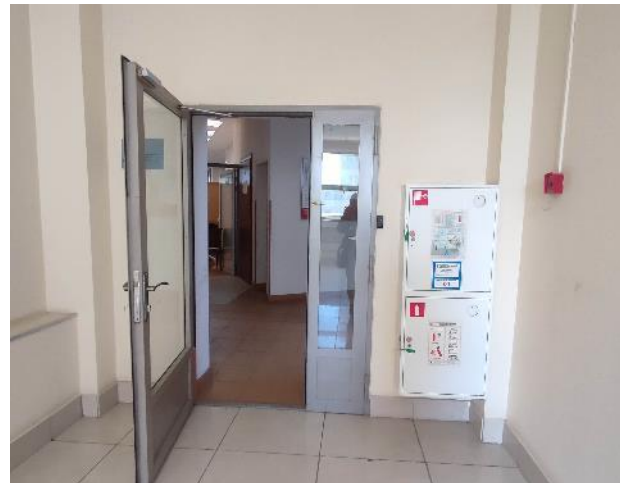
Фото 4. Внутренние помещения, 6 этаж.
