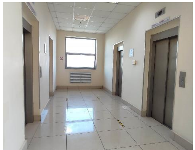
Фото 102. Внутренние помещения, 8 этаж.
