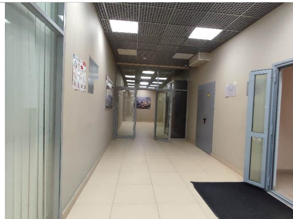
Фотография 17. Внутреннее состояние помещений — 2 этаж
