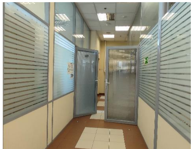
Фото 54. Внутренние помещения, 7 этаж.
