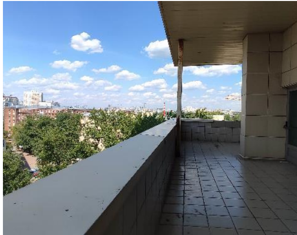
Фото 61. Внутренние помещения, 7 этаж.
