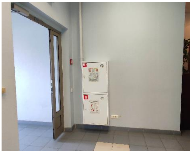
Фото 94. Внутренние помещения, 8 этаж.
