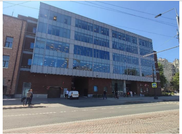
Фотография 16. Внешний вид здания
