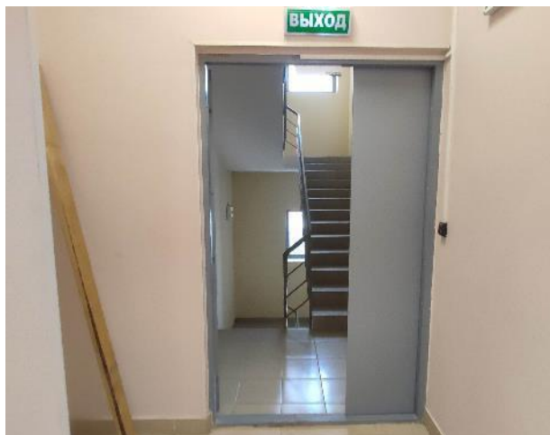
Фото 65. Внутренние помещения, 3 этаж.
