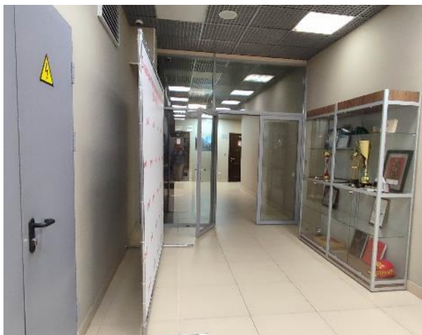
Фото 32. Внутренние помещения, 2 этаж.
