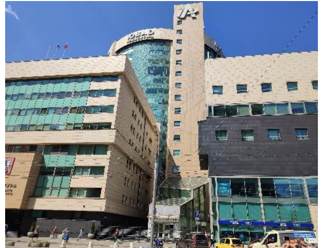
Фото 146. Подъездные пути, фасад, входная группа.
