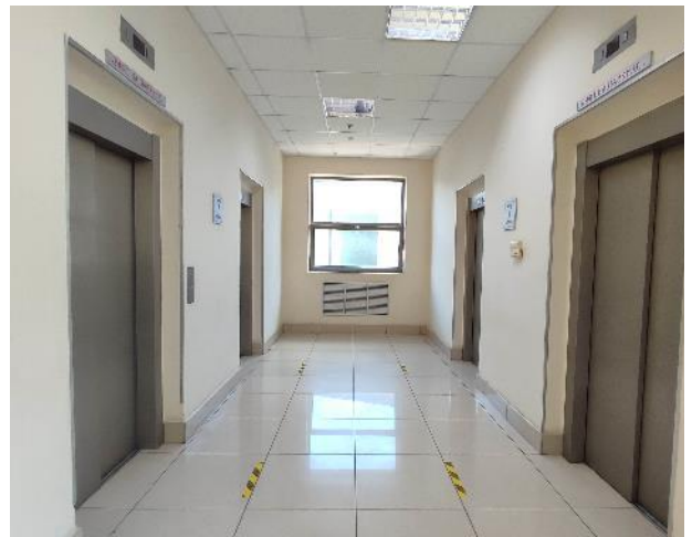
Фото 40. Внутренние помещения, 7 этаж.
