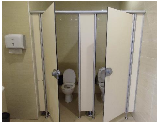
Фото 54. Внутренние помещения, 3 этаж.
