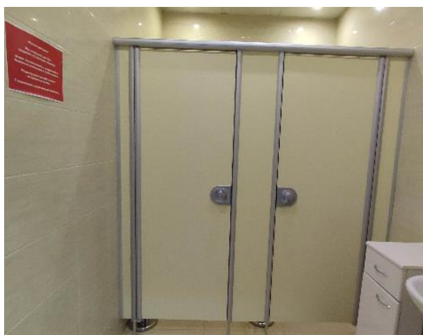
Фото 59. Внутренние помещения, 3 этаж.
