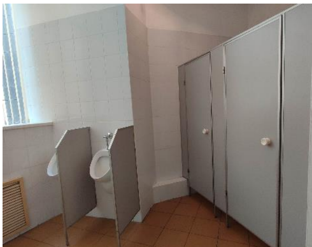
Фото 24. Внутренние помещения, 6 этаж.
