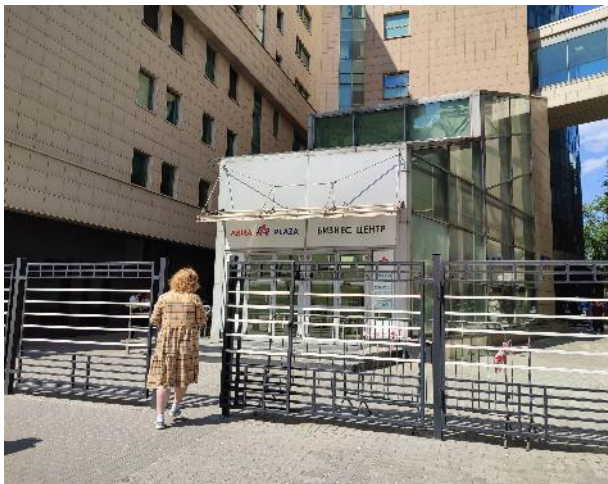
Фото 147. Подъездные пути, фасад, входная группа.
