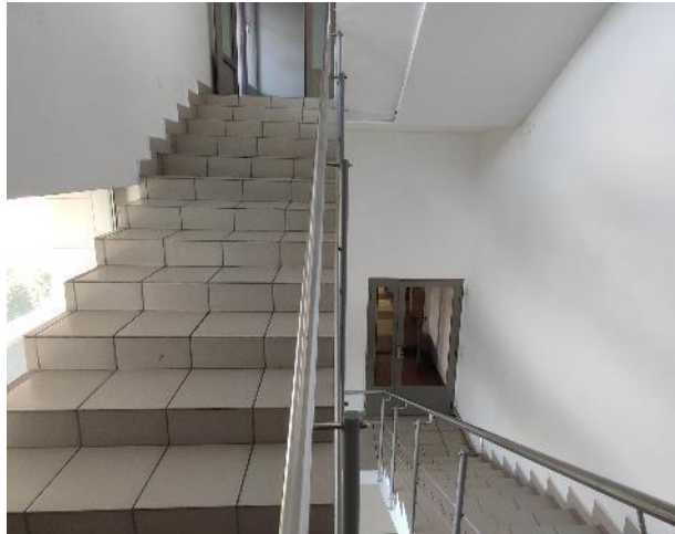
Фото 73. Внутренние помещения, 8 этаж.
