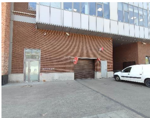
Фото 83. Подъездные пути, фасад, входная группа.
