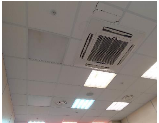
Фото 16. Внутренние помещения, 2 этаж.
