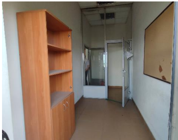
Фото 32. Внутренние помещения, 6 этаж.
