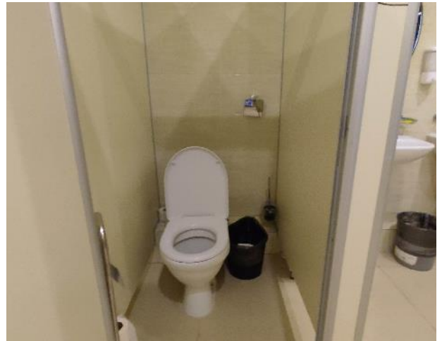
Фото 76. Внутренние помещения, 3 этаж.
