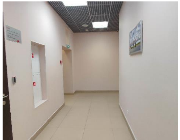
Фото 64. Внутренние помещения, 3 этаж.
