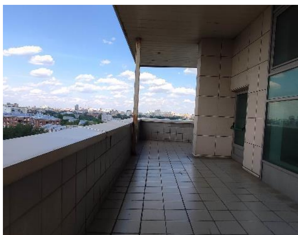
Фото 143. Внутренние помещения, 9 этаж.
