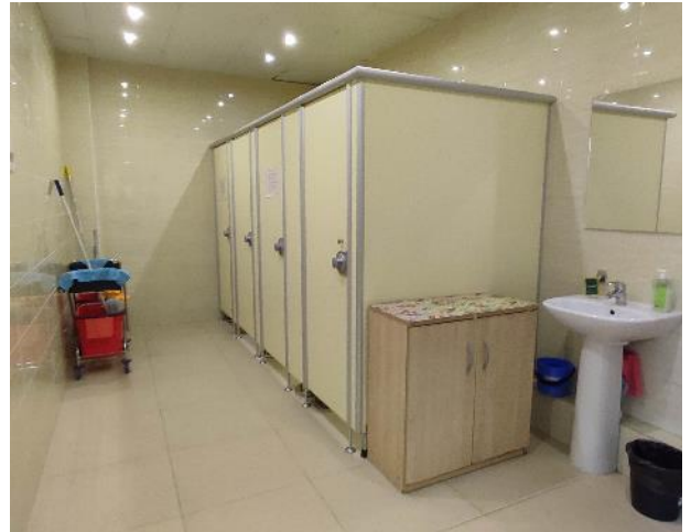
Фото 38. Внутренние помещения, 2 этаж.
