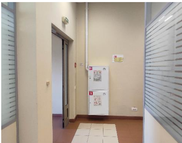
Фото 57. Внутренние помещения, 7 этаж.
