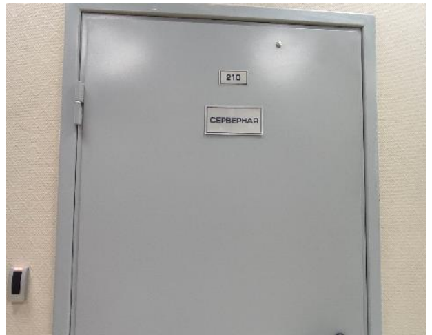
Фото 40. Внутренние помещения, 2 этаж.
