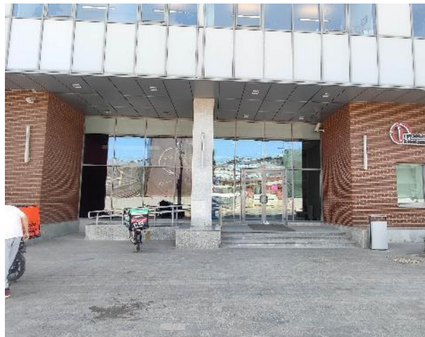
Фото 86. Подъездные пути, фасад, входная группа.
