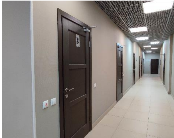
Фото 37. Внутренние помещения, 2 этаж.
