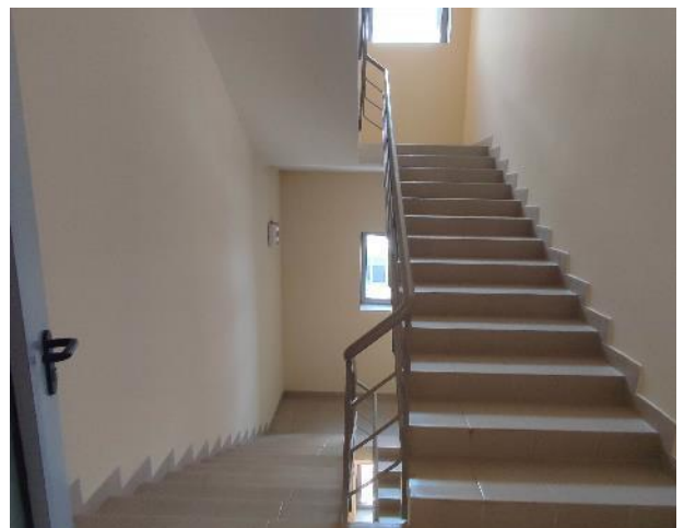
Фото 66. Внутренние помещения, 3 этаж.
