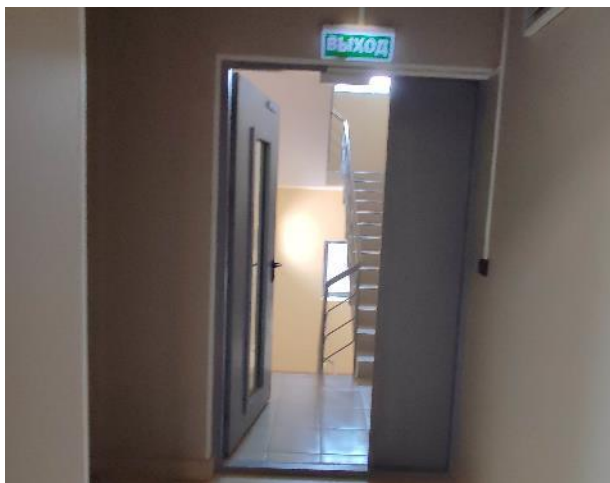
Фото 22. Внутренние помещения, 2 этаж.
