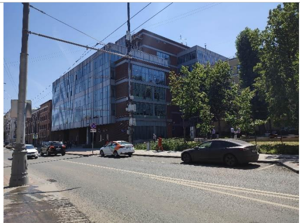
Фотография 14. Внешний вид здания
