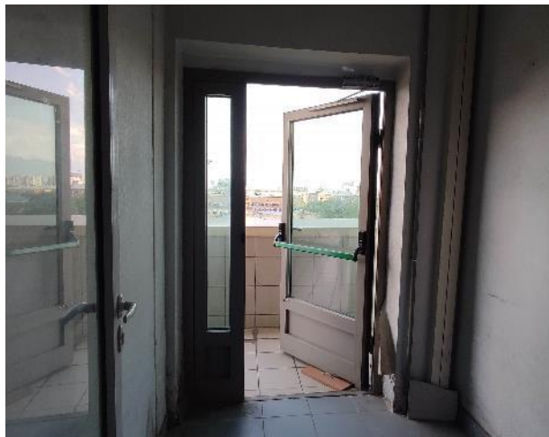
Фото 75. Внутренние помещения, 8 этаж.
