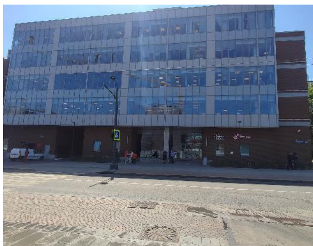
Фото 81. Подъездные пути, фасад, входная группа.
