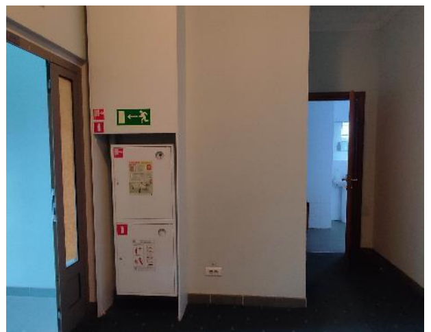
Фото 138. Внутренние помещения, 9 этаж.
