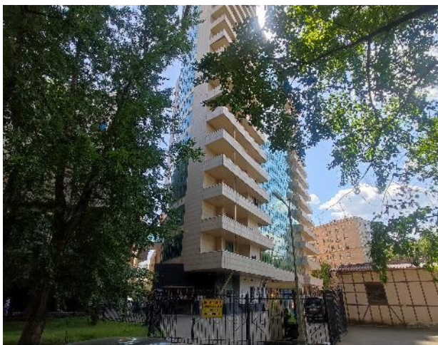
Фото 151. Подъездные пути, фасад, входная группа.
