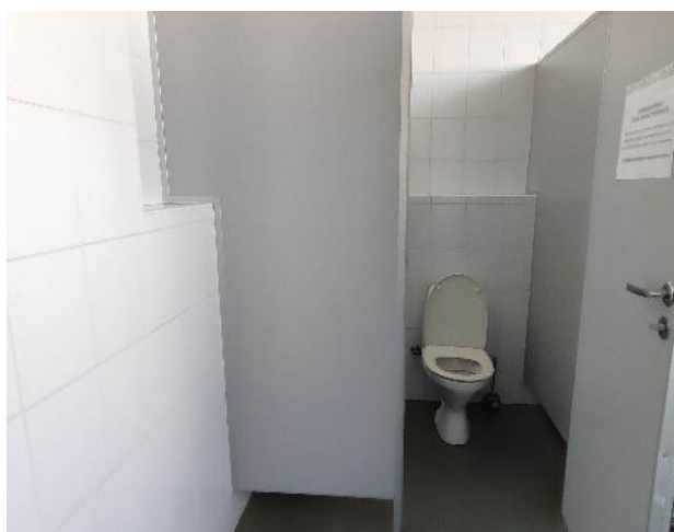
Фото 141. Внутренние помещения, 9 этаж.
