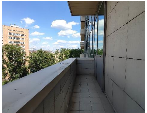
Фото 30. Внутренние помещения, 6 этаж.
