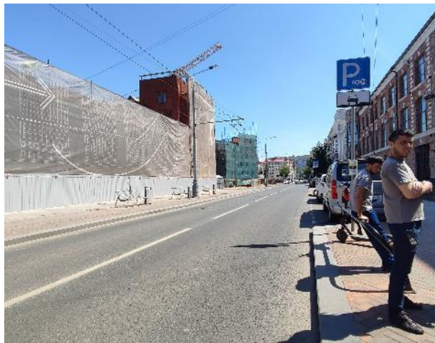
Фото 85. Подъездные пути, фасад, входная группа.
