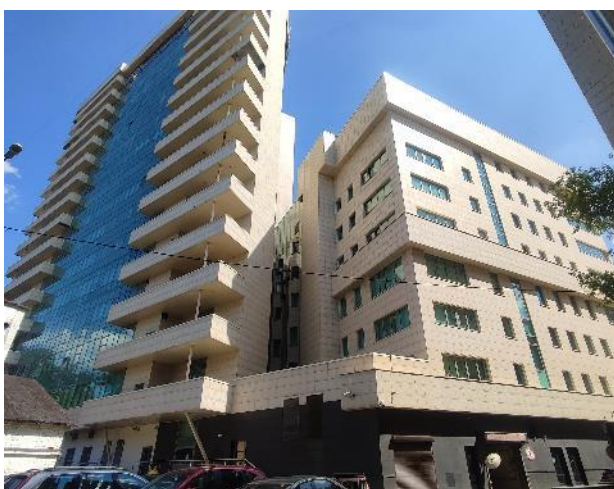
Фото 153. Подъездные пути, фасад, входная группа.
