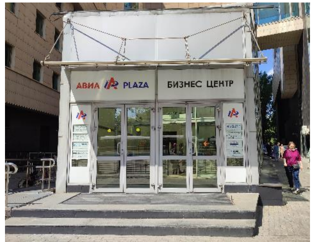
Фото 148. Подъездные пути, фасад, входная группа.
