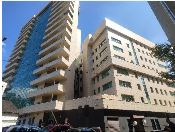
Фотография 3. Внешний вид здания
