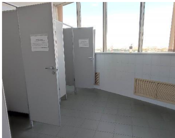
Фото 140. Внутренние помещения, 9 этаж.
