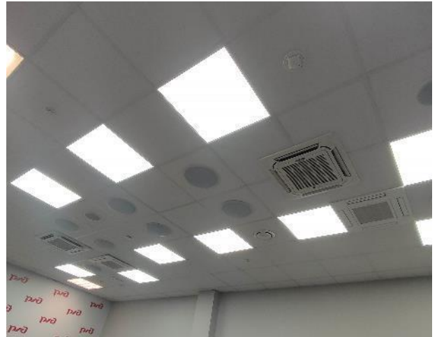
Фото 62. Внутренние помещения, 3 этаж.
