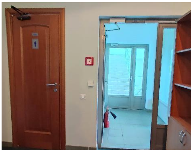
Фото 128. Внутренние помещения, 9 этаж.
