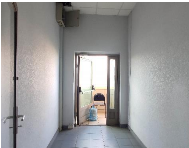
Фото 95. Внутренние помещения, 8 этаж.
