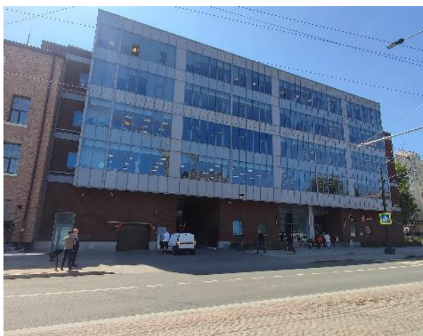
Фото 82. Подъездные пути, фасад, входная группа.
