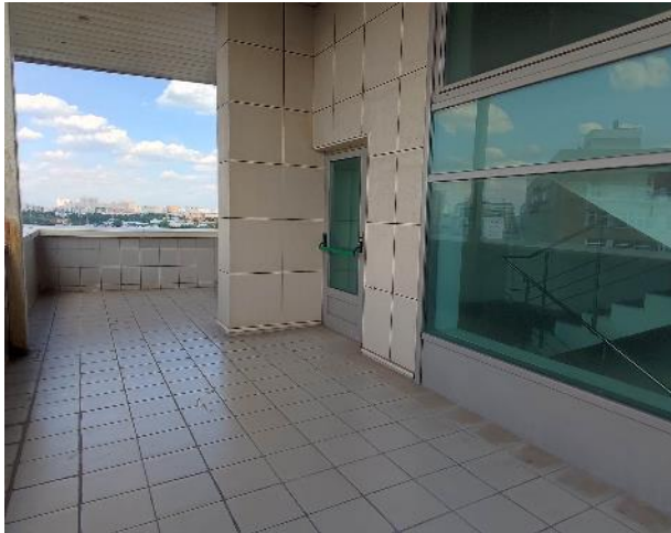
Фото 145. Внутренние помещения, 9 этаж.
