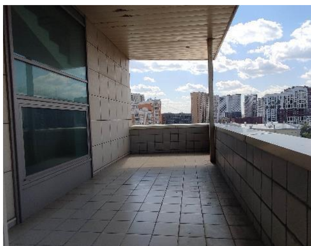
Фото 131. Внутренние помещения, 9 этаж.
