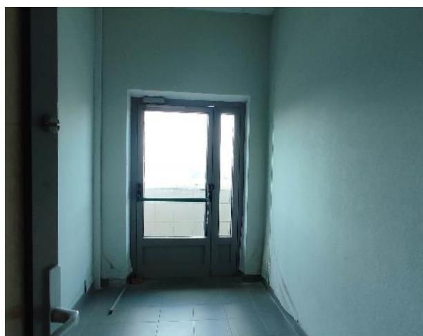
Фото 142. Внутренние помещения, 9 этаж.
