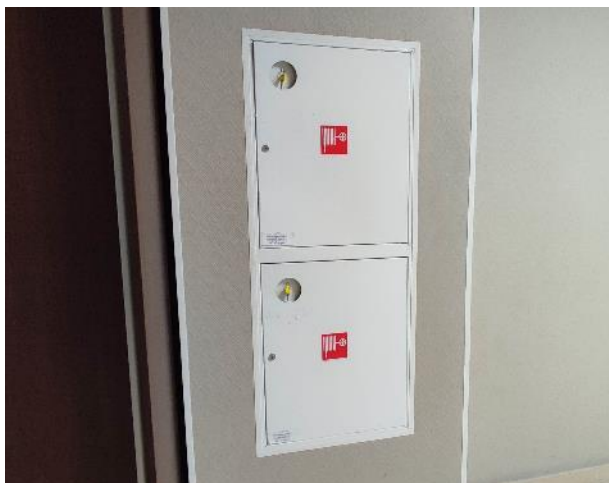
Фото 34. Внутренние помещения, 2 этаж.
