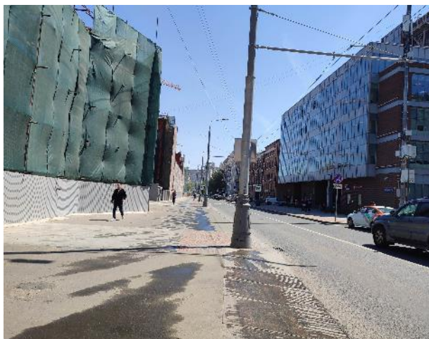
Фото 80. Подъездные пути, фасад, входная группа.
