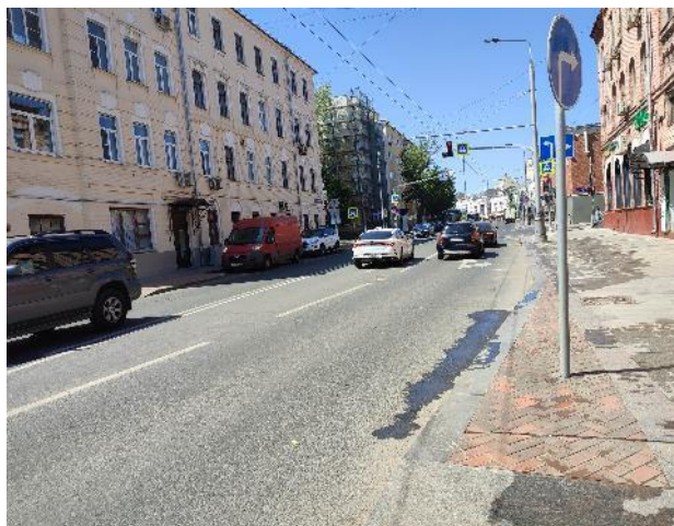
Фото 79. Подъездные пути, фасад, входная группа.
