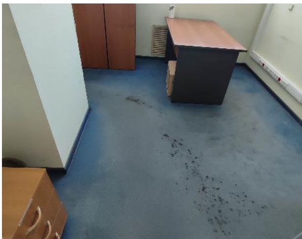
Фото 83. Внутренние помещения, 8 этаж.
