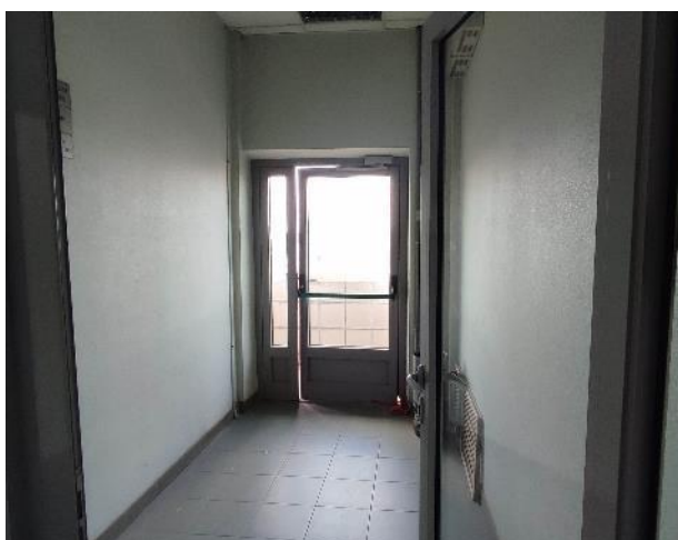
Фото 130. Внутренние помещения, 9 этаж.
