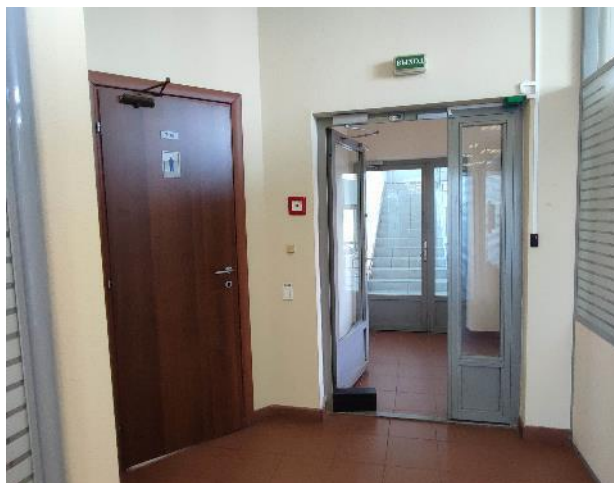
Фото 71. Внутренние помещения, 7 этаж.
