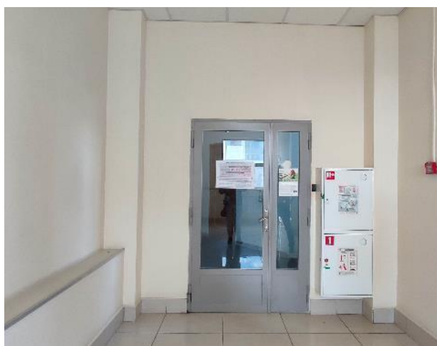
Фото 107. Внутренние помещения, 9 этаж.
