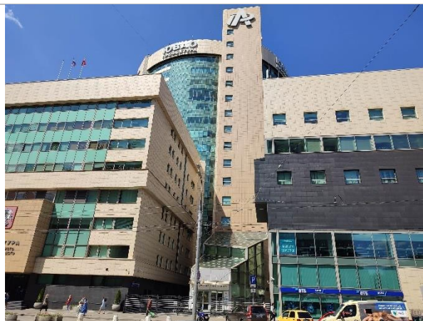
Фотография 2. Внешний вид здания
