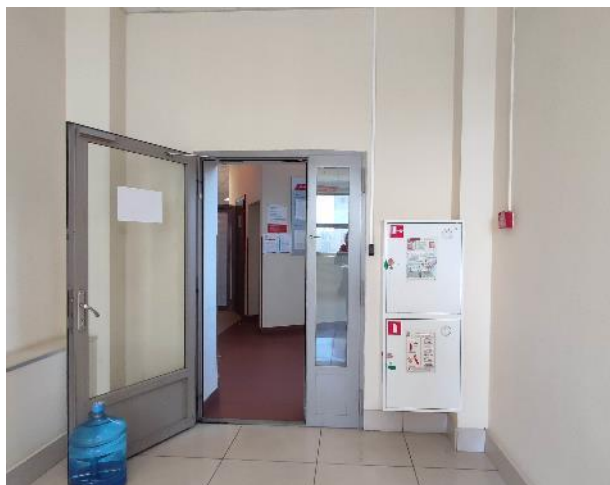
Фото 41. Внутренние помещения, 7 этаж.
