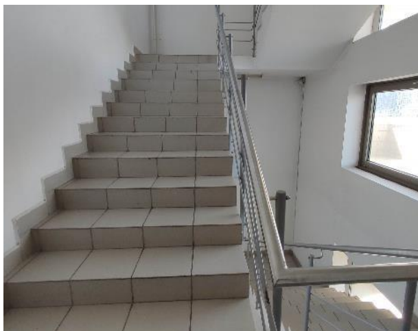
Фото 72. Внутренние помещения, 8 этаж.
