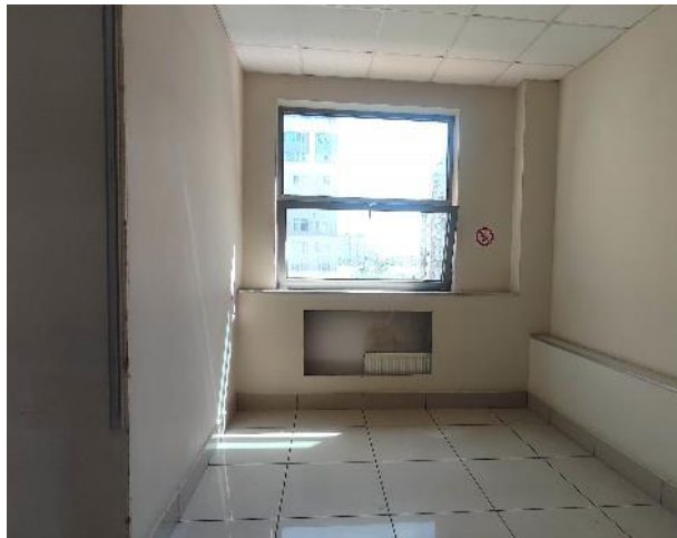
Фото 3. Внутренние помещения, 6 этаж.
