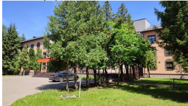
Фотография №24. Участок 35 000 кв.м
