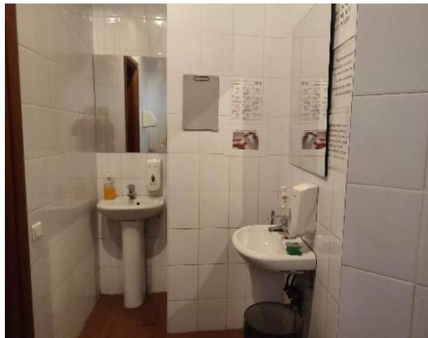
Фото 72. Внутренние помещения, 7 этаж.
