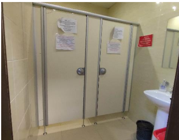
Фото 13. Внутренние помещения, 2 этаж.
