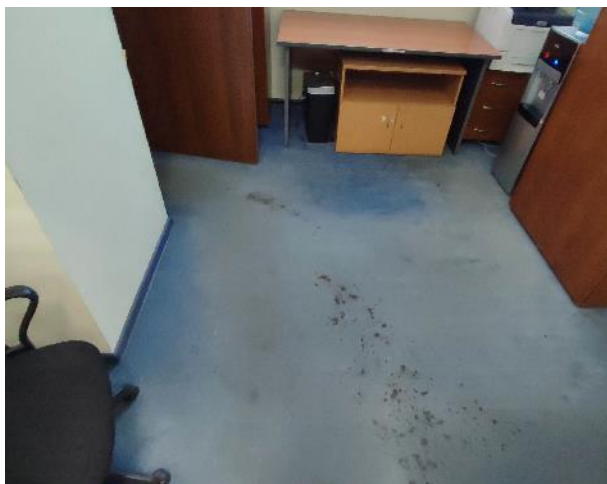
Фото 122. Внутренние помещения, 8 этаж.
