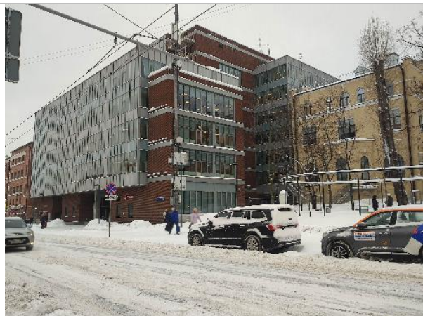
Фотография 14. Внешний вид здания
