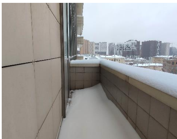
Фото 107. Внутренние помещения, 8 этаж.
