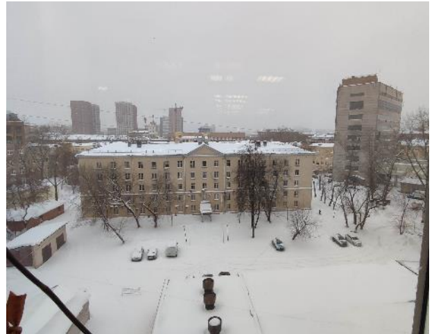
Фото 14. Внутренние помещения, 6 этаж.
