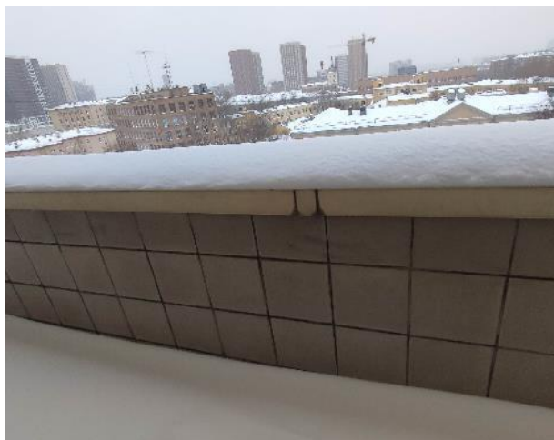
Фото 44. Внутренние помещения, 7 этаж.
