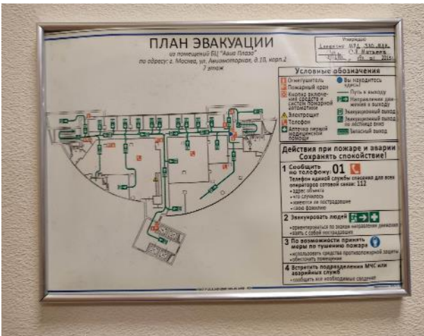
Фото 71. Внутренние помещения, 7 этаж.
