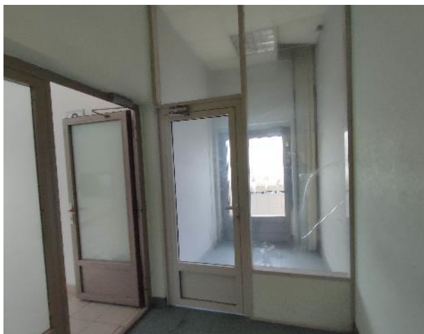
Фото 128. Внутренние помещения, 8 этаж.
