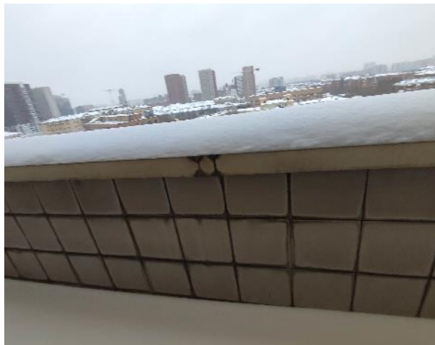
Фото 135. Внутренние помещения, 9 этаж.
