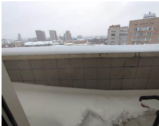
Фото 171. Внутренние помещения, 9 этаж.
