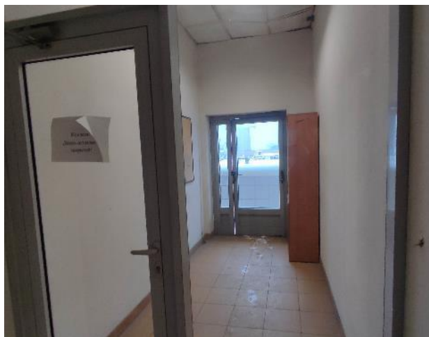
Фото 21. Внутренние помещения, 6 этаж.
