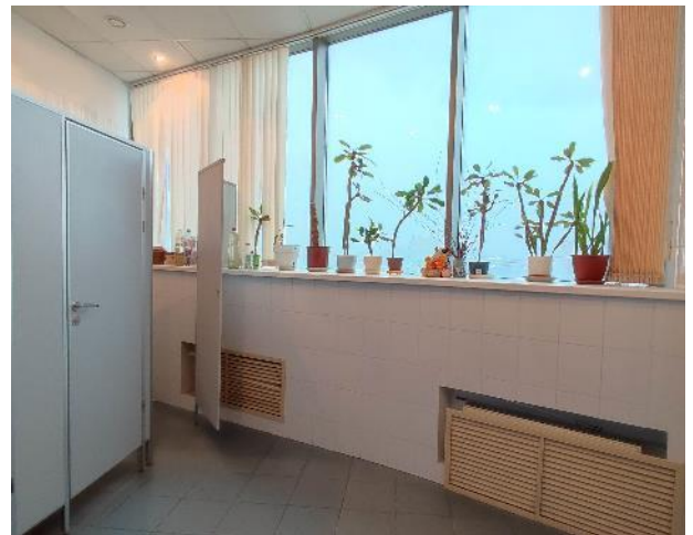
Фото 112. Внутренние помещения, 8 этаж.
