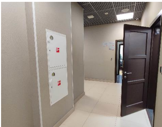
Фото 15. Внутренние помещения, 2 этаж.
