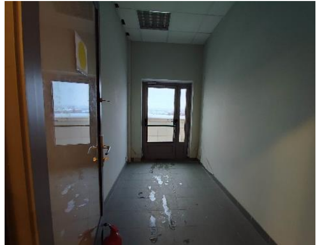
Фото 170. Внутренние помещения, 9 этаж.
