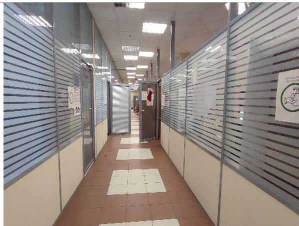
Фотография 7. Внутреннее состояние помещений — 7 этаж
