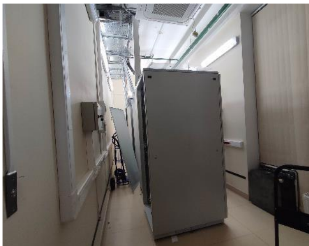
Фото 50. Внутренние помещения, 3 этаж.
