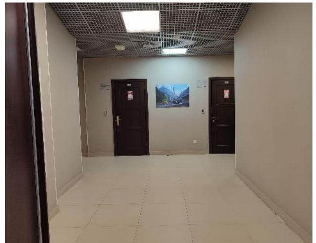
Фото 36. Внутренние помещения, 2 этаж.
