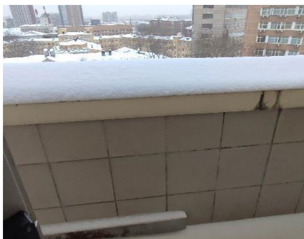
Фото 105. Внутренние помещения, 8 этаж.
