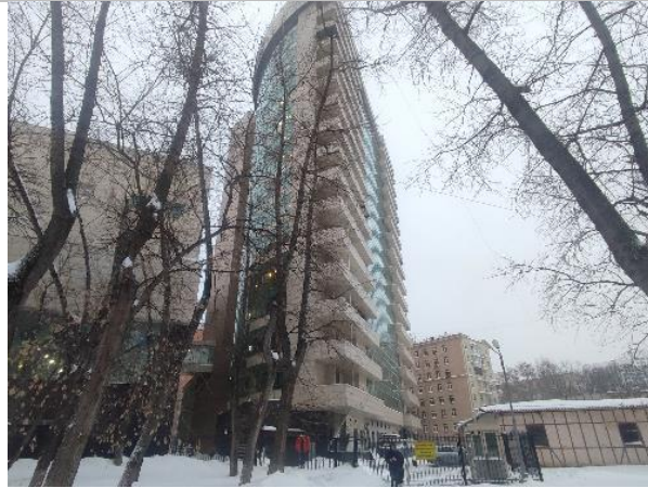
Фотография 3. Внешний вид здания
