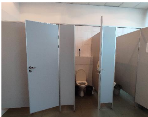
Фото 179. Внутренние помещения, 9 этаж.
