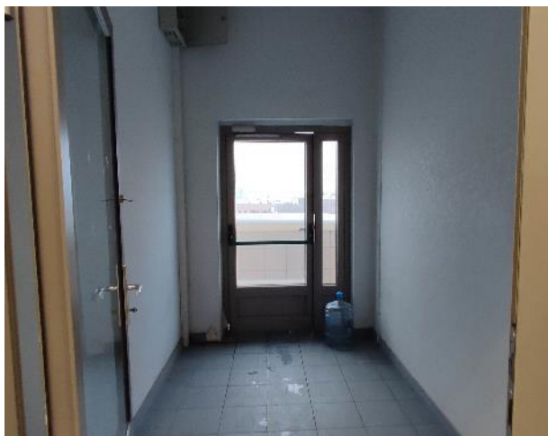
Фото 104. Внутренние помещения, 8 этаж.
