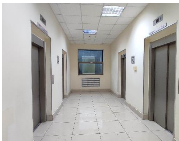
Фото 83. Внутренние помещения, 7 этаж.
