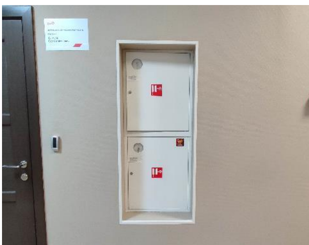
Фото 5. Внутренние помещения, 2 этаж.
