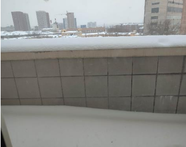
Фото 67. Внутренние помещения, 7 этаж.
