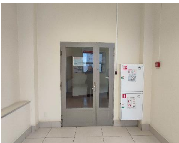
Фото 84. Внутренние помещения, 7 этаж.
