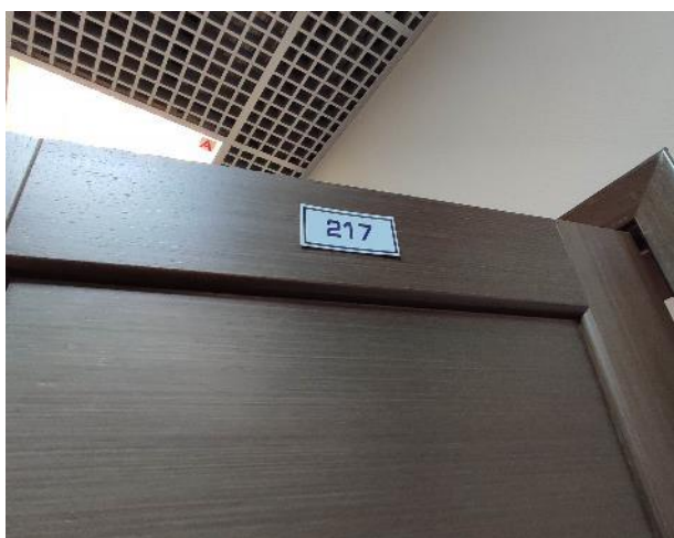
Фото 6. Внутренние помещения, 2 этаж.
