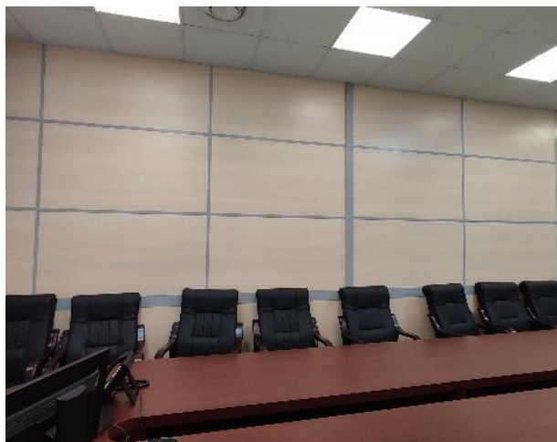
Фото 23. Внутренние помещения, 2 этаж.
