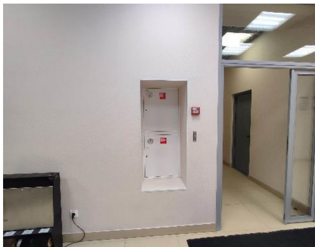
Фото 51. Внутренние помещения, 3 этаж.
