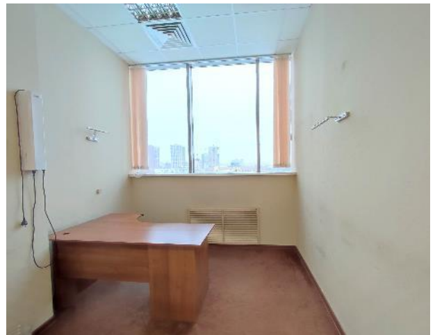
Фото 54. Внутренние помещения, 7 этаж.
