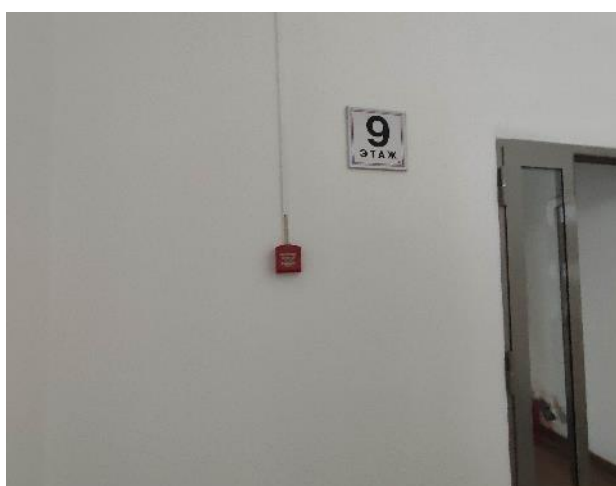
Фото 131. Внутренние помещения, 9 этаж.
