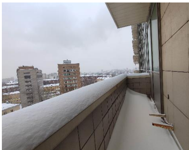
Фото 137. Внутренние помещения, 9 этаж.
