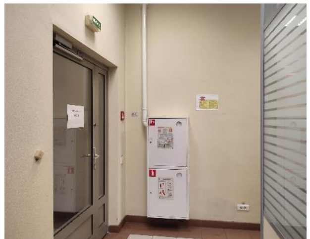
Фото 66. Внутренние помещения, 7 этаж.
