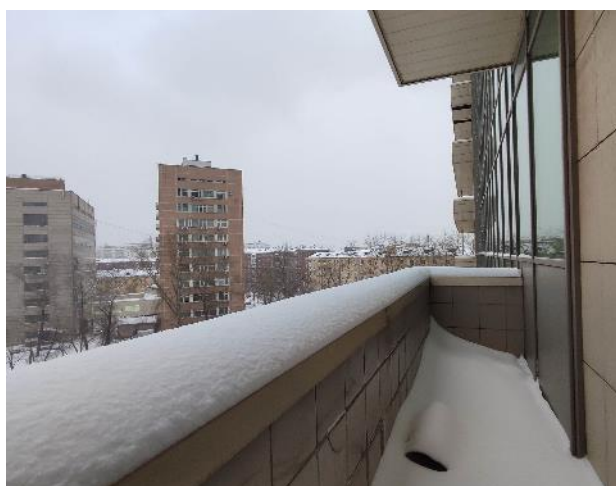
Фото 23. Внутренние помещения, 6 этаж.
