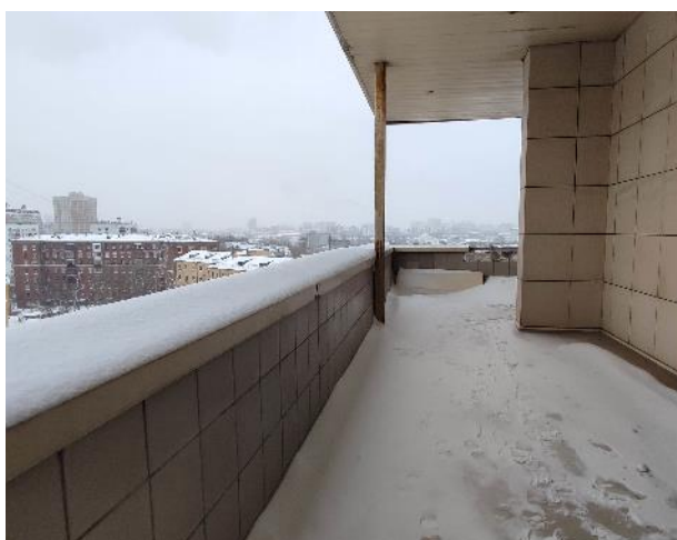
Фото 106. Внутренние помещения, 8 этаж.
