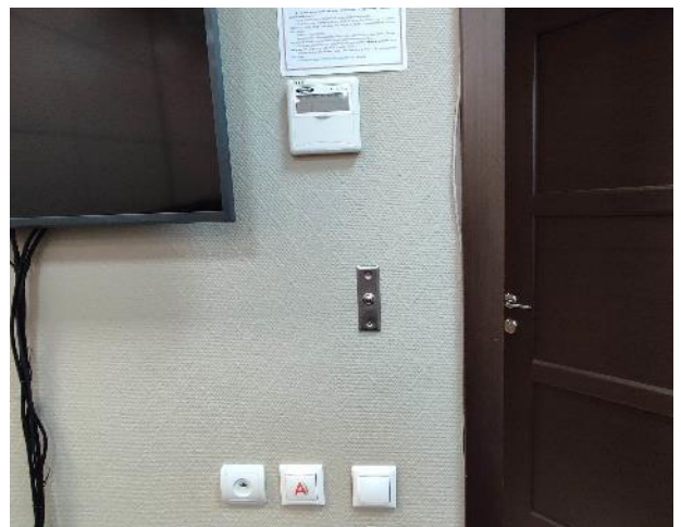
Фото 24. Внутренние помещения, 2 этаж.
