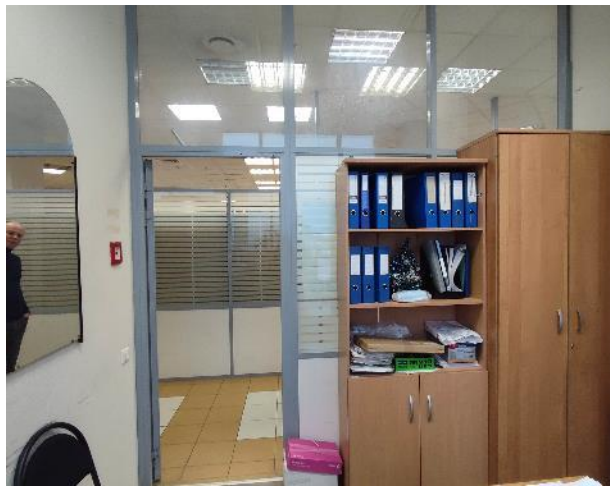
Фото 15. Внутренние помещения, 6 этаж.
