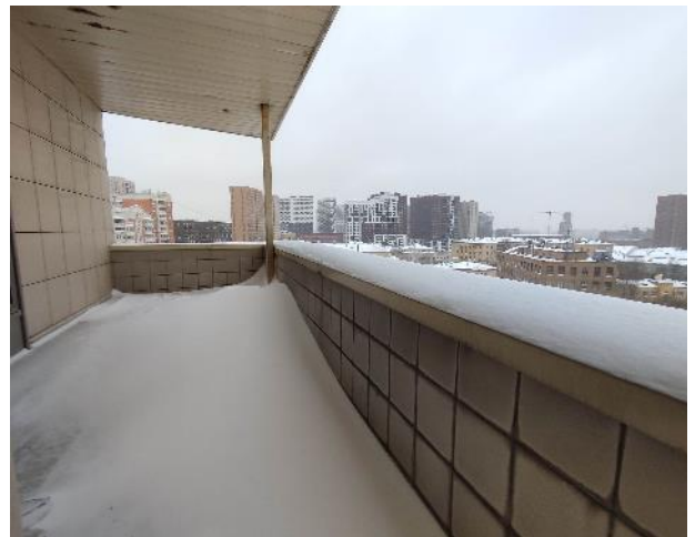
Фото 136. Внутренние помещения, 9 этаж.
