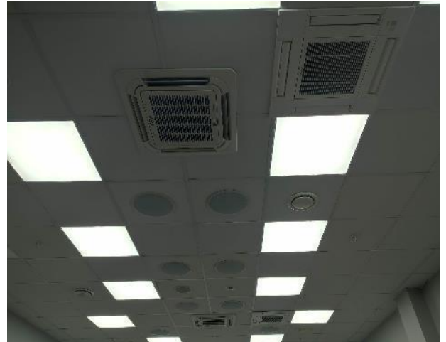
Фото 68. Внутренние помещения, 3 этаж.
