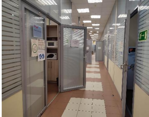
Фото 68. Внутренние помещения, 7 этаж.
