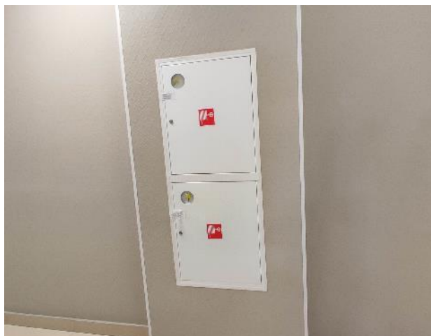
Фото 25. Внутренние помещения, 2 этаж.
