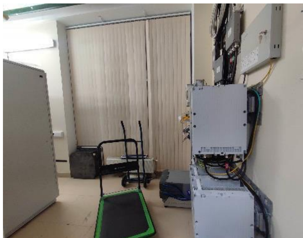
Фото 49. Внутренние помещения, 3 этаж.
