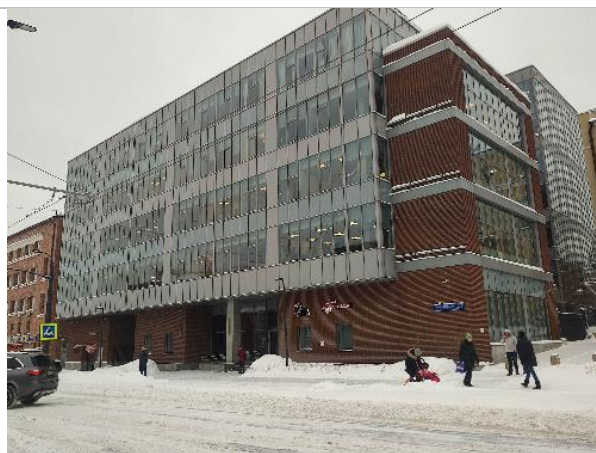
Фотография 16. Внешний вид здания
