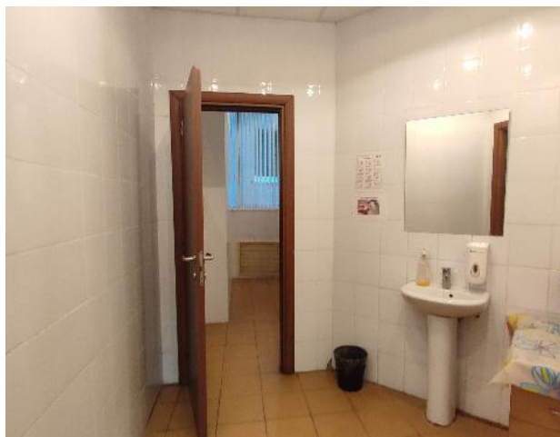
Фото 19. Внутренние помещения, 6 этаж.
