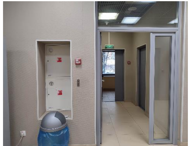
Фото 34. Внутренние помещения, 2 этаж.
