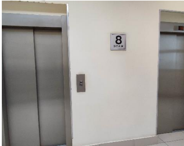
Фото 85. Внутренние помещения, 8 этаж.
