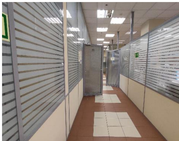
Фото 58. Внутренние помещения, 7 этаж.
