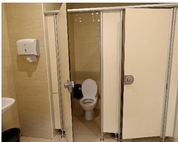
Фото 42. Состояние внутренних помещений (3 этаж)
