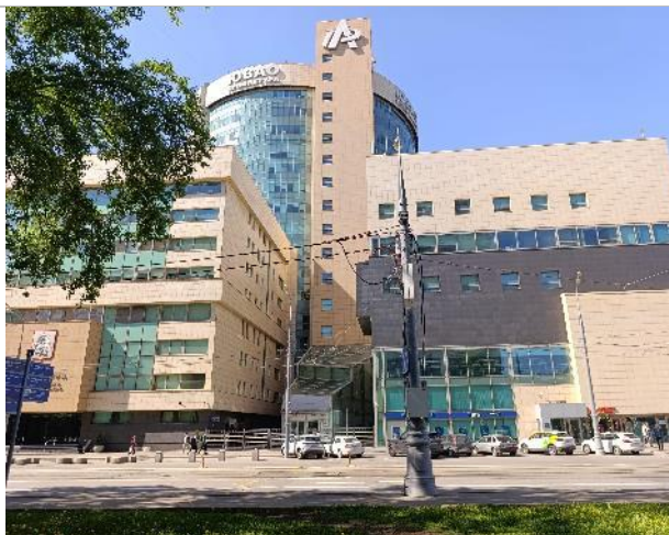
Фотография 2. Внешний вид здания
