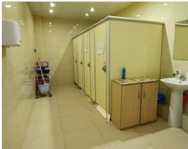
Фото 31. Состояние внутренних помещений (2 этаж)
