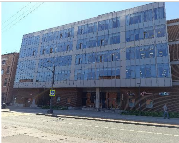
Фотография 14. Внешний вид здания
