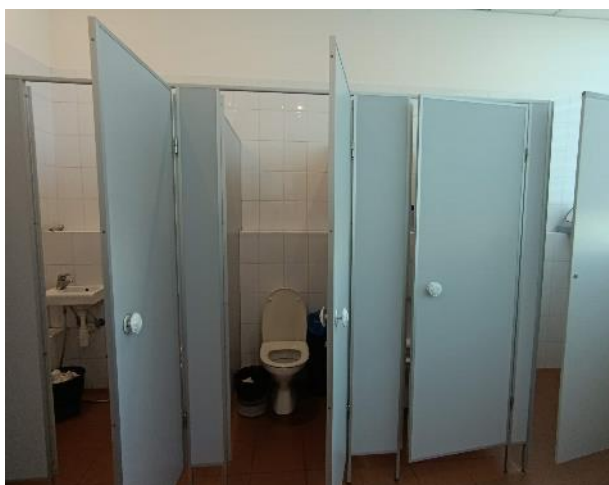
Фото 40. Состояние внутренних помещений (7 этаж)
