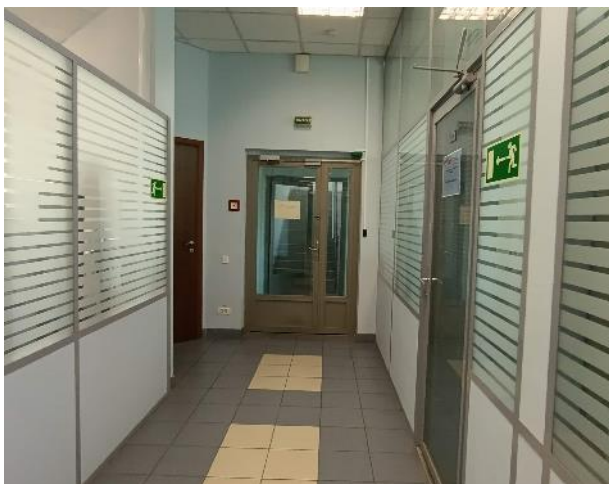
Фото 50. Состояние внутренних помещений (8 этаж)
