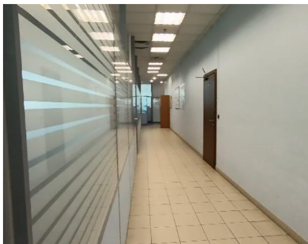
Фото 55. Состояние внутренних помещений (8 этаж)
