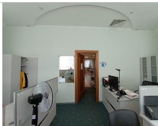
Фотография 12. Внутреннее состояние помещений — 9 этаж
