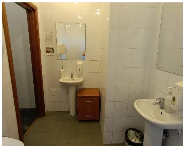
Фото 72. Состояние внутренних помещений (9 этаж)
