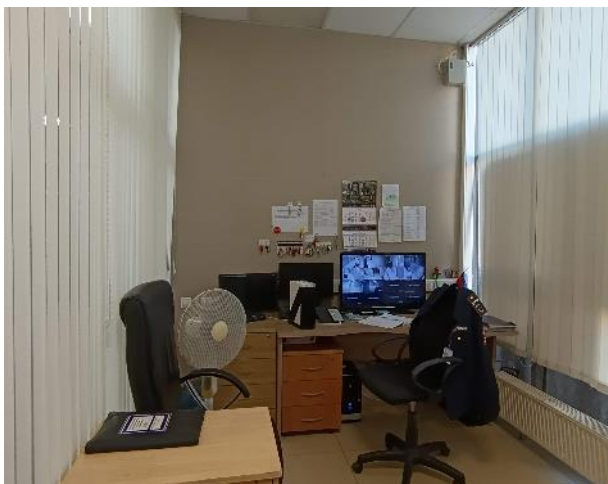
Фото 26. Состояние внутренних помещений (2 этаж)
