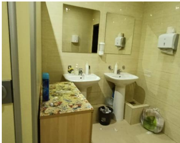
Фото 33. Состояние внутренних помещений (2 этаж)
