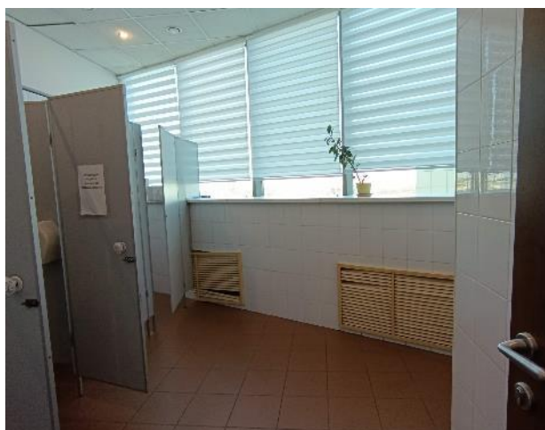
Фото 39. Состояние внутренних помещений (7 этаж)
