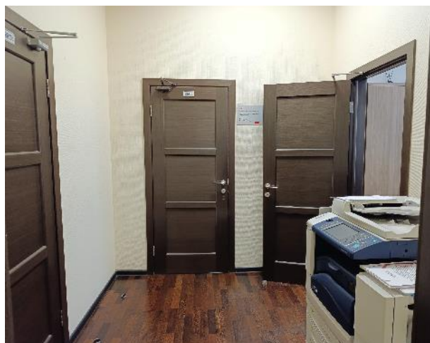
Фото 20. Состояние внутренних помещений (2 этаж)
