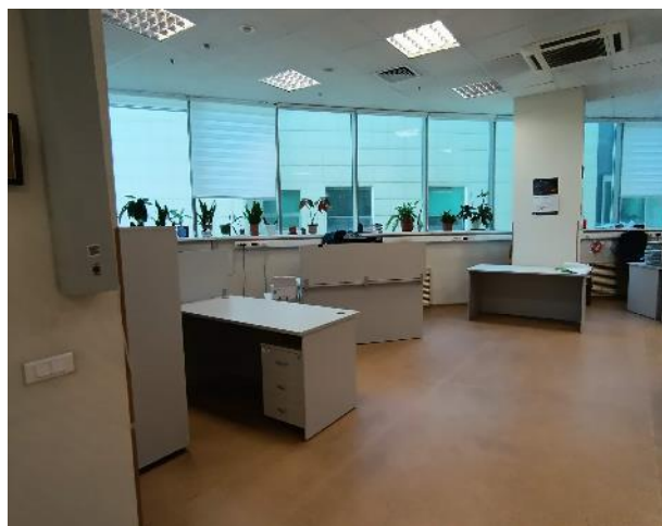
Фото 20. Состояние внутренних помещений (6 этаж)
