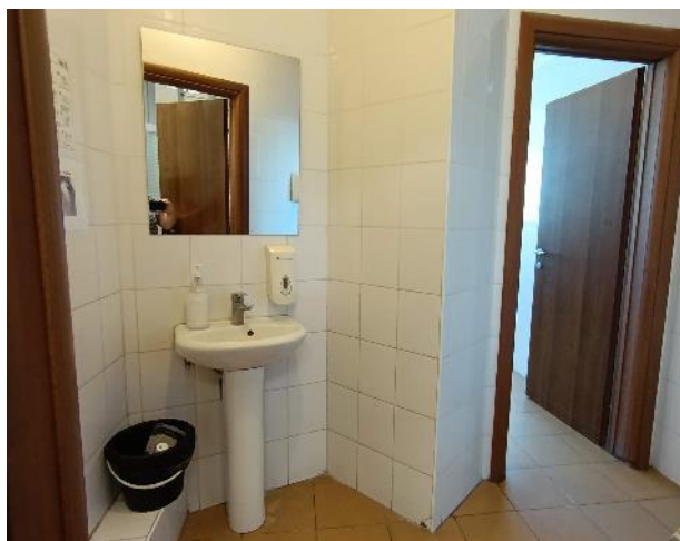
Фото 21. Состояние внутренних помещений (6 этаж)
