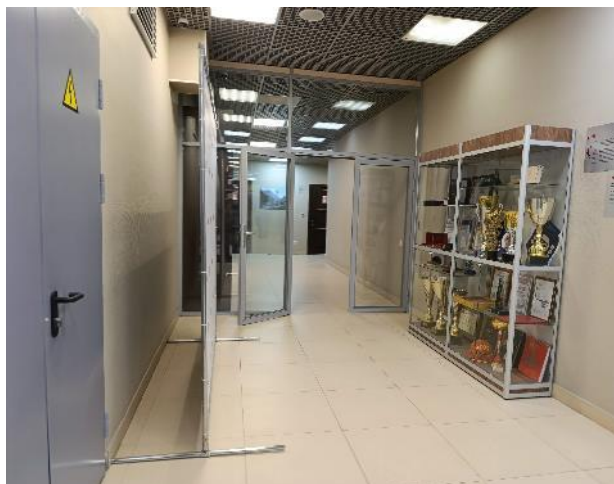
Фото 13. Состояние внутренних помещений (2 этаж)
