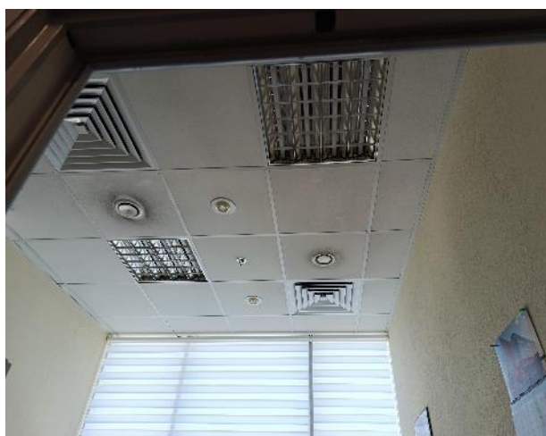
Фото 35. Состояние внутренних помещений (7 этаж)
