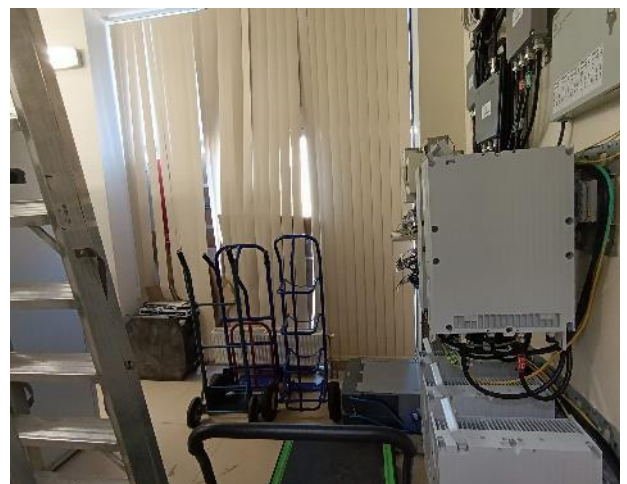
Фото 36. Состояние внутренних помещений (3 этаж)
