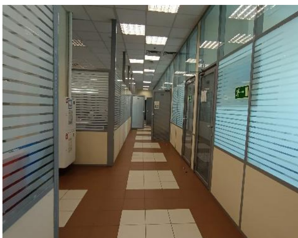
Фото 42. Состояние внутренних помещений (7 этаж)
