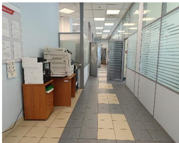
Фото 46. Состояние внутренних помещений (8 этаж)
