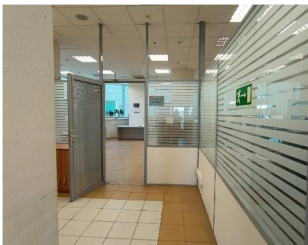
Фото 18. Состояние внутренних помещений (6 этаж)
