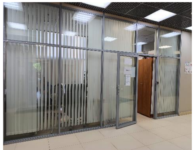
Фото 12. Состояние внутренних помещений (2 этаж)
