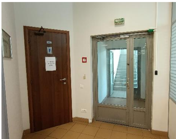
Фото 26. Состояние внутренних помещений (6 этаж)
