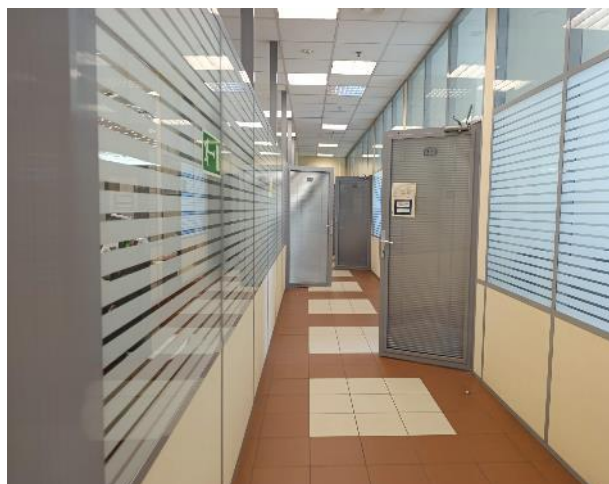
Фото 32. Состояние внутренних помещений (7 этаж)
