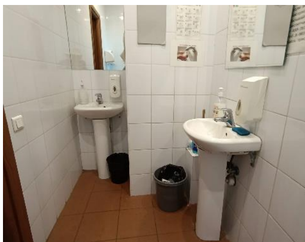
Фото 41. Состояние внутренних помещений (7 этаж)
