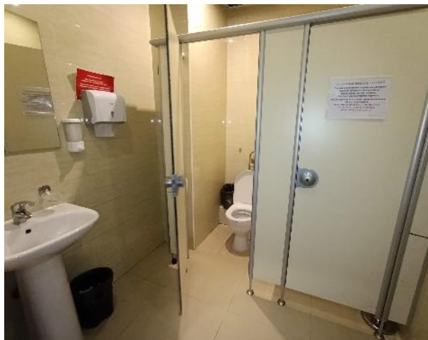
Фото 21. Состояние внутренних помещений (2 этаж)
