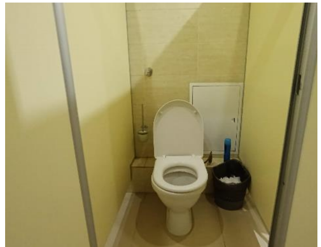
Фото 32. Состояние внутренних помещений (2 этаж)
