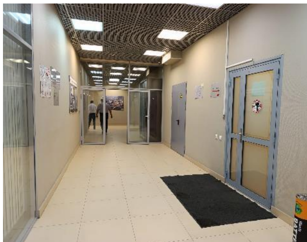
Фото 25. Состояние внутренних помещений (2 этаж)
