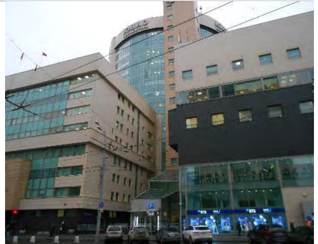
Фото 4. Фасад, подъездные пути
