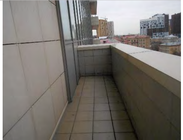
Фото 182. Помещения 8-го этажа
