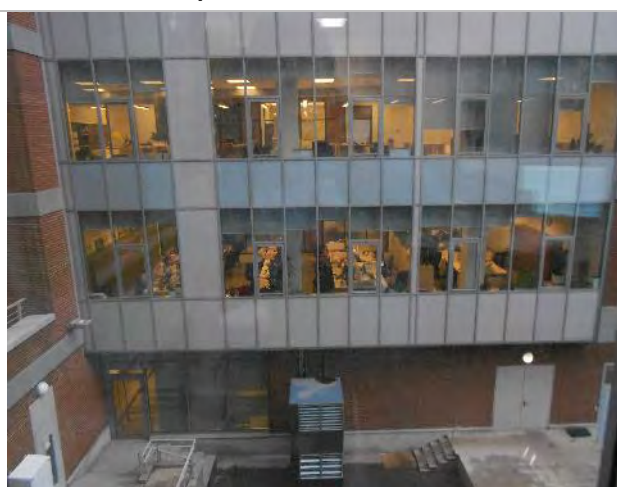
Фото 332. Помещения 3-го этажа
