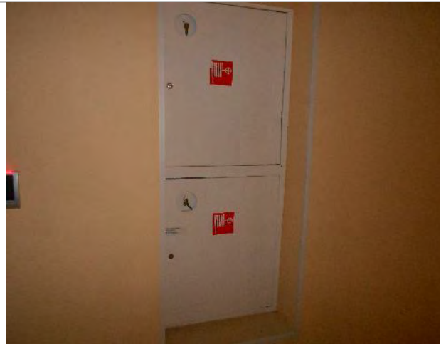
Фото 377. Помещения 4-го этажа
