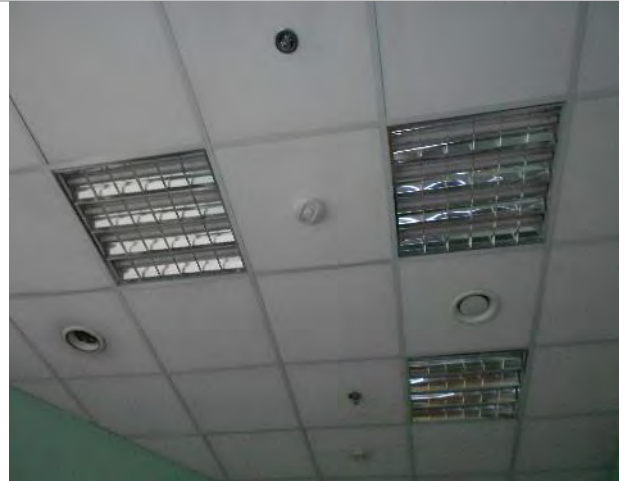
Фото 218. Помещения 9-го этажа
