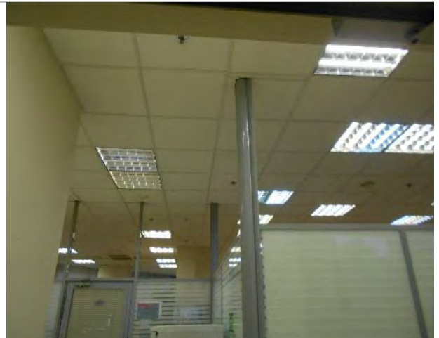
Фото 54. Помещения 6-го этажа
