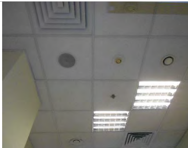
Фото 191. Помещения 8-го этажа
