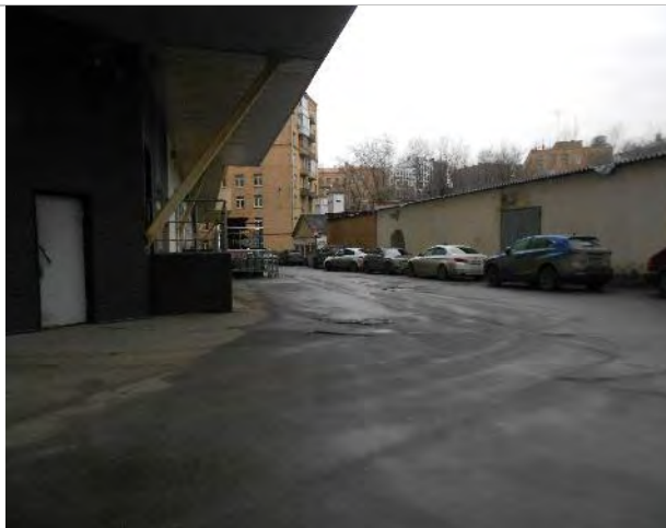
Фото 12. Фасад, подъездные пути
