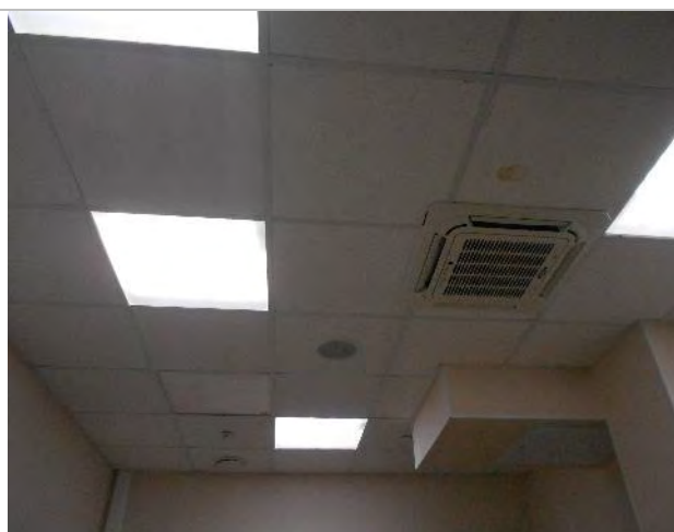
Фото 296. Помещения 3-го этажа
