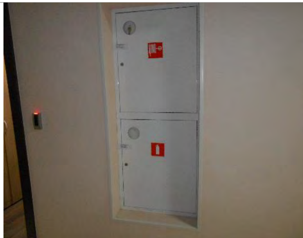
Фото 328. Помещения 3-го этажа
