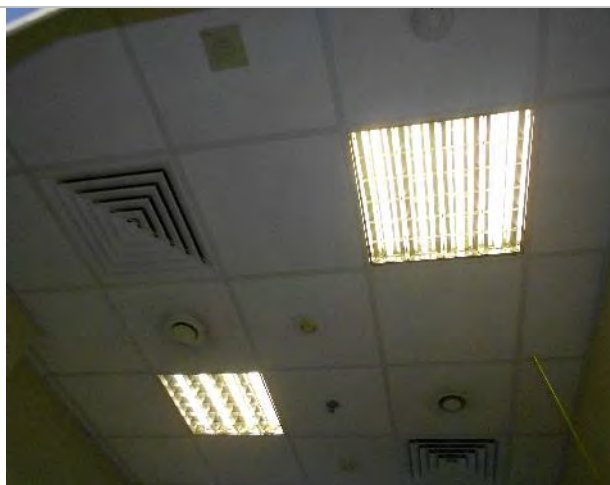
Фото 111. Помещения 7-го этажа
