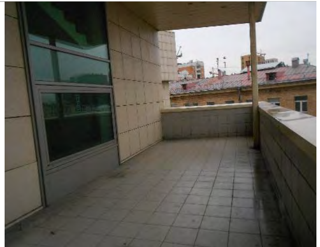
Фото 122. Помещения 7-го этажа
