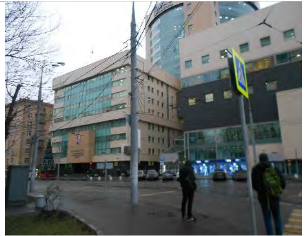
Фото 2. Фасад, подъездные пути
