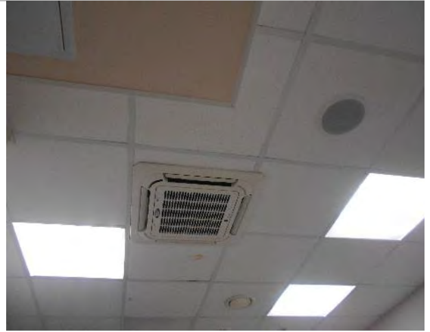
Фото 301. Помещения 3-го этажа
