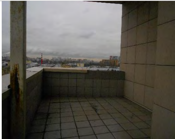
Фото 137. Помещения 7-го этажа
