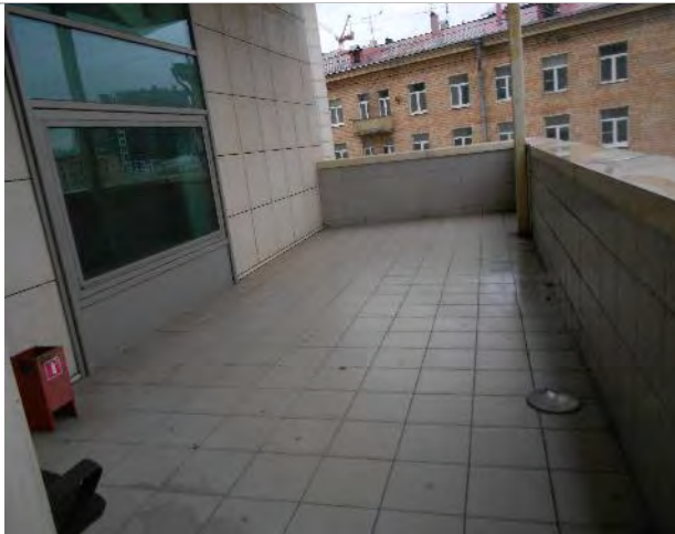
Фото 79. Помещения 6-го этажа
