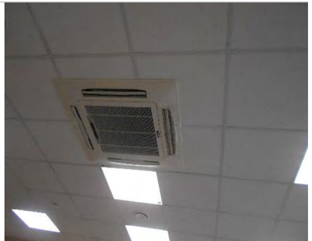
Фото 363. Помещения 4-го этажа
