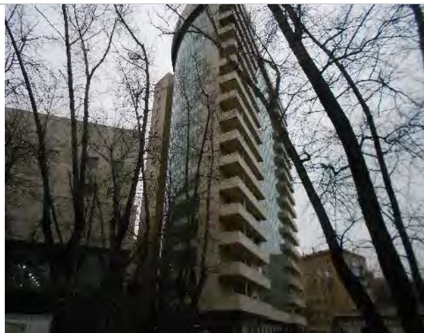
Фотография 3. Внешний вид здания
