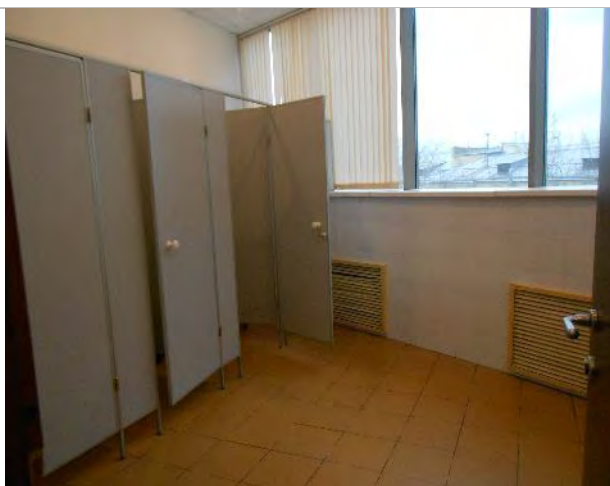
Фото 44. Помещения 6-го этажа
