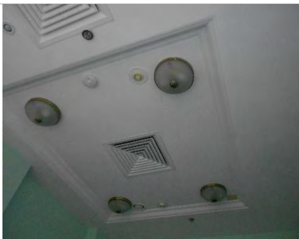
Фото 212. Помещения 9-го этажа
