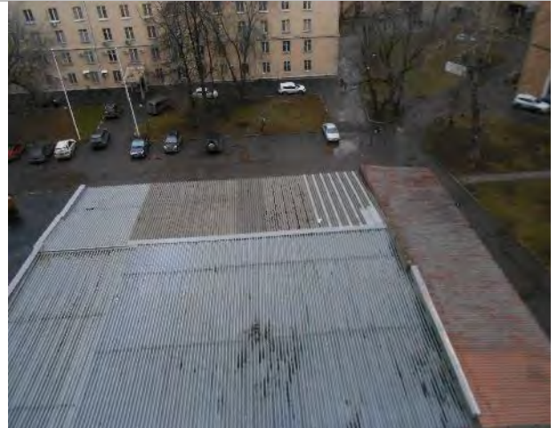
Фото 50. Помещения 6-го этажа
