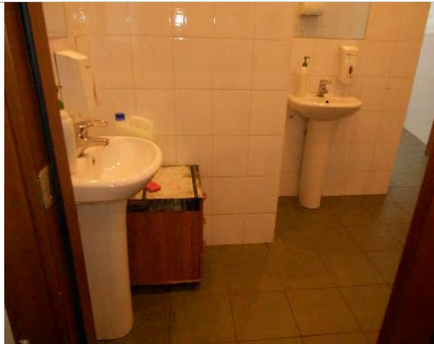
Фото 245. Помещения 9-го этажа
