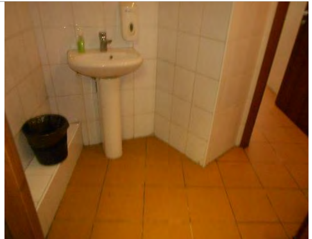
Фото 42. Помещения 6-го этажа
