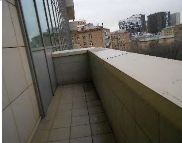
Фото 49. Помещения 6-го этажа
