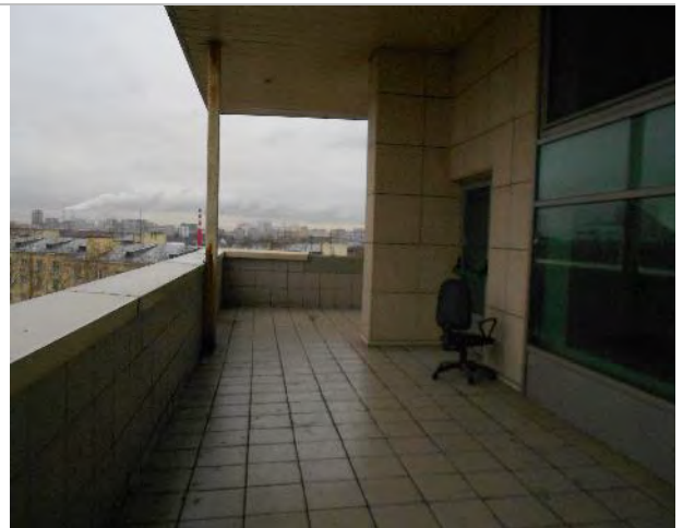
Фото 136. Помещения 7-го этажа
