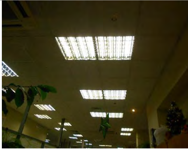
Фото 97. Помещения 7-го этажа
