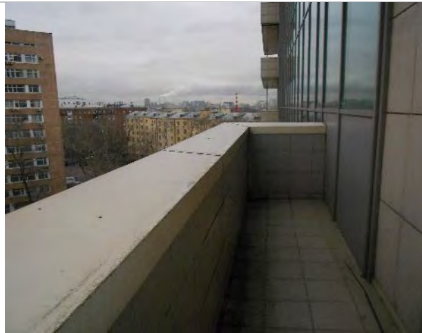
Фото 121. Помещения 7-го этажа
