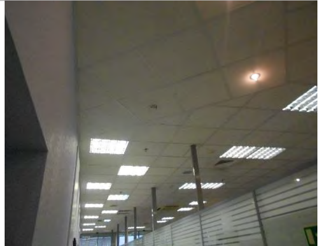
Фото 158. Помещения 8-го этажа
