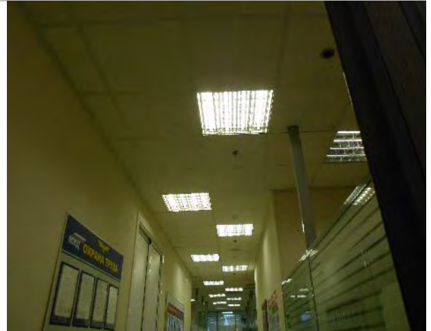
Фото 26. Помещения 6-го этажа
