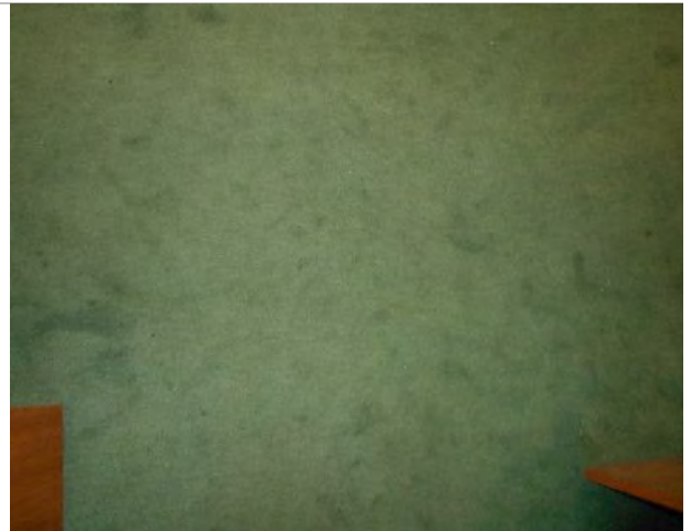
Фото 234. Помещения 9-го этажа
