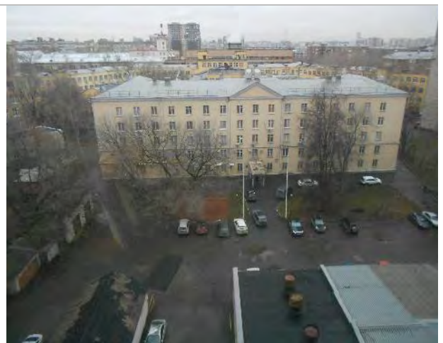
Фото 112. Помещения 7-го этажа
