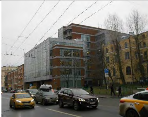
Фотография 21. Внешний вид здания
