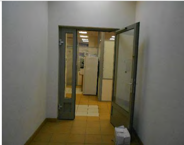
Фото 53. Помещения 6-го этажа
