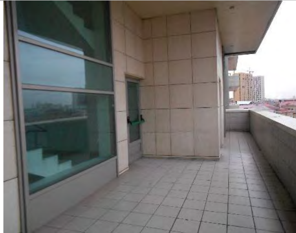
Фото 181. Помещения 8-го этажа
