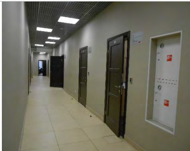
Фото 266. Помещения 2-го этажа
