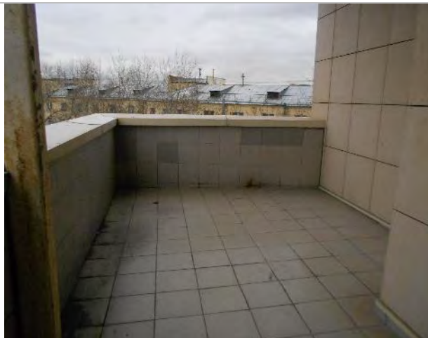
Фото 51. Помещения 6-го этажа
