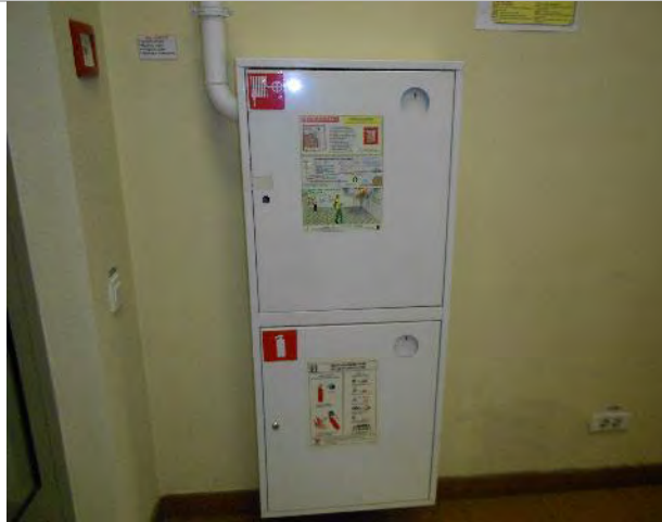
Фото 133. Помещения 7-го этажа
