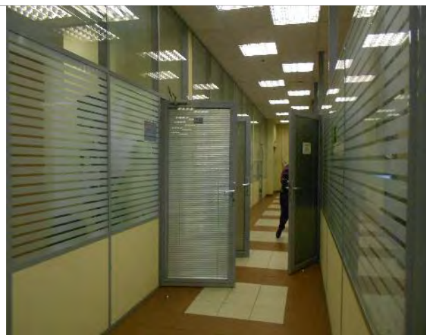
Фото 103. Помещения 7-го этажа
