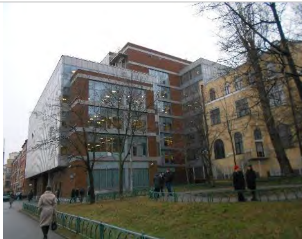
Фото 254. Фасад, подъездные пути
