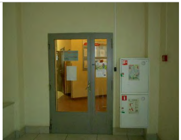
Фото 88. Помещения 7-го этажа
