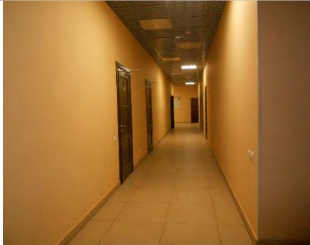
Фотография 31. Внутреннее состояние помещений — 4 этаж
