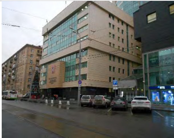
Фото 5. Фасад, подъездные пути
