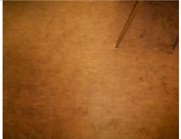
Фото 110. Помещения 7-го этажа
