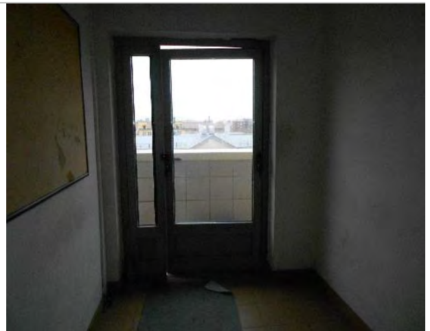
Фото 76. Помещения 6-го этажа
