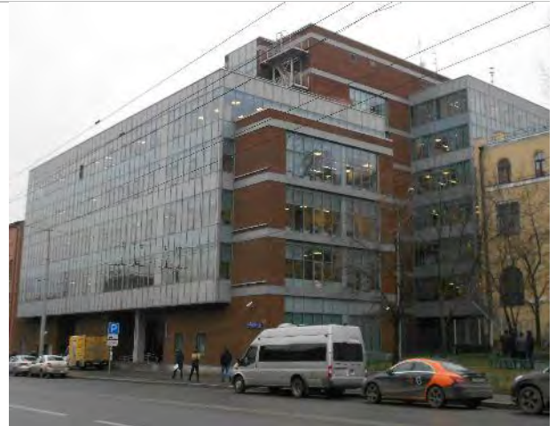
Фотография 22. Внешний вид здания
