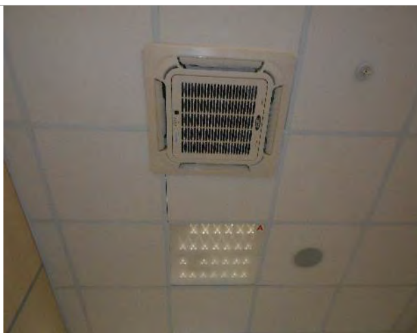
Фото 331. Помещения 3-го этажа
