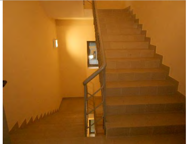
Фото 325. Помещения 3-го этажа
