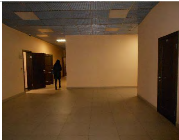
Фото 346. Помещения 4-го этажа
