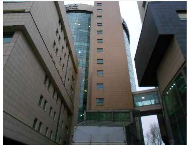
Фото 6. Фасад, подъездные пути
