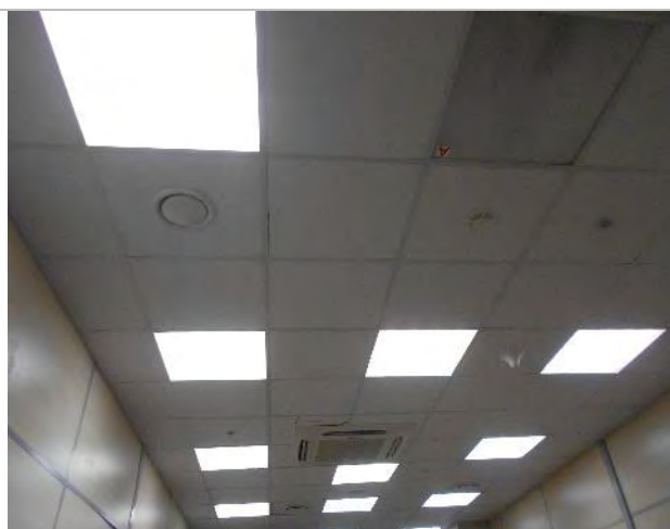
Фото 272. Помещения 2-го этажа
