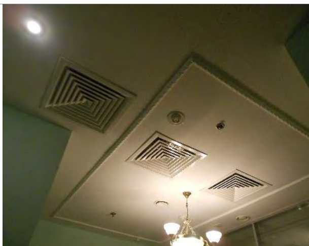
Фото 240. Помещения 9-го этажа
