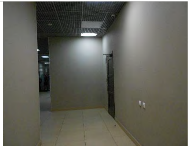
Фото 279. Помещения 2-го этажа
