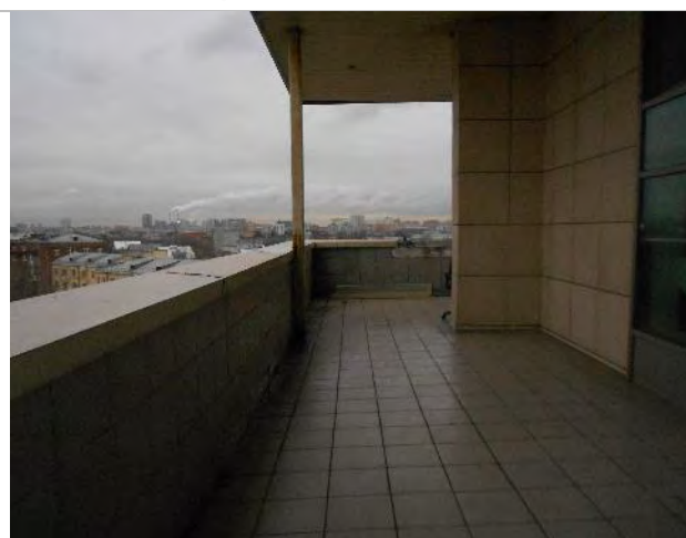
Фото 179. Помещения 8-го этажа
