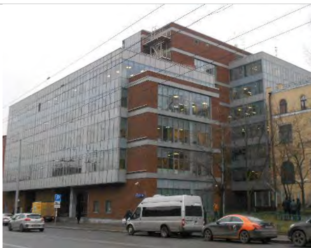
Фото 251. Фасад, подъездные пути
