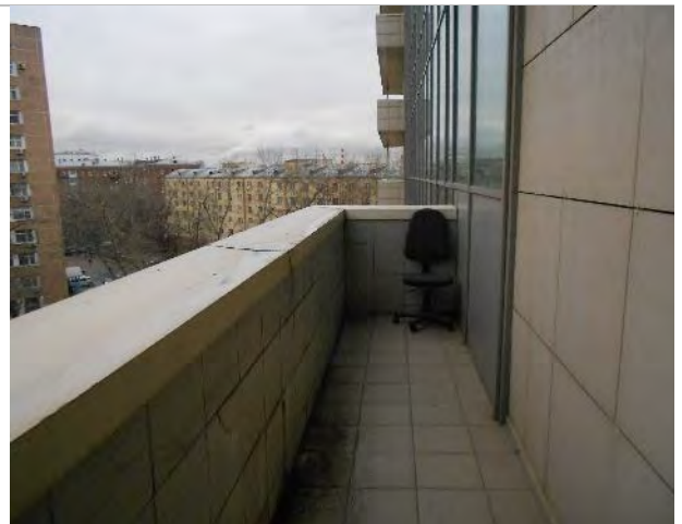
Фото 78. Помещения 6-го этажа
