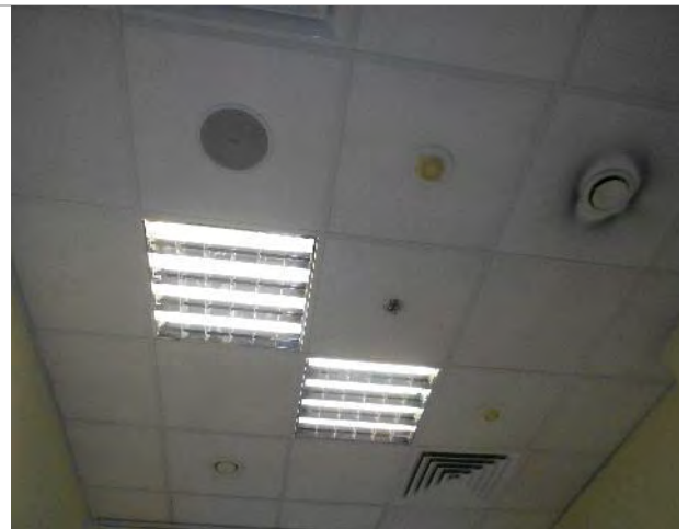
Фото 174. Помещения 8-го этажа
