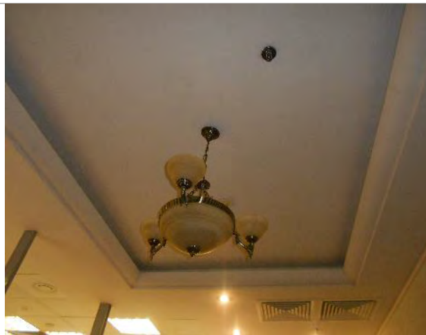
Фото 215. Помещения 9-го этажа
