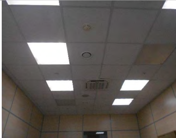
Фото 312. Помещения 3-го этажа
