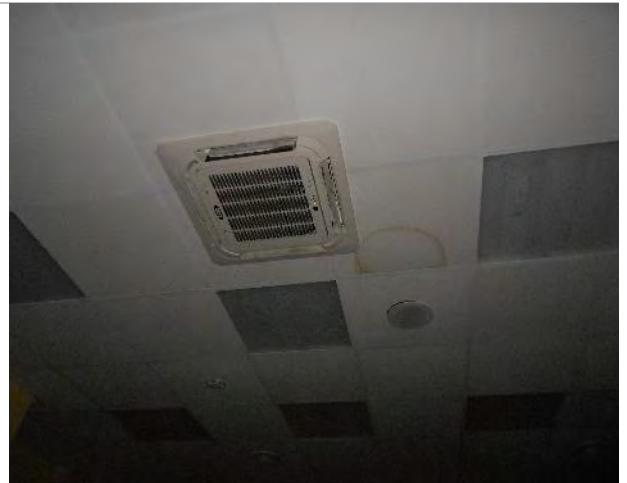
Фото 353. Помещения 4-го этажа
