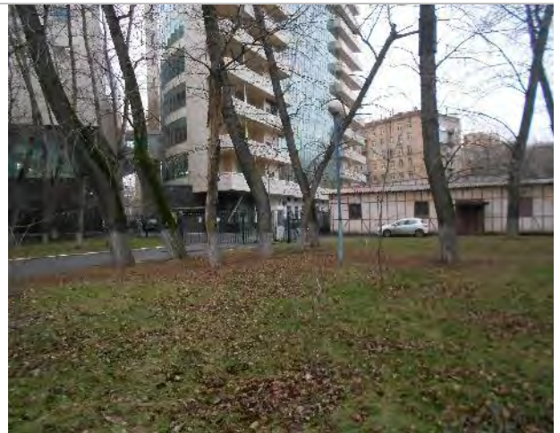
Фото 16. Фасад, подъездные пути
