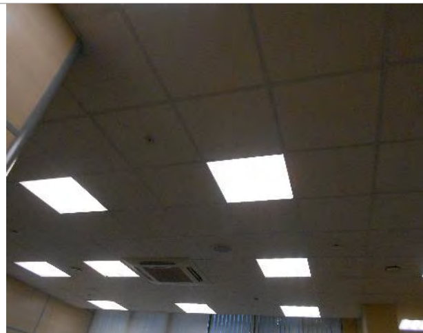
Фото 359. Помещения 4-го этажа
