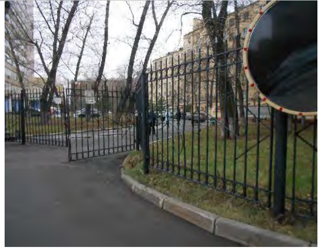
Фото 14. Фасад, подъездные пути
