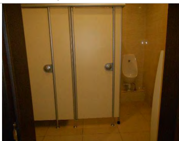
Фото 368. Помещения 4-го этажа
