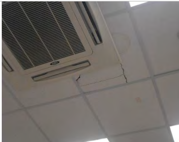
Фото 278. Помещения 2-го этажа
