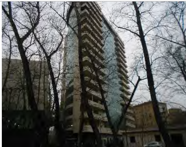
Фото 15. Фасад, подъездные пути
