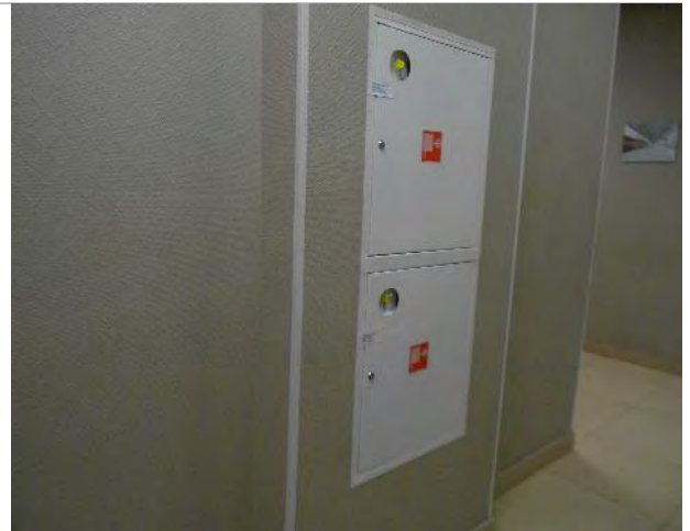
Фото 269. Помещения 2-го этажа
