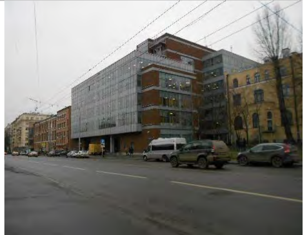
Фото 253. Фасад, подъездные пути
