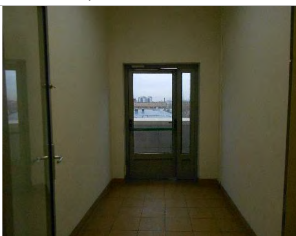
Фото 46. Помещения 6-го этажа
