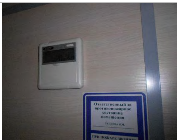
Фото 308. Помещения 3-го этажа
