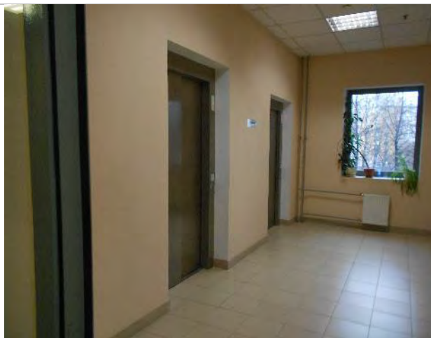
Фото 342. Помещения 4-го этажа
