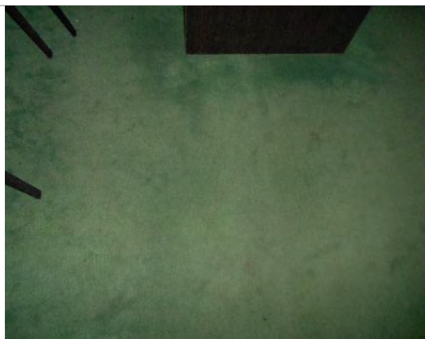
Фото 210. Помещения 9-го этажа
