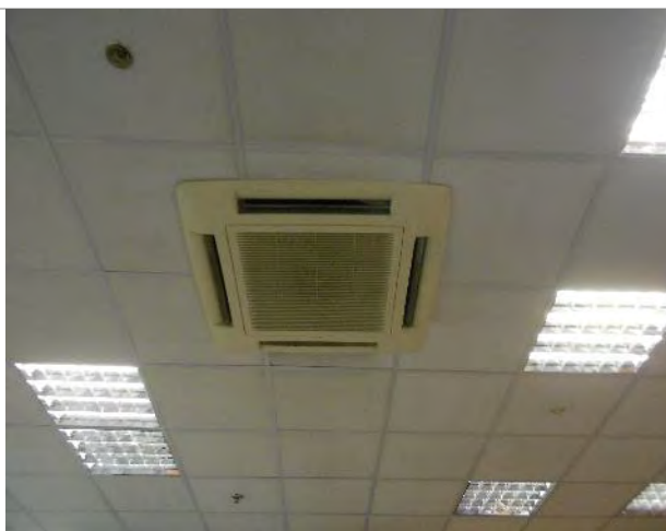
Фото 168. Помещения 8-го этажа
