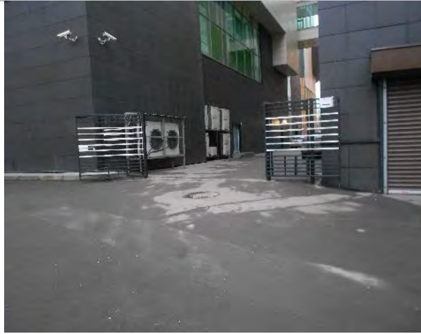
Фото 13. Фасад, подъездные пути
