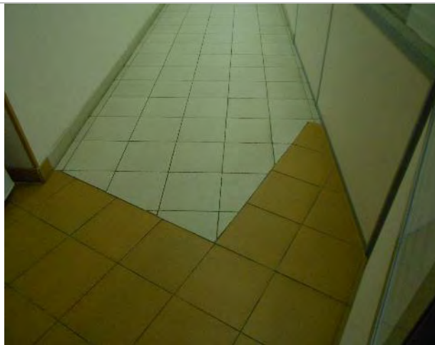
Фото 27. Помещения 6-го этажа
