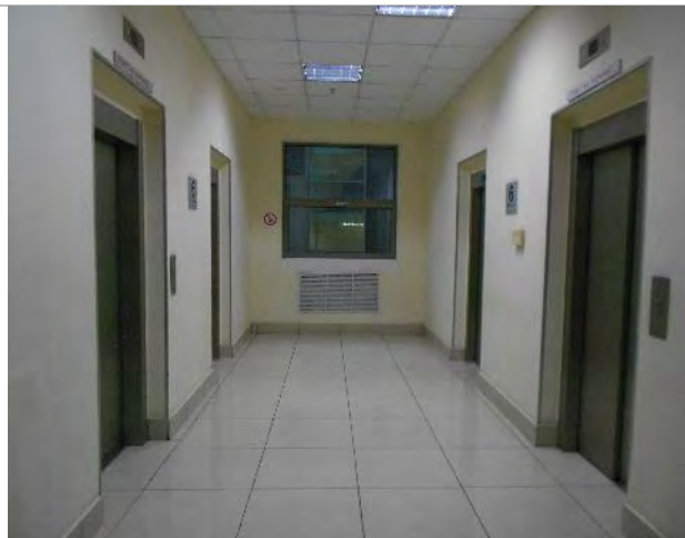
Фотография 5. Внутреннее состояние помещений — 6 этаж
