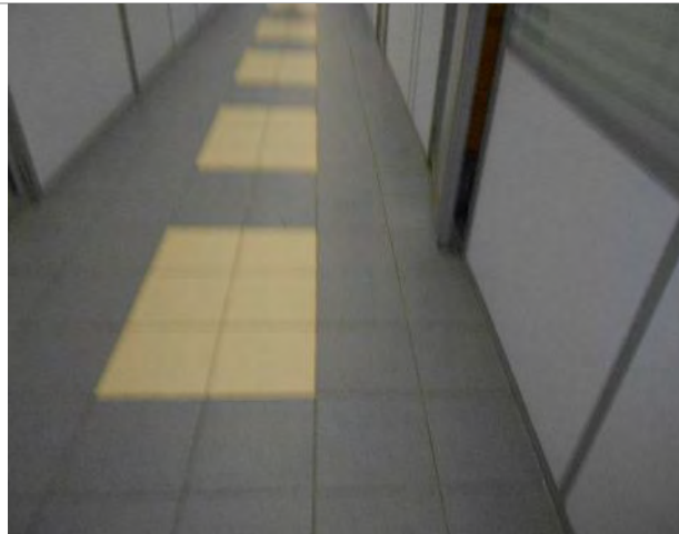
Фото 185. Помещения 8-го этажа
