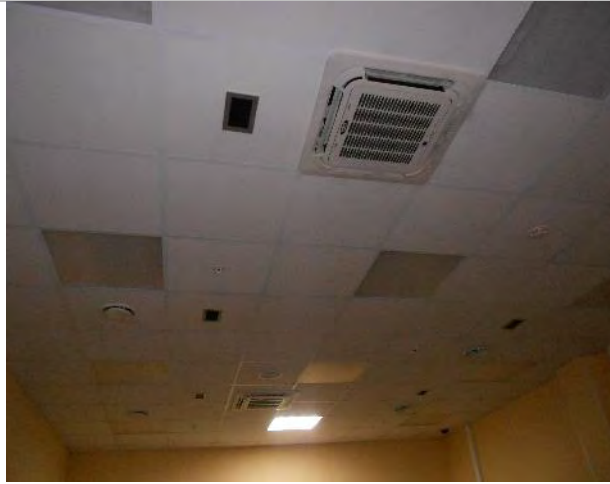
Фото 372. Помещения 4-го этажа
