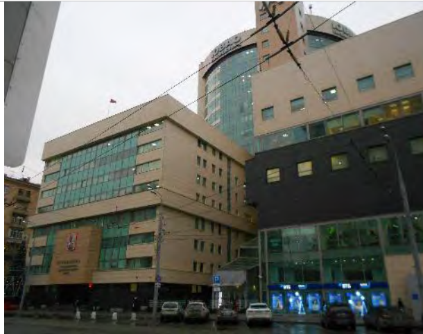
Фото 3. Фасад, подъездные пути
