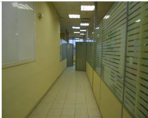
Фотография 9. Внутреннее состояние помещений — 7 этаж
