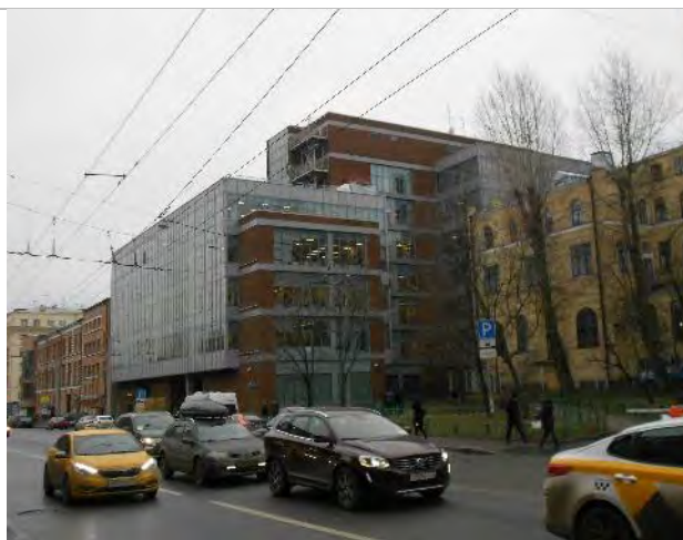
Фото 250. Фасад, подъездные пути
