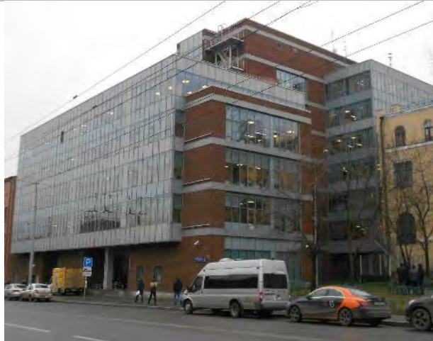
Фото 252. Фасад, подъездные пути
