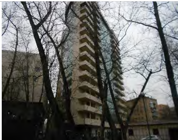
Фото 17. Фасад, подъездные пути
