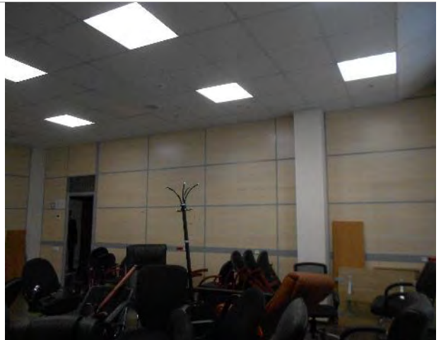
Фото 317. Помещения 3-го этажа
