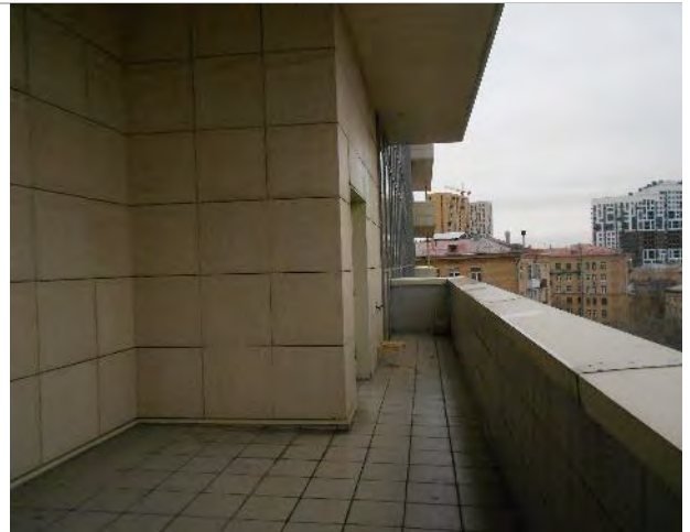
Фото 138. Помещения 7-го этажа
