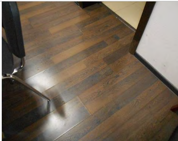
Фото 302. Помещения 3-го этажа
