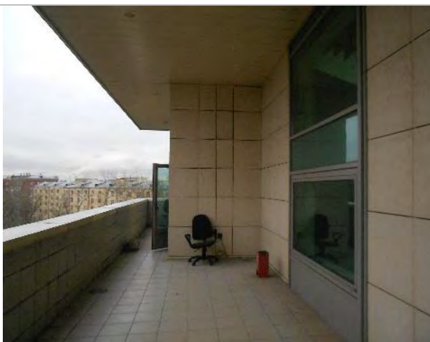
Фото 81. Помещения 6-го этажа
