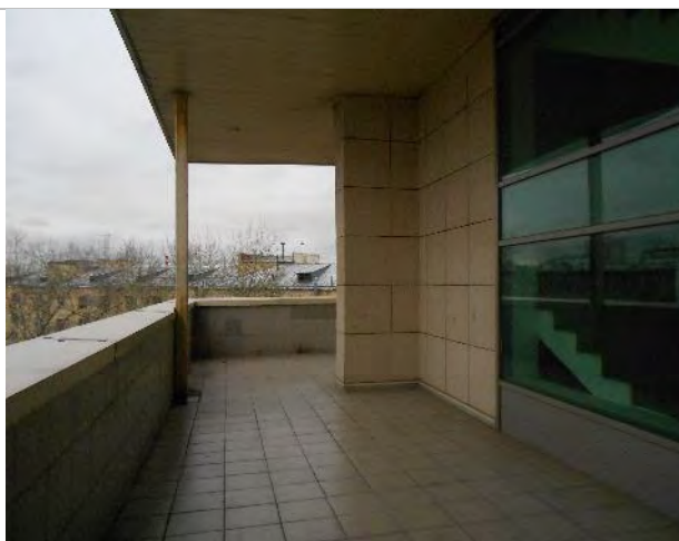
Фото 48. Помещения 6-го этажа
