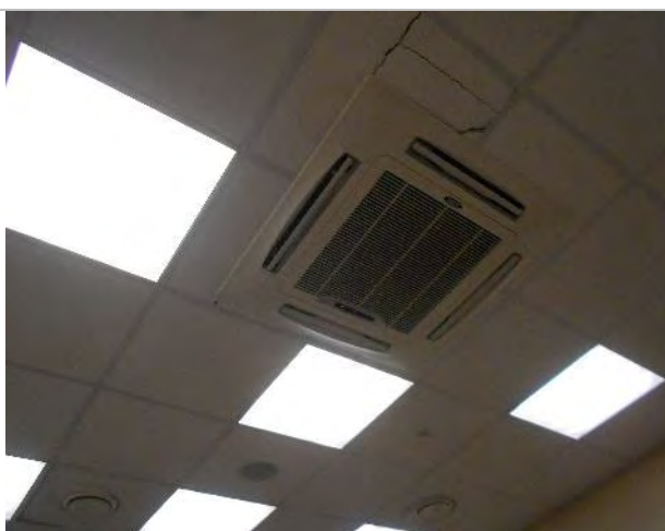
Фото 273. Помещения 2-го этажа
