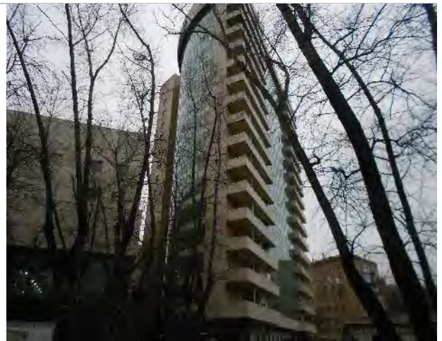
Фото 18. Фасад, подъездные пути
