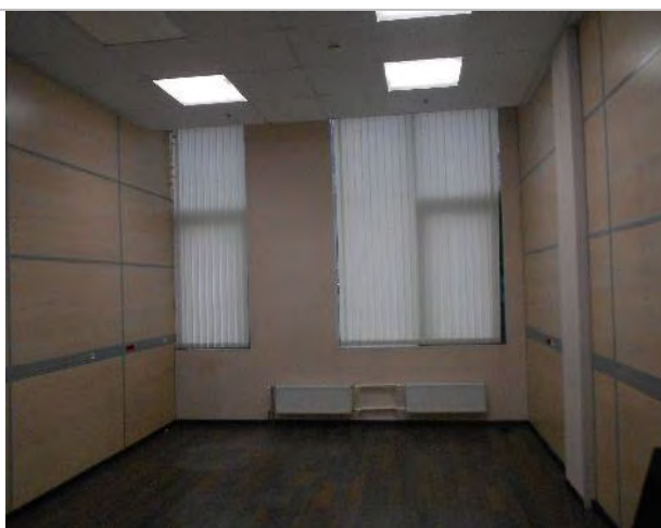
Фото 309. Помещения 3-го этажа
