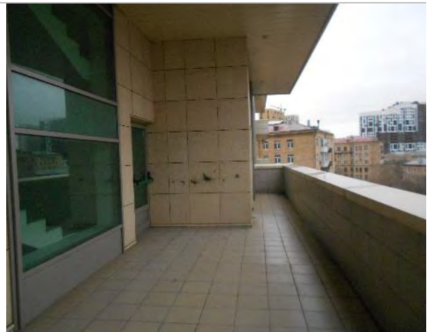
Фото 52. Помещения 6-го этажа
