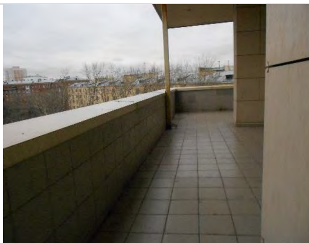
Фото 47. Помещения 6-го этажа
