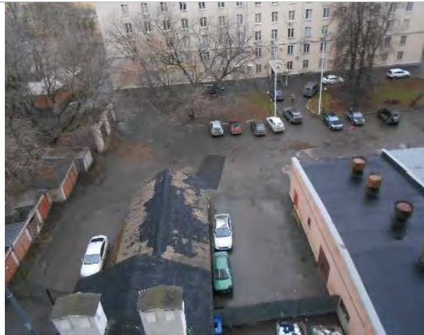
Фото 80. Помещения 6-го этажа
