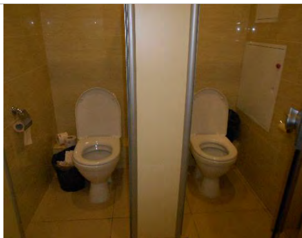
Фото 366. Помещения 4-го этажа
