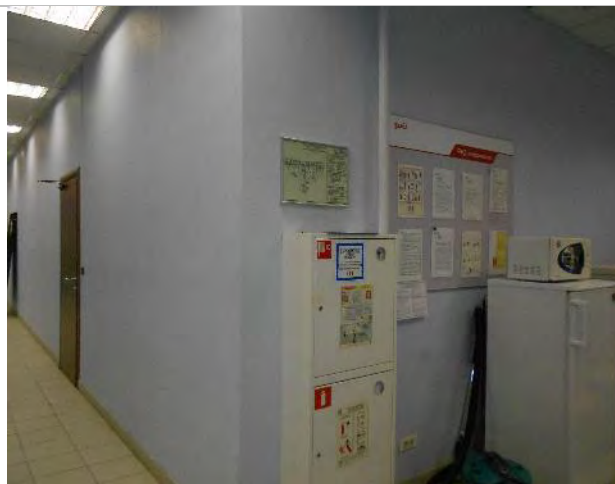
Фото 187. Помещения 8-го этажа
