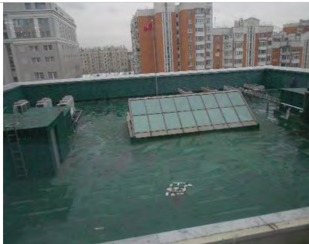
Фото 221. Помещения 9-го этажа
