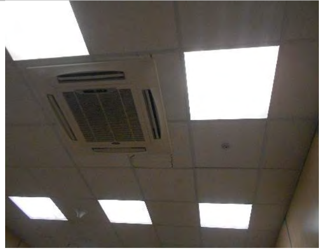
Фото 277. Помещения 2-го этажа
