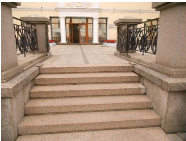
Фотография 143. Внешний вид здания
