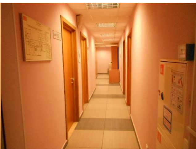
Фотография 64. Внутреннее состояние помещений, входящих в состав объекта оценки
