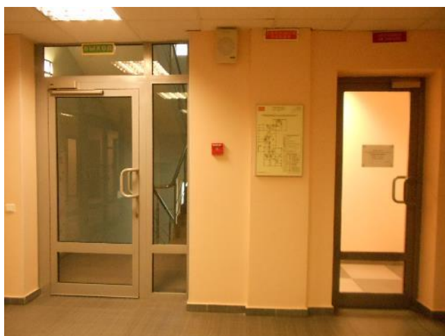
Фотография 77. Внутреннее состояние помещений, входящих в состав объекта оценки
