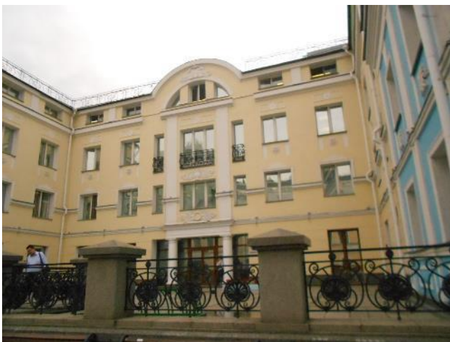
Фотография 139. Внешний вид здания
