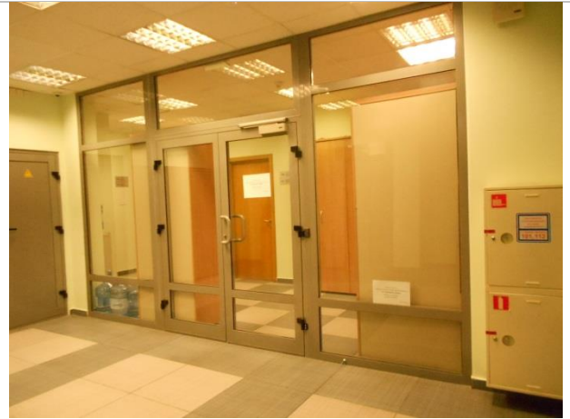
Фотография 3.14. Внутреннее состояние помещений 4 этажа, входящих в состав объекта оценки
