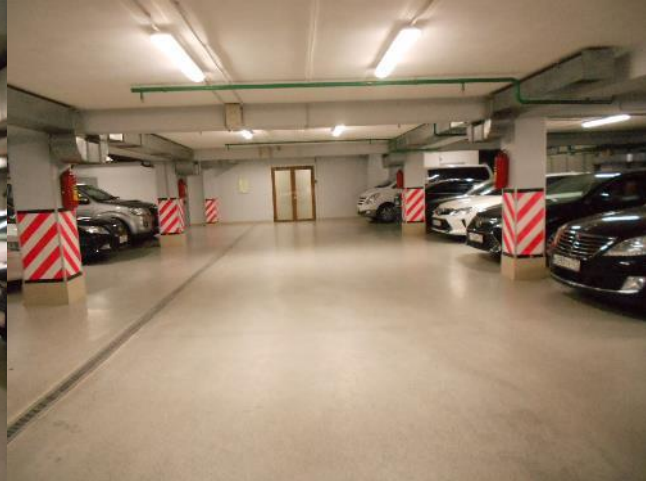
Фотография 128. Внутреннее состояние помещений подземного паркинга, входящих в состав объекта оценки
