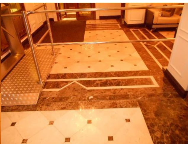
Фотография 28. Внутреннее состояние помещений, входящих в состав объекта оценки
