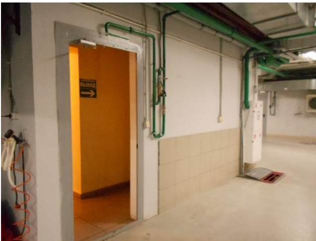
Фотография 129. Внутреннее состояние помещений подземного паркинга, входящих в состав объекта оценки
