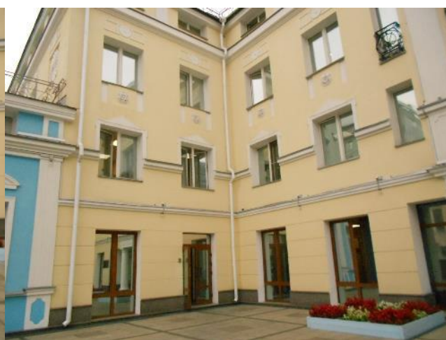
Фотография 148. Внешний вид здания
