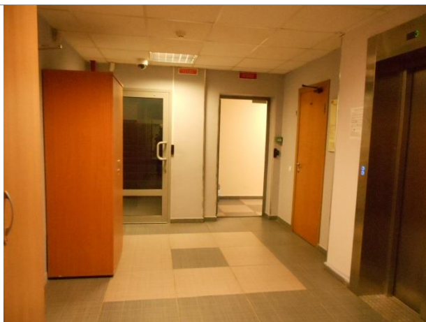
Фотография 3.8. Внутреннее состояние помещений 1 этажа, входящих в состав объекта оценки
