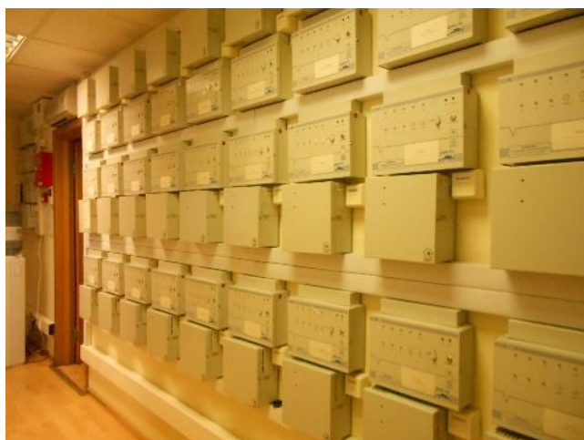
Фотография 15. Внутреннее состояние помещений, входящих в состав объекта оценки
