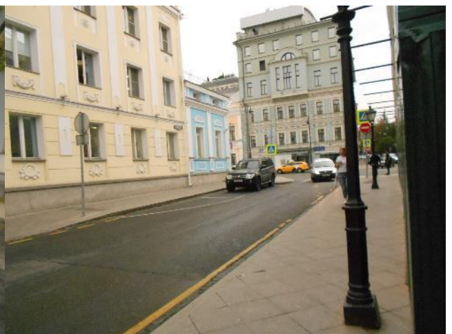
Фотография 156. Внешний вид здания
