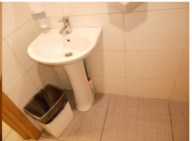
Фотография 120. Внутреннее состояние помещений, входящих в состав объекта оценки
