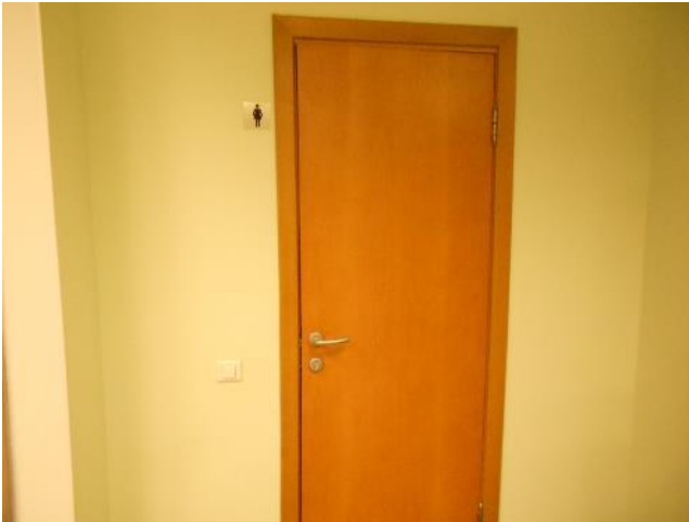
Фотография 117. Внутреннее состояние помещений, входящих в состав объекта оценки
