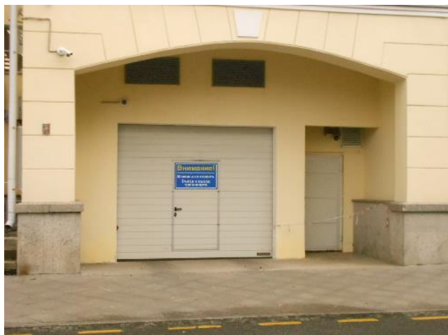
Фотография 157. Внешний вид здания
