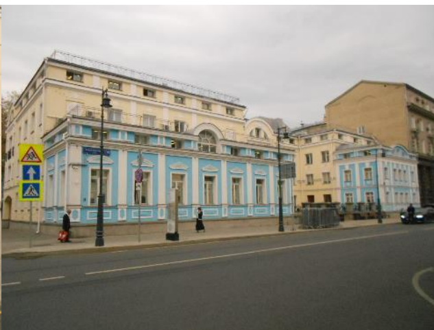
Фотография 158. Внешний вид здания
