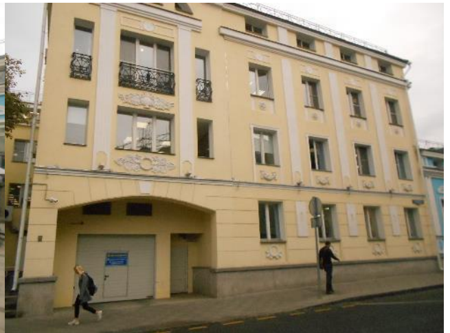
Фотография 154. Внешний вид здания
