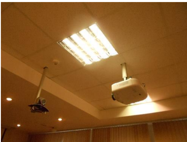
Фотография 91. Внутреннее состояние помещений, входящих в состав объекта оценки
