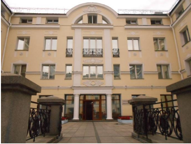
Фотография 3.1. Внешний вид здания
