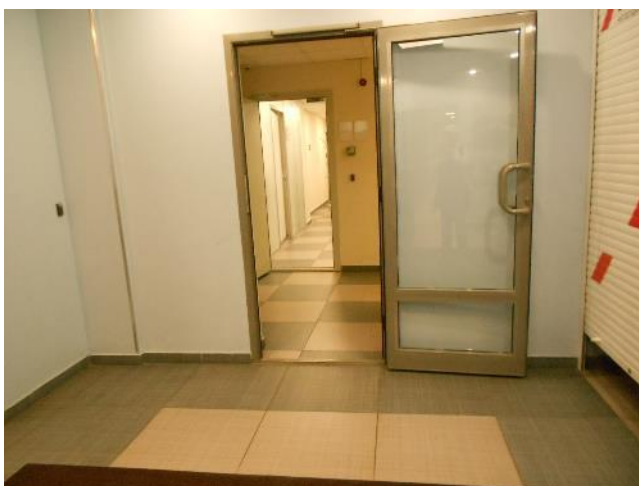
Фотография 39. Внутреннее состояние помещений, входящих в состав объекта оценки
