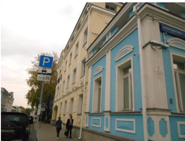
Фотография 141. Внешний вид здания
