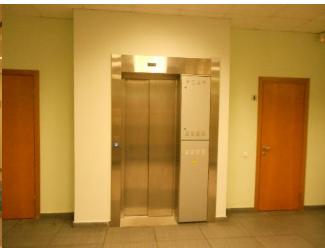
Фотография 114. Внутреннее состояние помещений, входящих в состав объекта оценки
