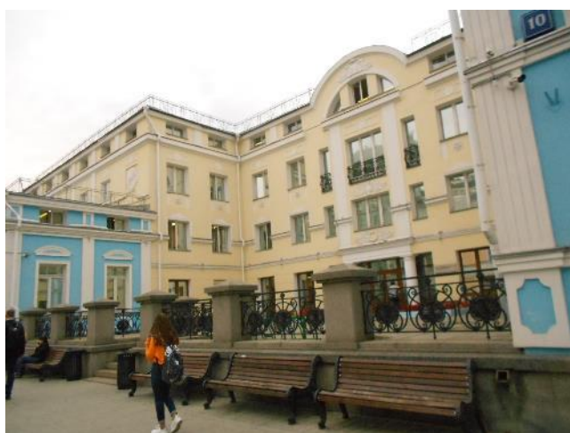
Фотография 137. Внешний вид здания
