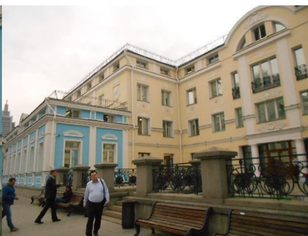
Фотография 138. Внешний вид здания
