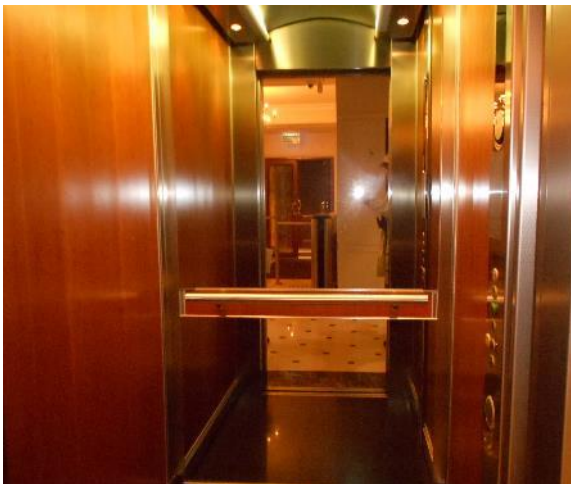
Фотография 33. Внутреннее состояние помещений, входящих в состав объекта оценки
