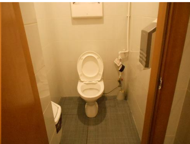
Фотография 98. Внутреннее состояние помещений, входящих в состав объекта оценки
