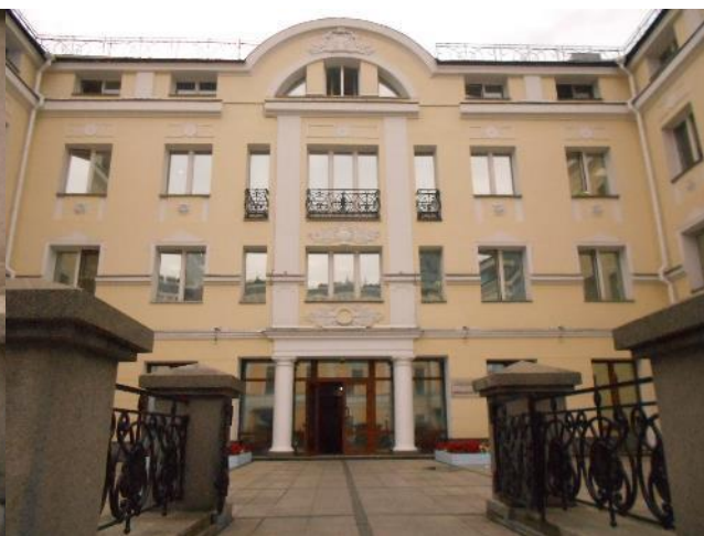
Фотография 144. Внешний вид здания
