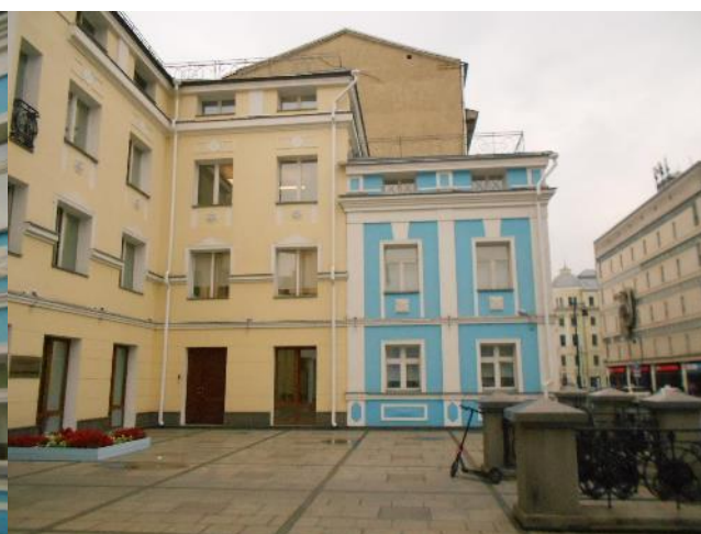
Фотография 150. Внешний вид здания
