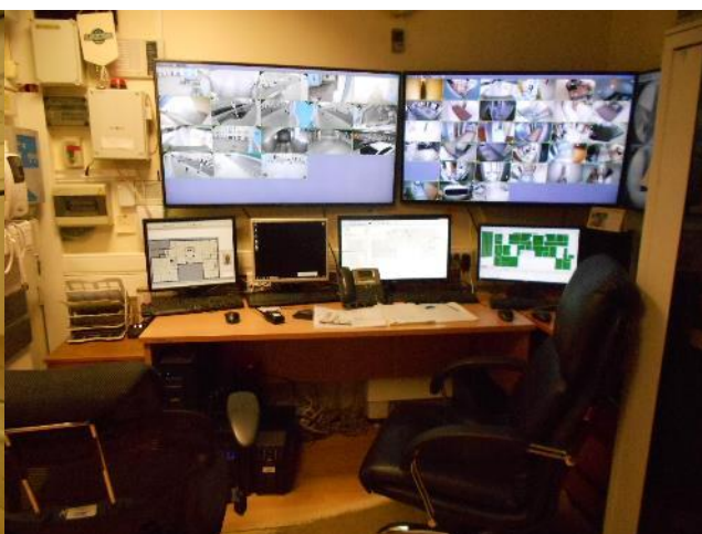
Фотография 16. Внутреннее состояние помещений, входящих в состав объекта оценки
