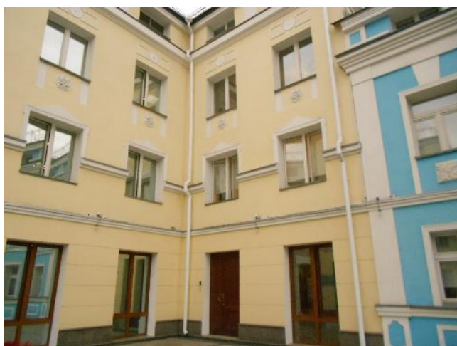
Фотография 149. Внешний вид здания
