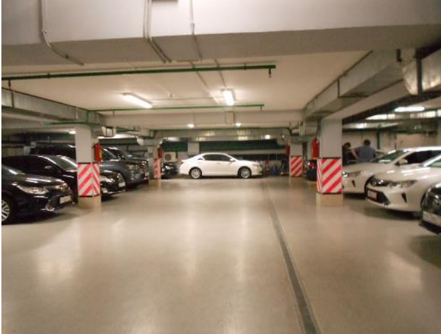
Фотография 127. Внутреннее состояние помещений подземного паркинга, входящих в состав объекта оценки
