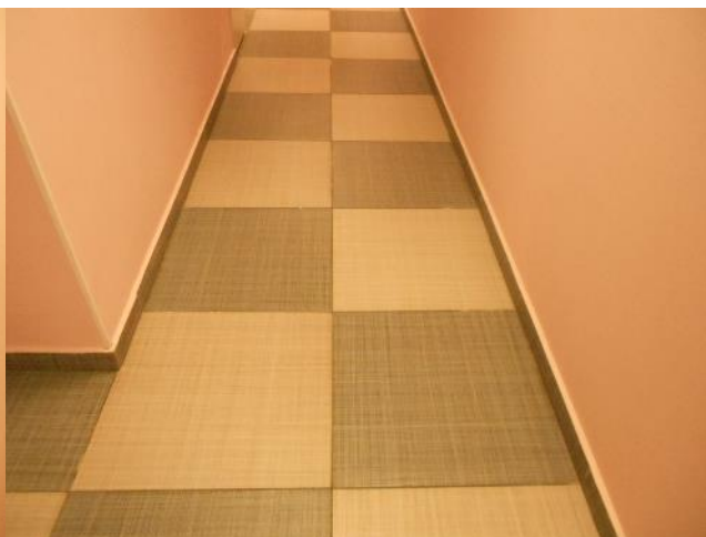
Фотография 50. Внутреннее состояние помещений, входящих в состав объекта оценки
