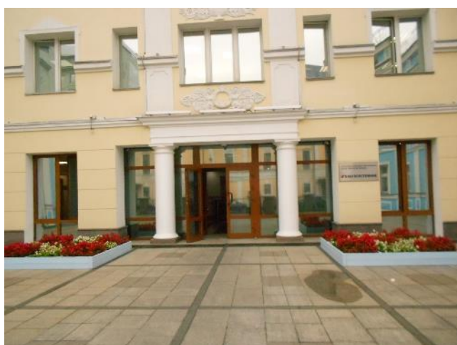
Фотография 147. Внешний вид здания
