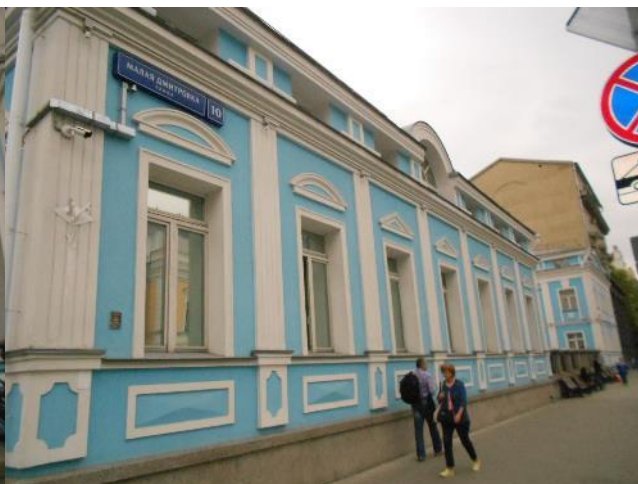
Фотография 140. Внешний вид здания
