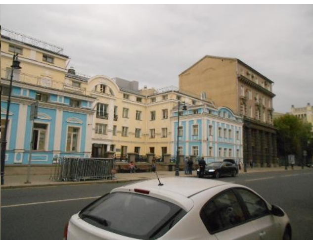
Фотография 160. Внешний вид здания
