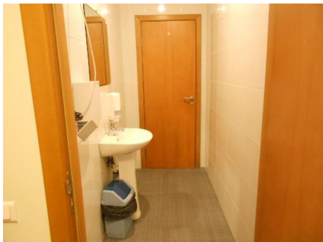
Фотография 97. Внутреннее состояние помещений, входящих в состав объекта оценки
