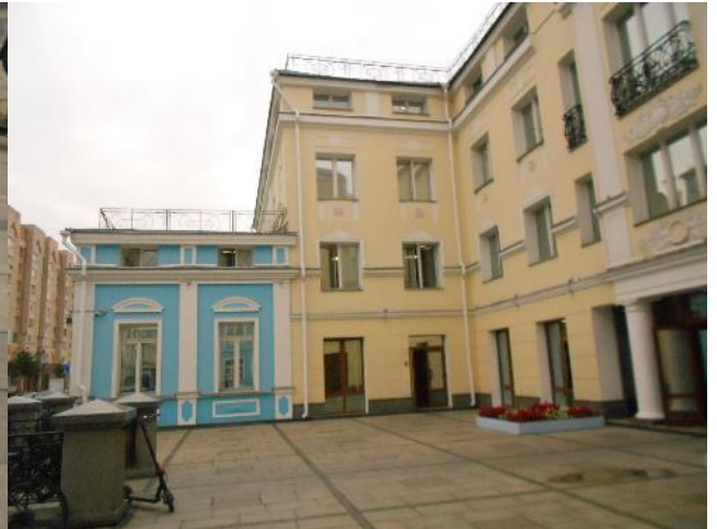
Фотография 152. Внешний вид здания
