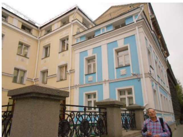
Фотография 145. Внешний вид здания
