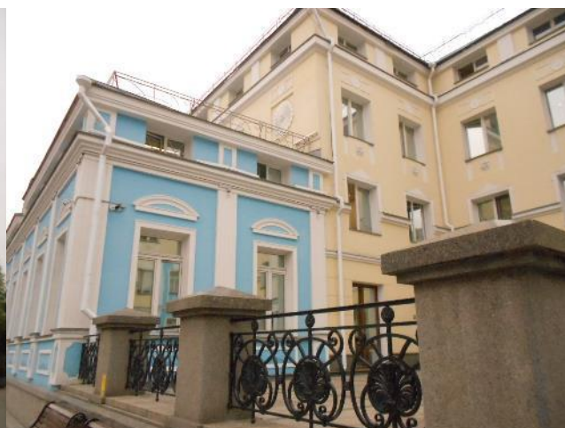
Фотография 146. Внешний вид здания
