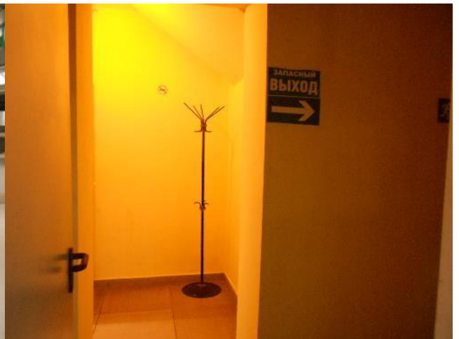
Фотография 130. Внутреннее состояние помещений подземного паркинга, входящих в состав объекта оценки
