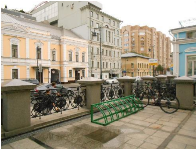
Фотография 153. Внешний вид здания
