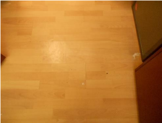
Фотография 105. Внутреннее состояние помещений, входящих в состав объекта оценки
