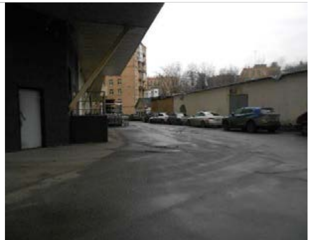
Фото 12. Фасад, подъездные пути
