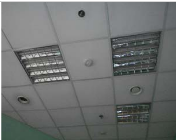
Фото 218. Помещения 9-го этажа
