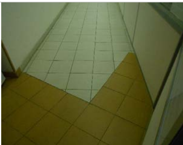
Фото 27. Помещения 6-го этажа
