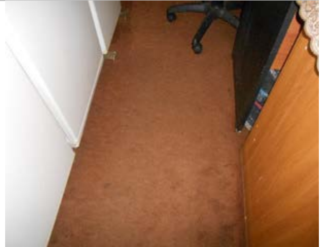
Фото 116. Помещения 7-го этажа
