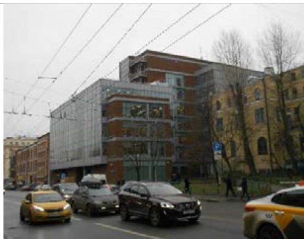
Фотография 21. Внешний вид здания
