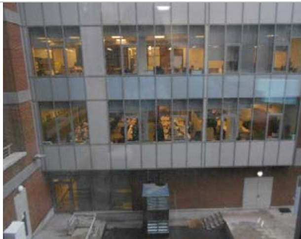
Фото 332. Помещения 3-го этажа
