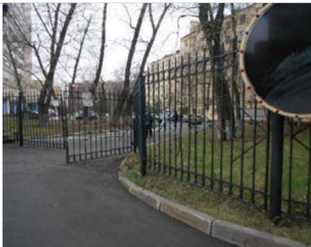
Фото 14. Фасад, подъездные пути
