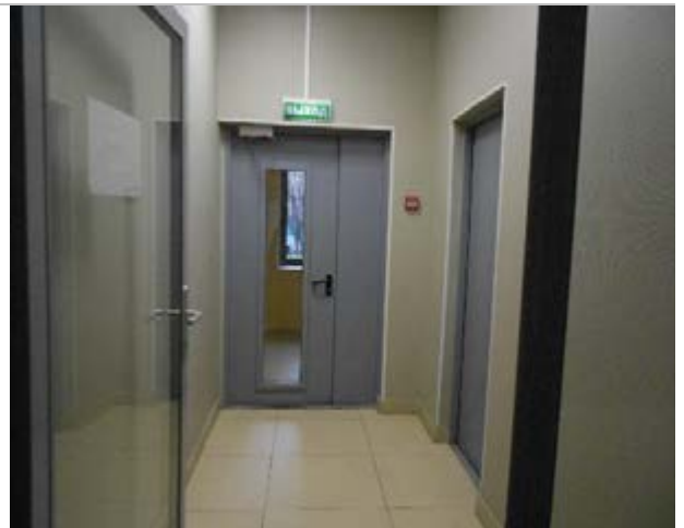
Фото 285. Помещения 2-го этажа
