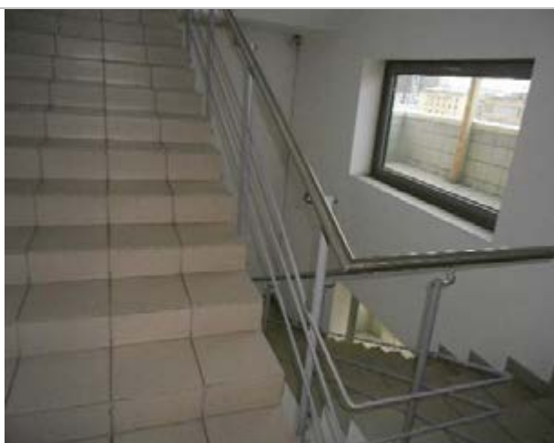
Фото 124. Помещения 7-го этажа
