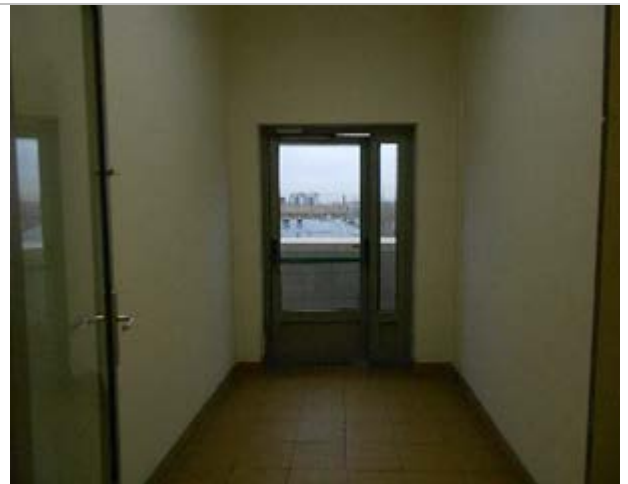
Фото 46. Помещения 6-го этажа
