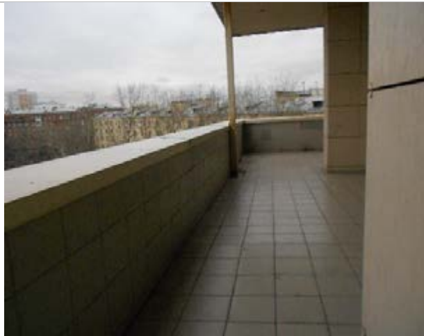
Фото 47. Помещения 6-го этажа
