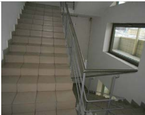
Фото 74. Помещения 6-го этажа
