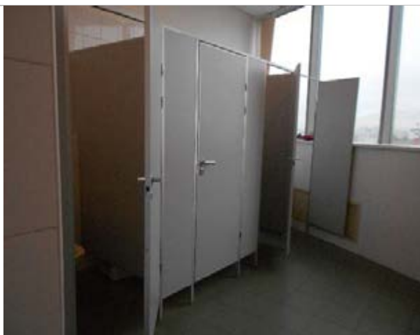
Фото 246. Помещения 9-го этажа
