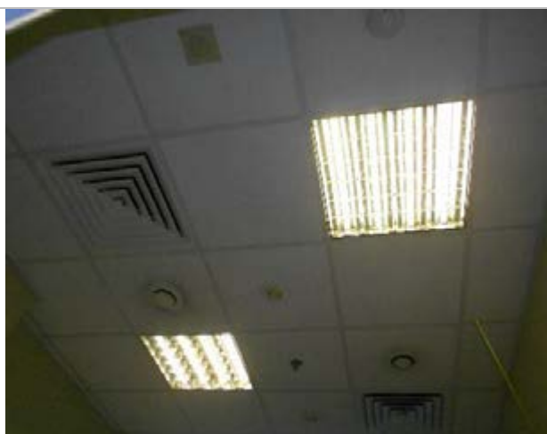
Фото 111. Помещения 7-го этажа
