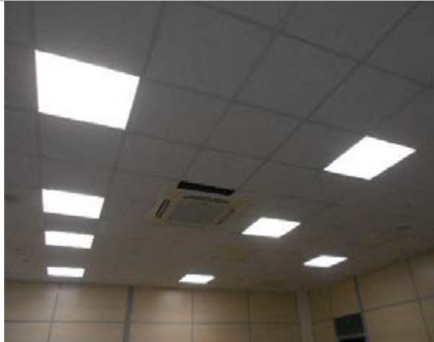
Фото 318. Помещения 3-го этажа
