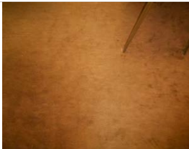
Фото 110. Помещения 7-го этажа
