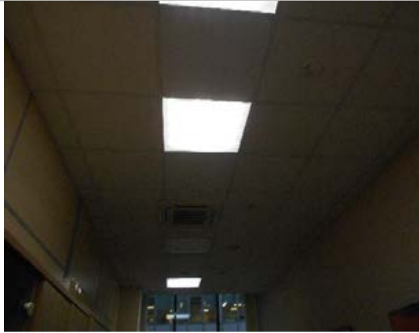
Фото 330. Помещения 3-го этажа
