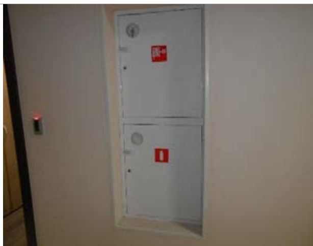
Фото 328. Помещения 3-го этажа
