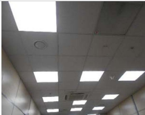
Фото 272. Помещения 2-го этажа
