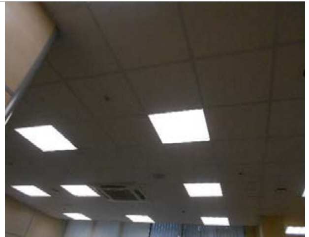
Фото 359. Помещения 4-го этажа
