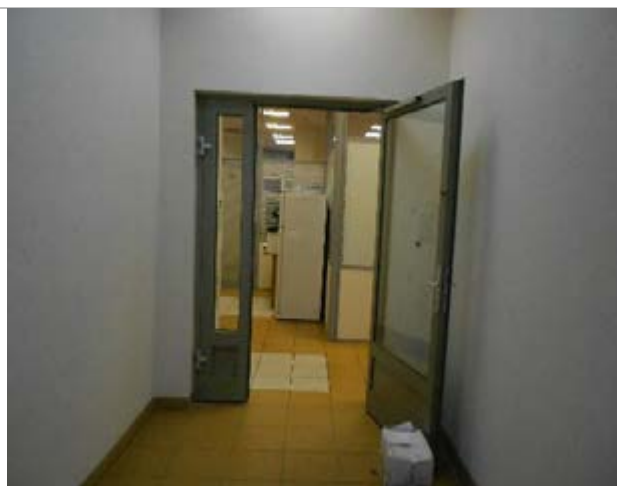
Фото 53. Помещения 6-го этажа
