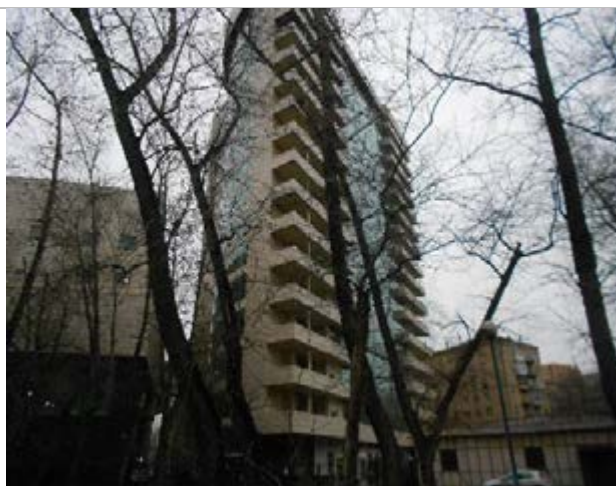
Фото 17. Фасад, подъездные пути
