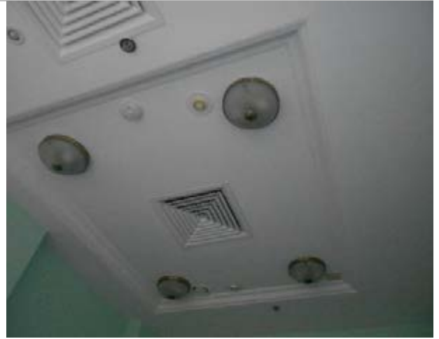
Фото 212. Помещения 9-го этажа
