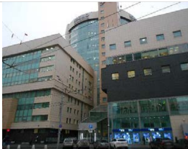
Фото 4. Фасад, подъездные пути
