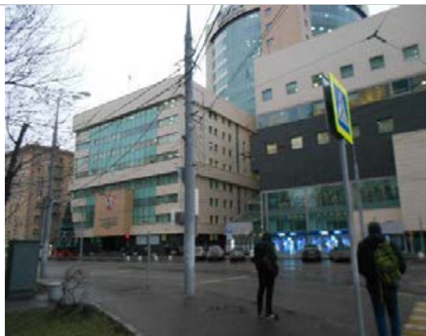
Фото 2. Фасад, подъездные пути
