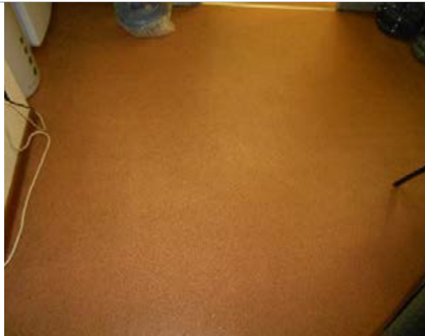
Фото 131. Помещения 7-го этажа
