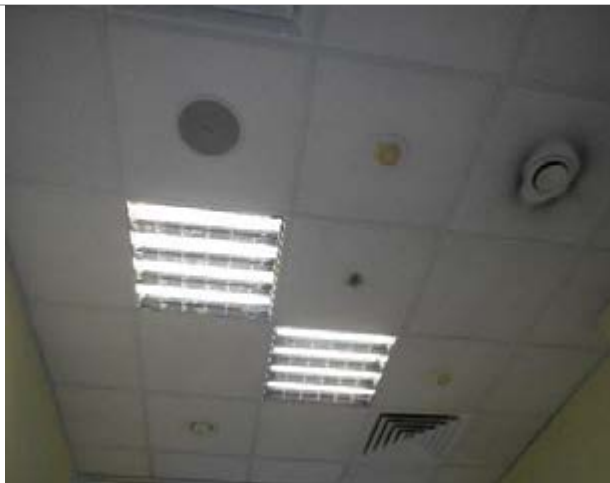
Фото 174. Помещения 8-го этажа
