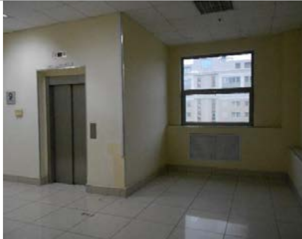
Фото 199. Помещения 9-го этажа
