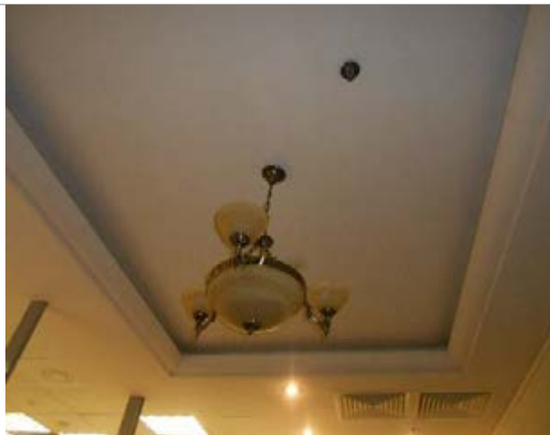
Фото 215. Помещения 9-го этажа
