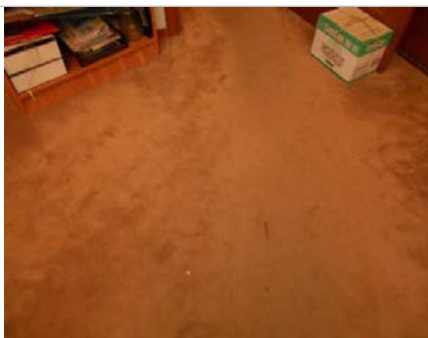
Фото 243. Помещения 9-го этажа
