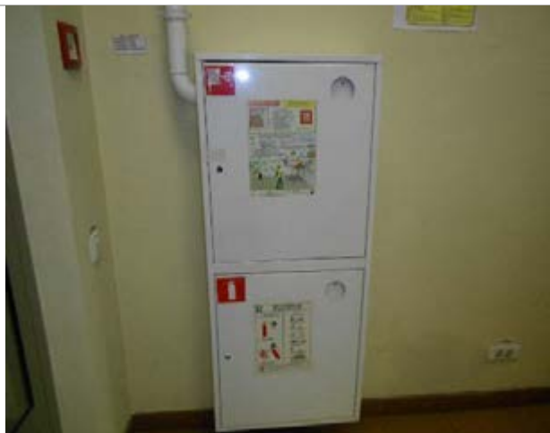
Фото 133. Помещения 7-го этажа
