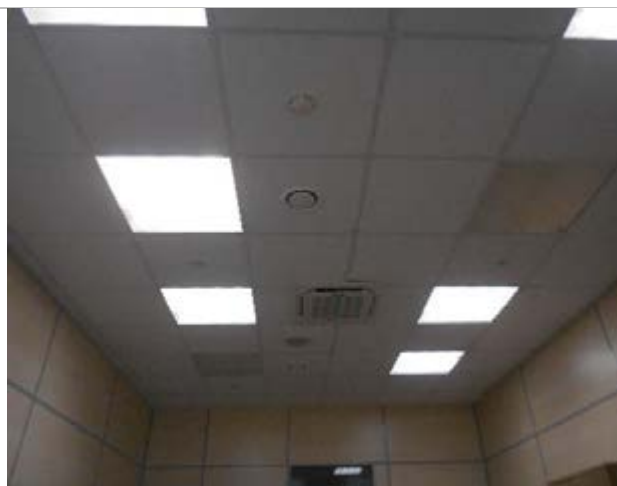
Фото 312. Помещения 3-го этажа
