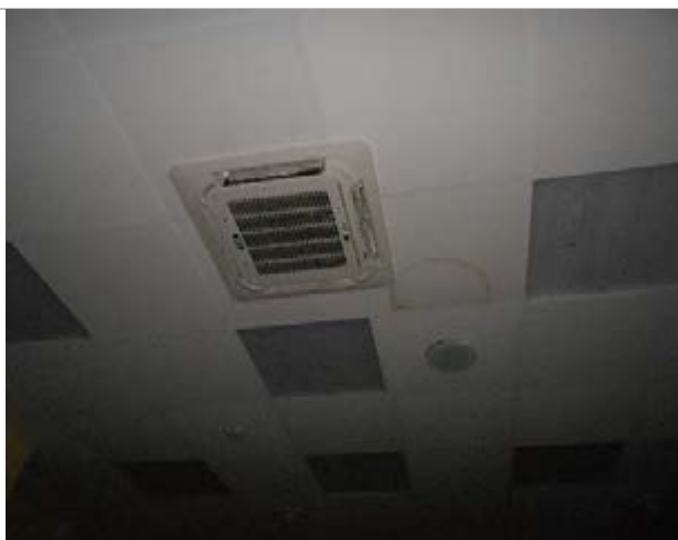
Фото 353. Помещения 4-го этажа
