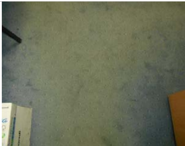
Фото 173. Помещения 8-го этажа
