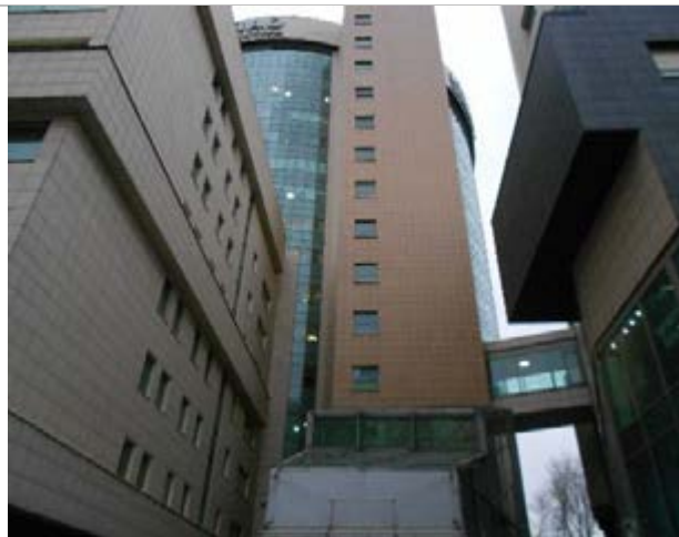
Фото 6. Фасад, подъездные пути
