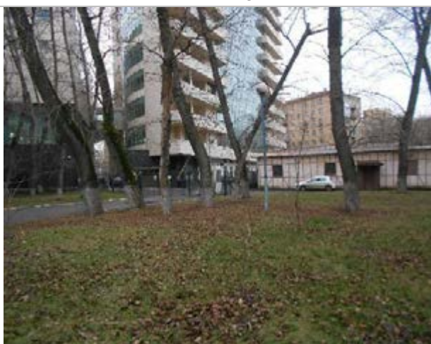
Фото 16. Фасад, подъездные пути
