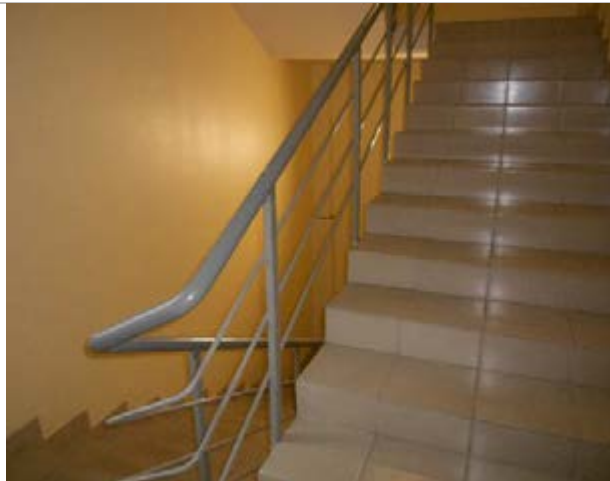
Фото 286. Помещения 2-го этажа
