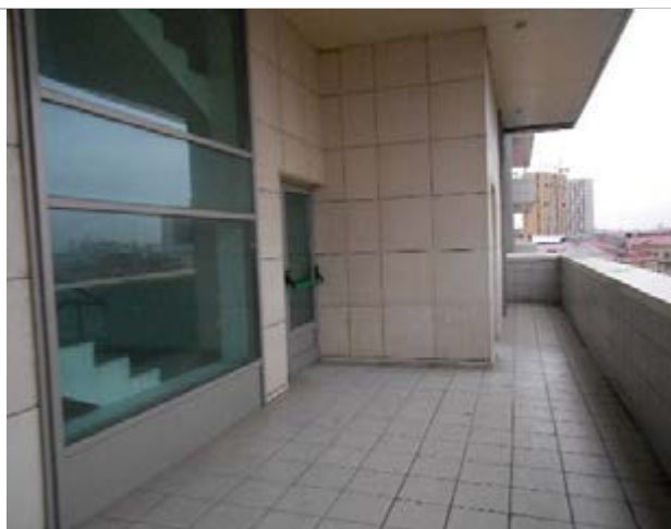
Фото 181. Помещения 8-го этажа
