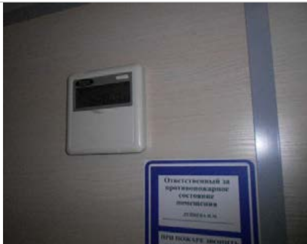
Фото 308. Помещения 3-го этажа
