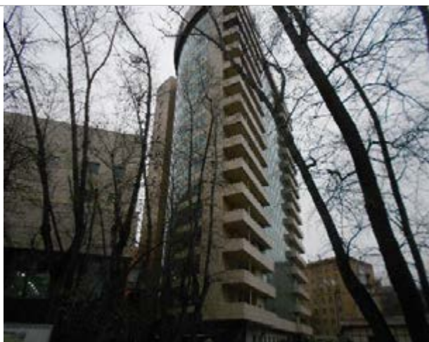
Фото 18. Фасад, подъездные пути
