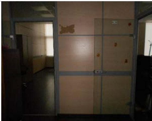
Фото 305. Помещения 3-го этажа
