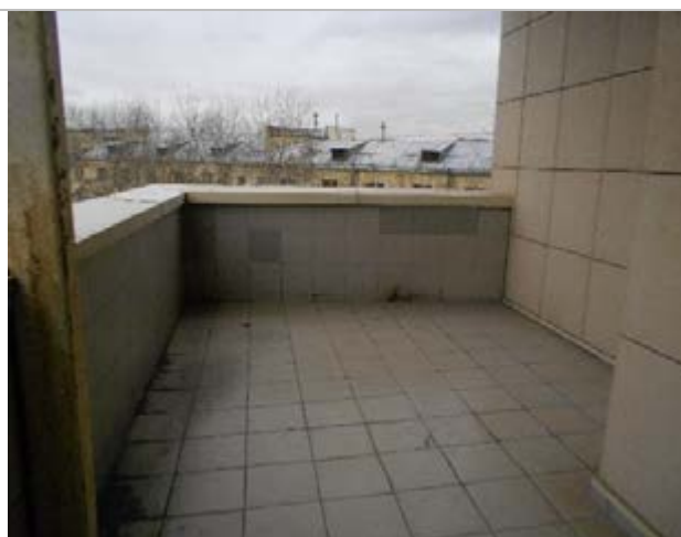
Фото 51. Помещения 6-го этажа
