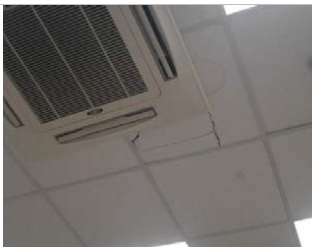
Фото 278. Помещения 2-го этажа
