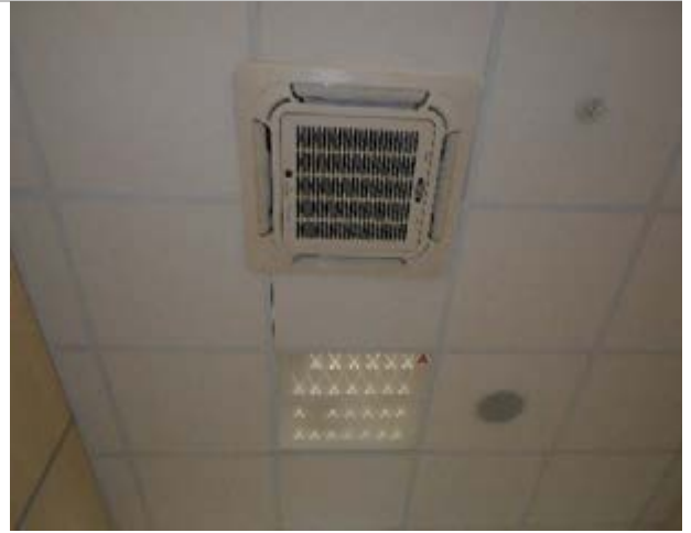
Фото 331. Помещения 3-го этажа
