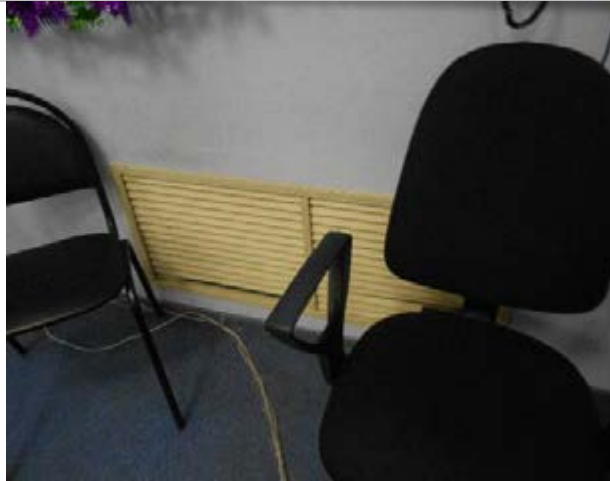
Фото 163. Помещения 8-го этажа
