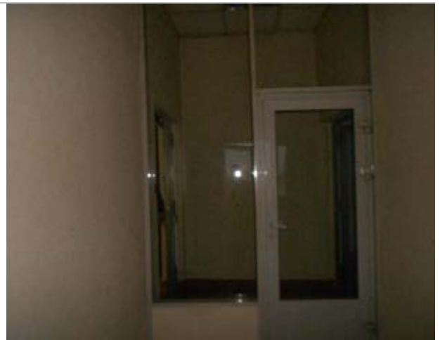
Фото 82. Помещения 6-го этажа
