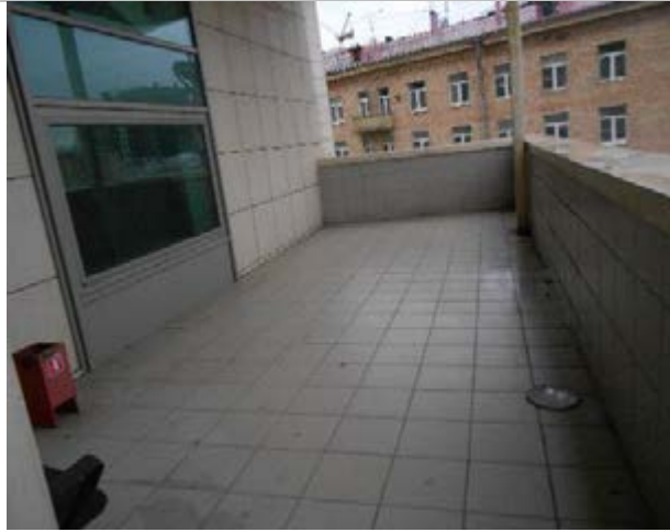
Фото 79. Помещения 6-го этажа
