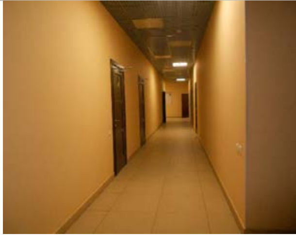
Фото 354. Помещения 4-го этажа
