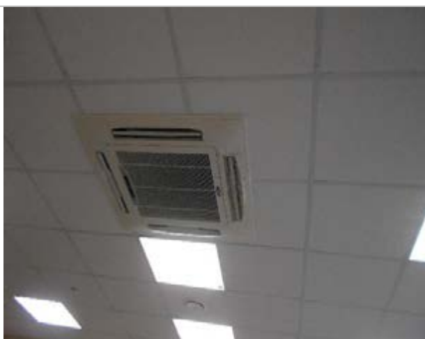
Фото 363. Помещения 4-го этажа
