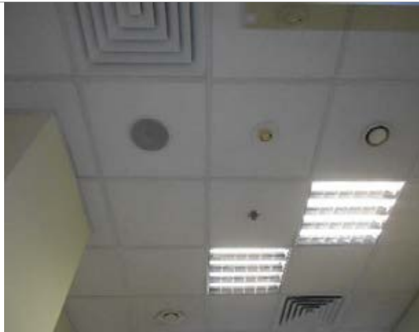
Фото 191. Помещения 8-го этажа
