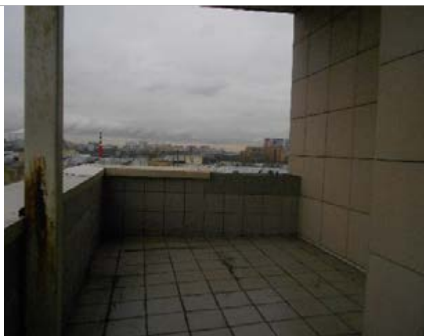
Фото 137. Помещения 7-го этажа
