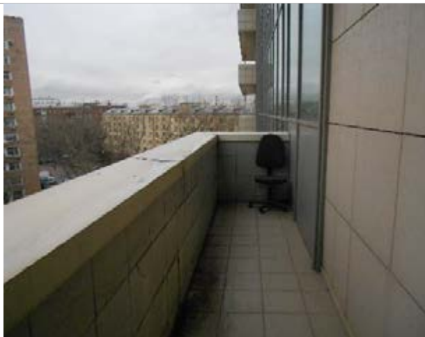
Фото 78. Помещения 6-го этажа
