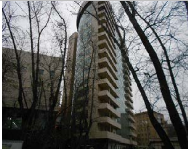
Фотография 3. Внешний вид здания
