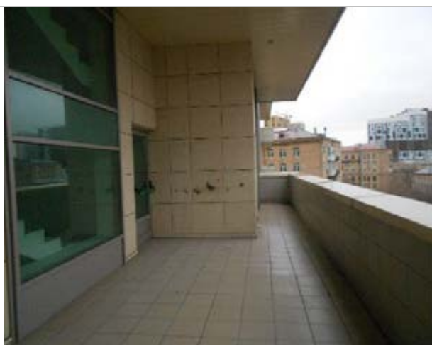
Фото 52. Помещения 6-го этажа
