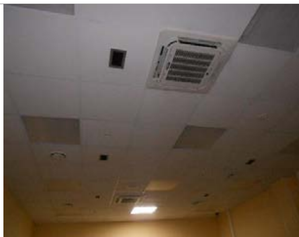
Фото 372. Помещения 4-го этажа
