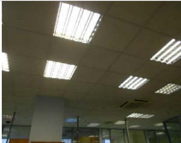
Фото 167. Помещения 8-го этажа
