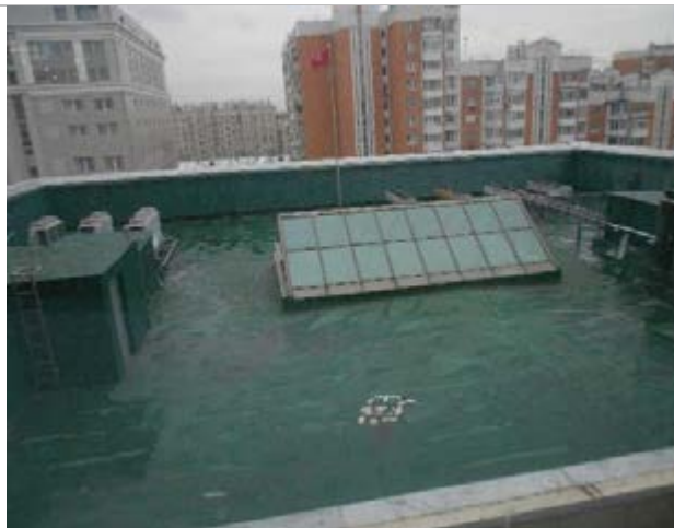
Фото 221. Помещения 9-го этажа
