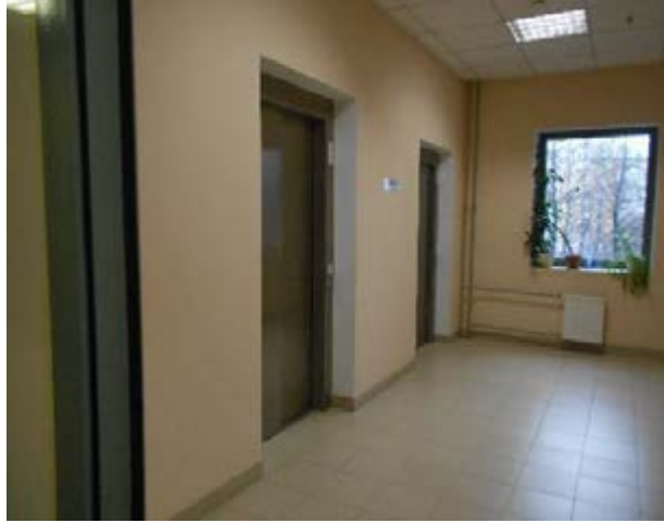
Фото 342. Помещения 4-го этажа
