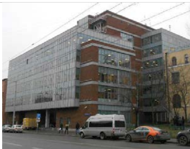
Фото 252. Фасад, подъездные пути
