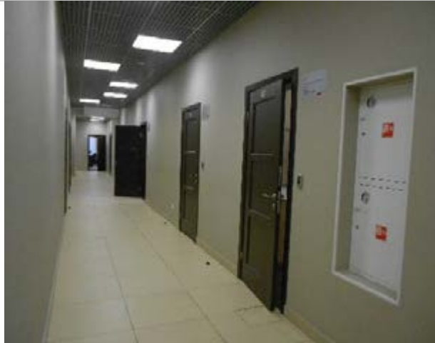
Фотография 25. Внутреннее состояние помещений — 2 этаж
