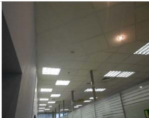
Фото 158. Помещения 8-го этажа
