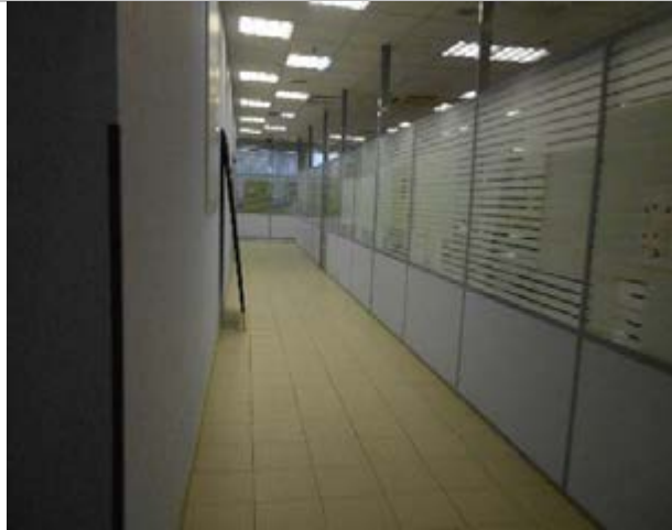
Фотография 13. Внутреннее состояние помещений — 8 этаж
