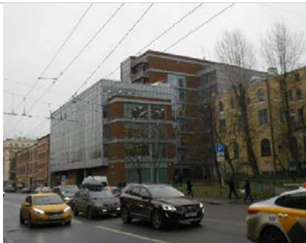
Фото 250. Фасад, подъездные пути
