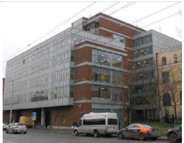
Фото 251. Фасад, подъездные пути
