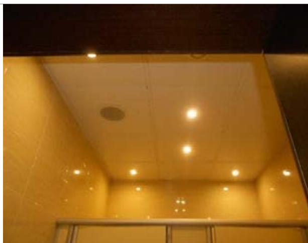
Фото 340. Помещения 3-го этажа
