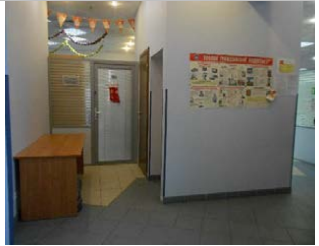
Фото 152. Помещения 8-го этажа
