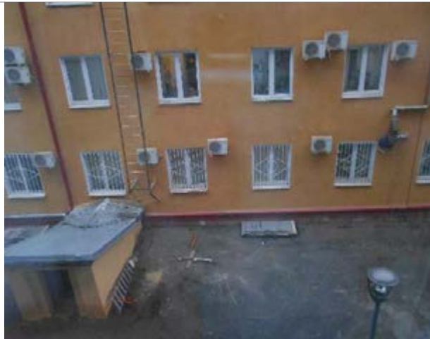
Фото 310. Помещения 3-го этажа
