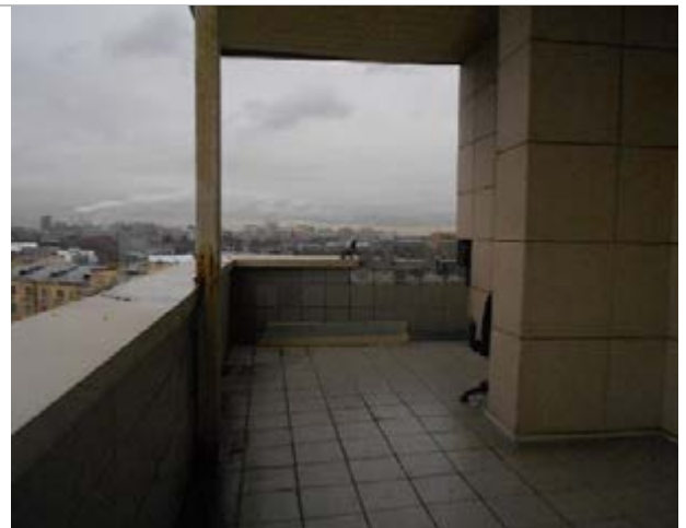
Фото 180. Помещения 8-го этажа
