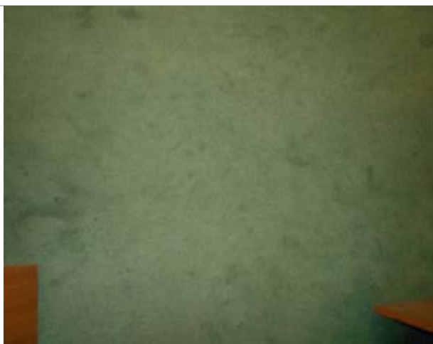
Фото 234. Помещения 9-го этажа
