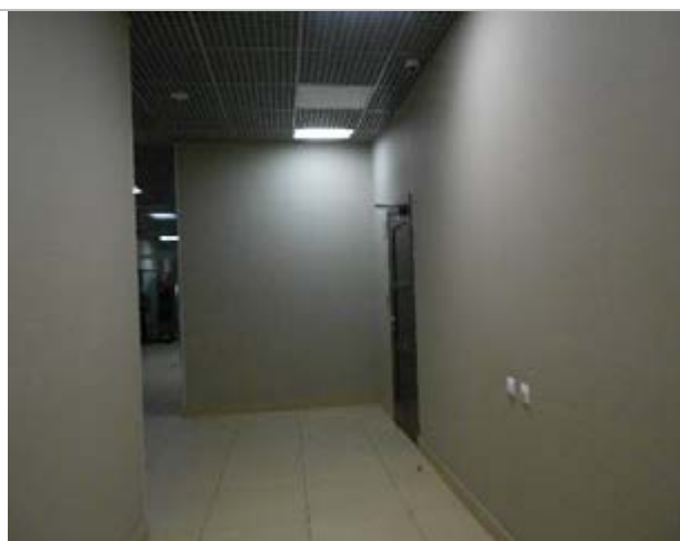
Фото 279. Помещения 2-го этажа
