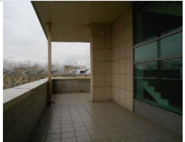
Фото 48. Помещения 6-го этажа
