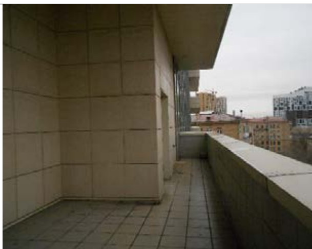
Фото 138. Помещения 7-го этажа
