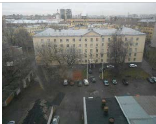
Фото 112. Помещения 7-го этажа
