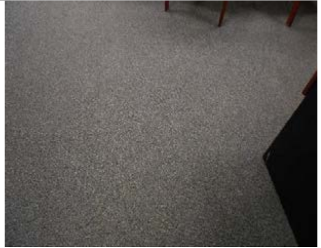
Фото 271. Помещения 2-го этажа
