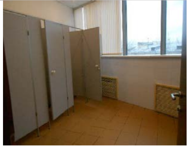
Фото 44. Помещения 6-го этажа
