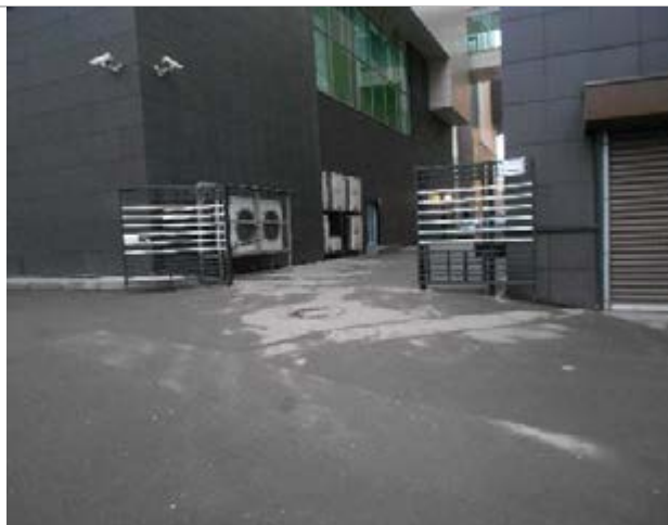
Фото 13. Фасад, подъездные пути
