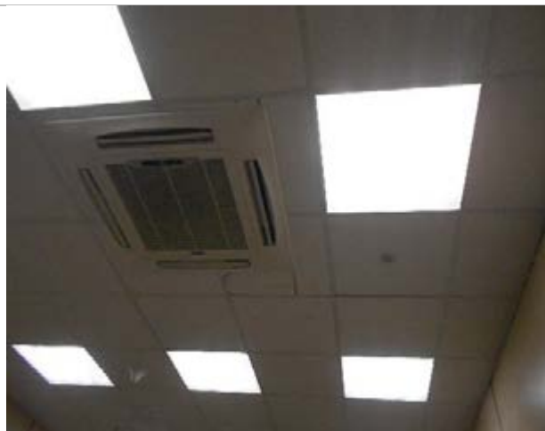
Фото 277. Помещения 2-го этажа
