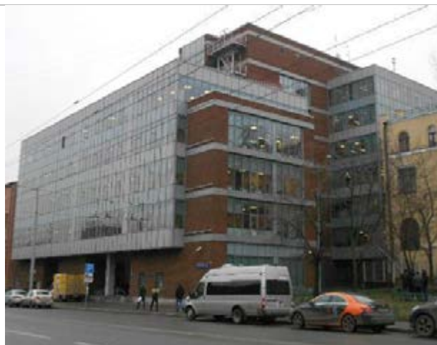
Фотография 22. Внешний вид здания
