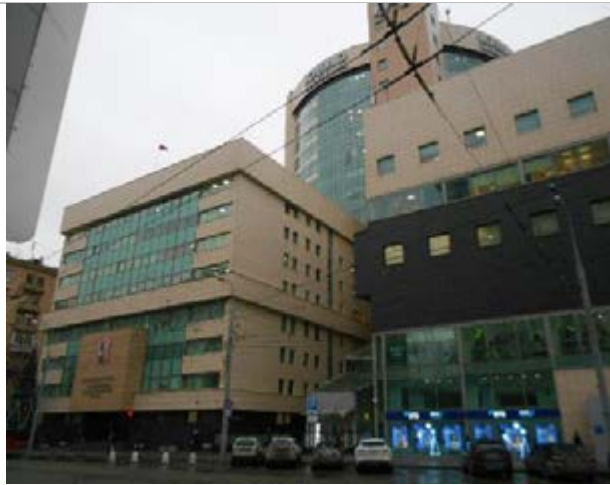
Фотография 1. Внешний вид здания
