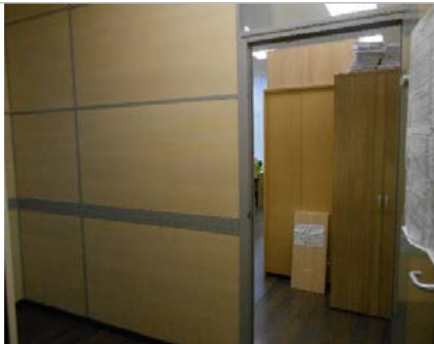
Фото 356. Помещения 4-го этажа
