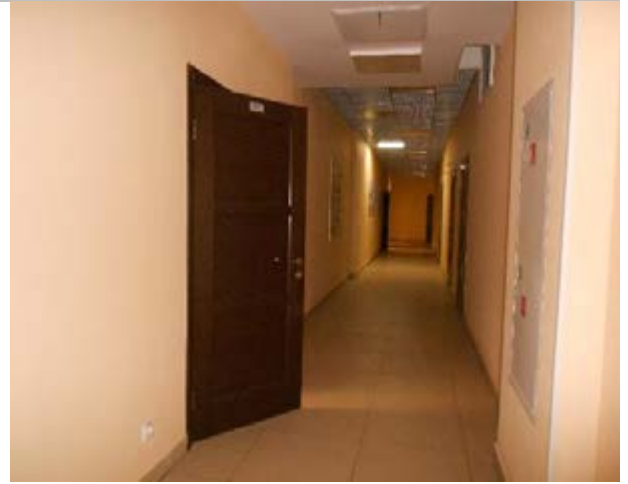
Фото 355. Помещения 4-го этажа
