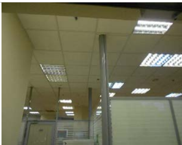
Фото 54. Помещения 6-го этажа
