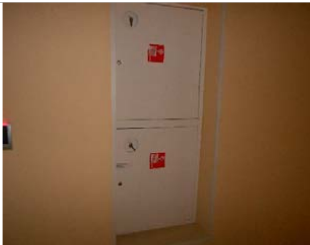
Фото 377. Помещения 4-го этажа
