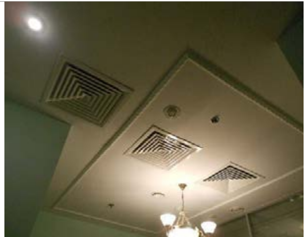
Фото 240. Помещения 9-го этажа
