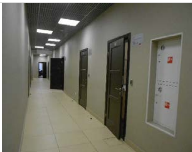
Фото 266. Помещения 2-го этажа
