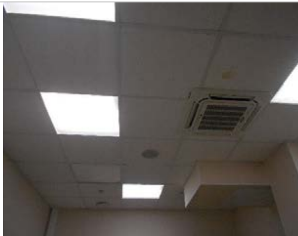
Фото 296. Помещения 3-го этажа
