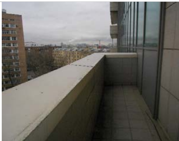
Фото 121. Помещения 7-го этажа
