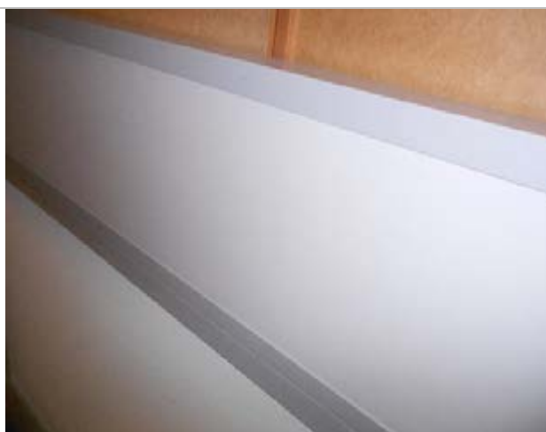
Фото 207. Помещения 9-го этажа
