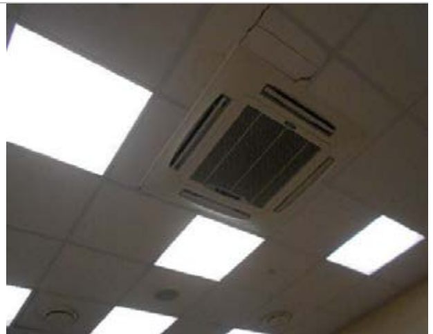
Фото 273. Помещения 2-го этажа
