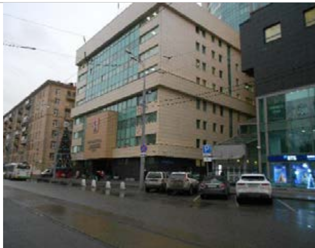
Фото 5. Фасад, подъездные пути
