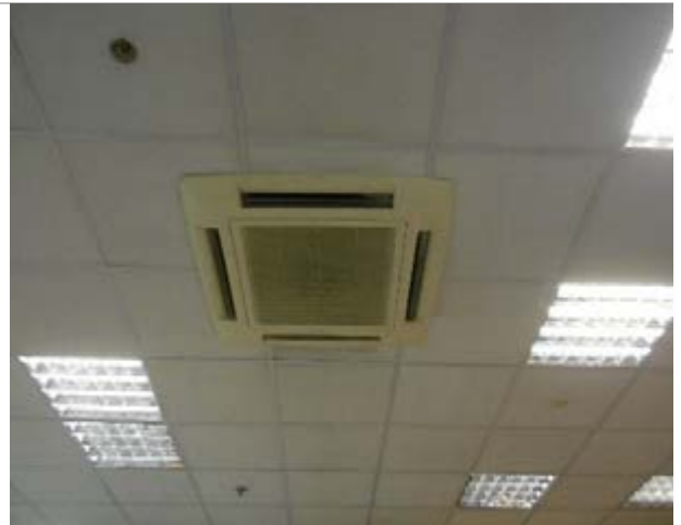
Фото 168. Помещения 8-го этажа
