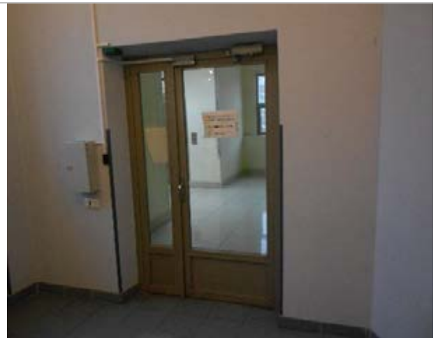
Фото 154. Помещения 8-го этажа
