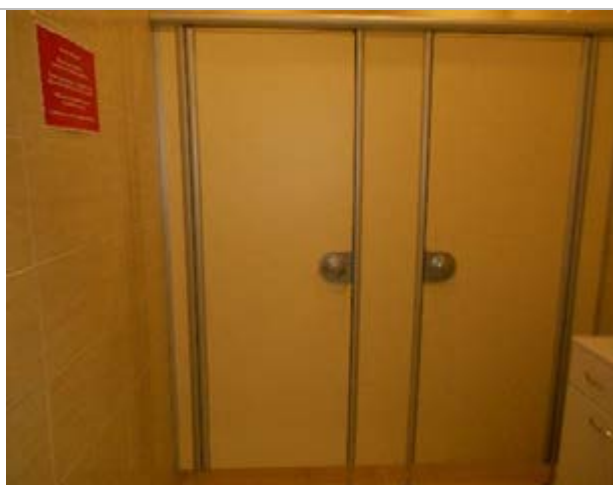
Фото 338. Помещения 3-го этажа
