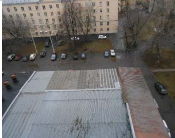
Фото 139. Помещения 7-го этажа
