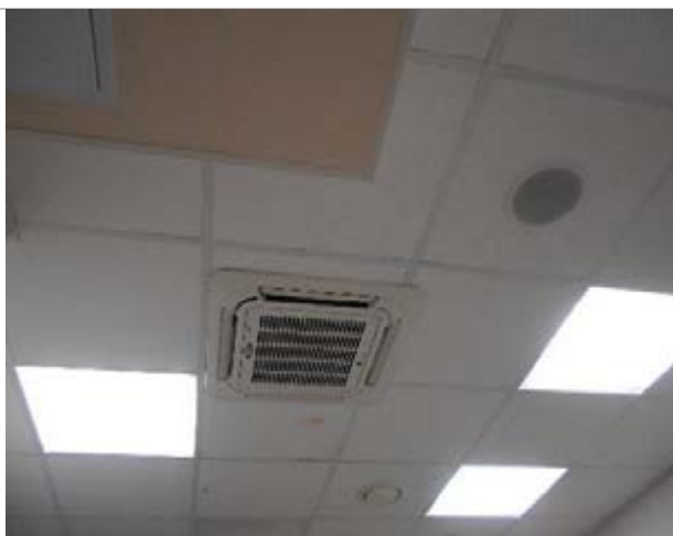
Фото 301. Помещения 3-го этажа
