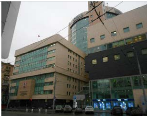
Фото 3. Фасад, подъездные пути
