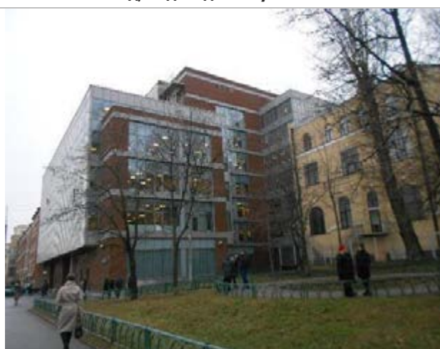
Фото 254. Фасад, подъездные пути
