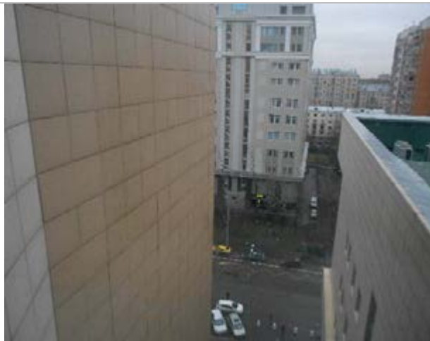
Фото 225. Помещения 9-го этажа
