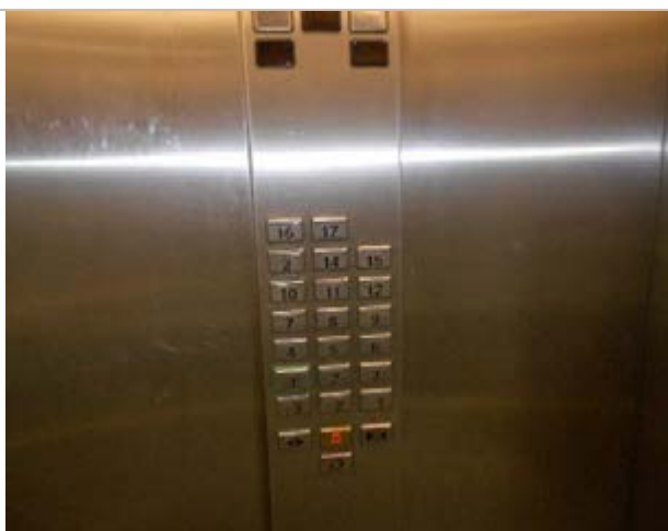
Фото 148. Помещения 8-го этажа
