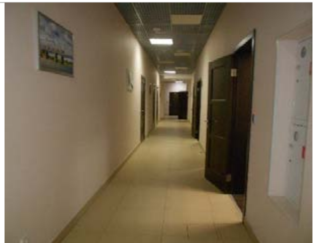
Фото 323. Помещения 3-го этажа
