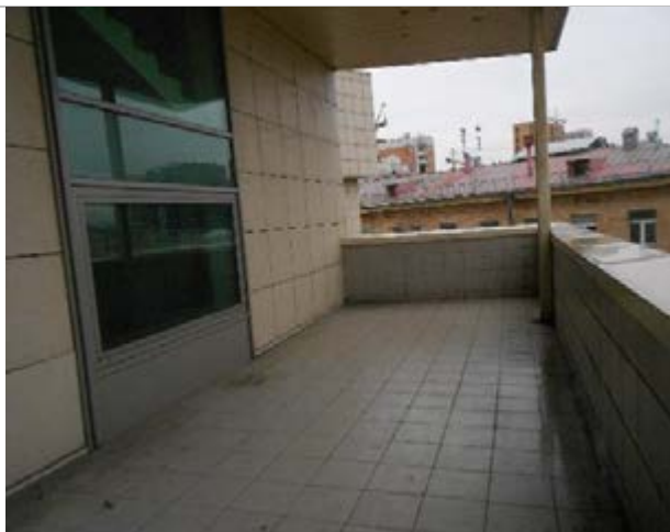
Фото 122. Помещения 7-го этажа
