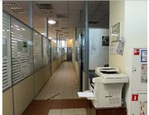
Фотография 10. Внутреннее состояние помещений — 7 этаж
