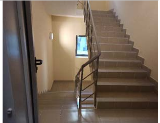
Фотография 34. Внутреннее состояние помещений — 4 этаж
