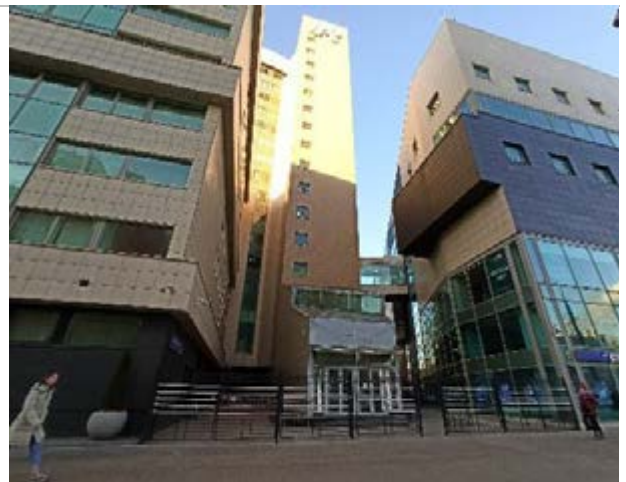
Фотография 2. Внешний вид здания
