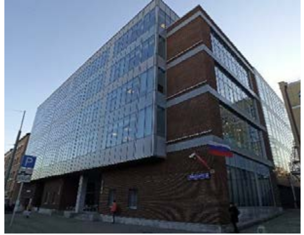
Фотография 22. Внешний вид здания
