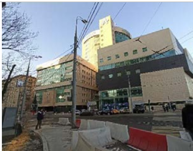
Фотография 3. Внешний вид здания
