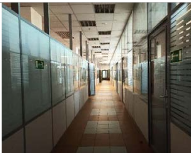
Фотография 8. Внутреннее состояние помещений — 6 этаж
