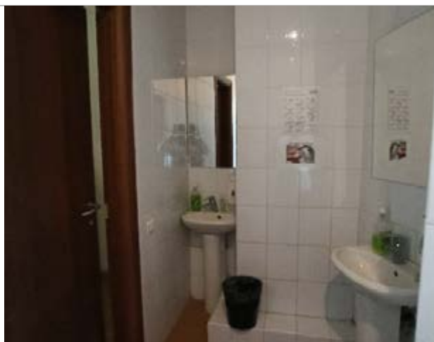
Фотография 7. Внутреннее состояние помещений — 6 этаж
