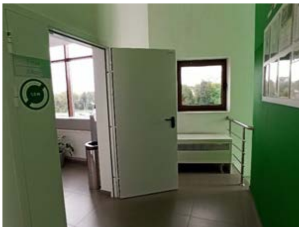
Фото 44. Внутреннее состояние помещений, расположенных на 3 этаже
