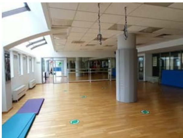
Фото 51. Внутреннее состояние помещений, расположенных на 3 этаже
