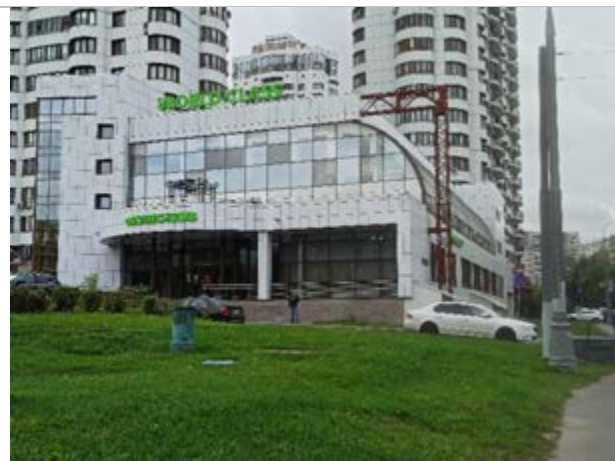
Фотография 3.1. Внешний вид здания
