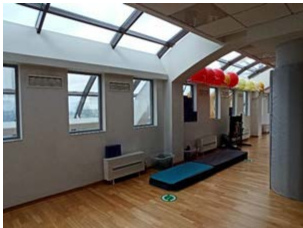
Фото 49. Внутреннее состояние помещений, расположенных на 3 этаже
