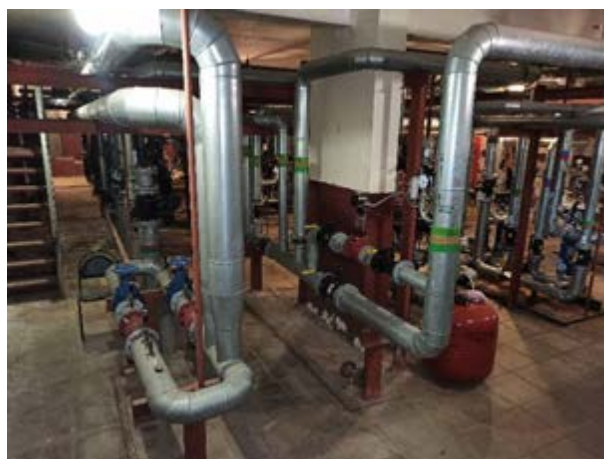
Фото 18. Внутреннее состояние помещений, расположенных на 1 этаже
