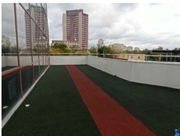
Фото 34. Внутреннее состояние помещений, расположенных на 2 этаже
