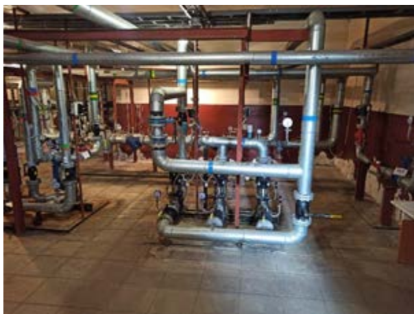
Фото 20. Внутреннее состояние помещений, расположенных на 1 этаже
