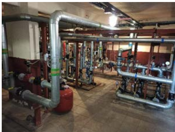
Фото 19. Внутреннее состояние помещений, расположенных на 1 этаже
